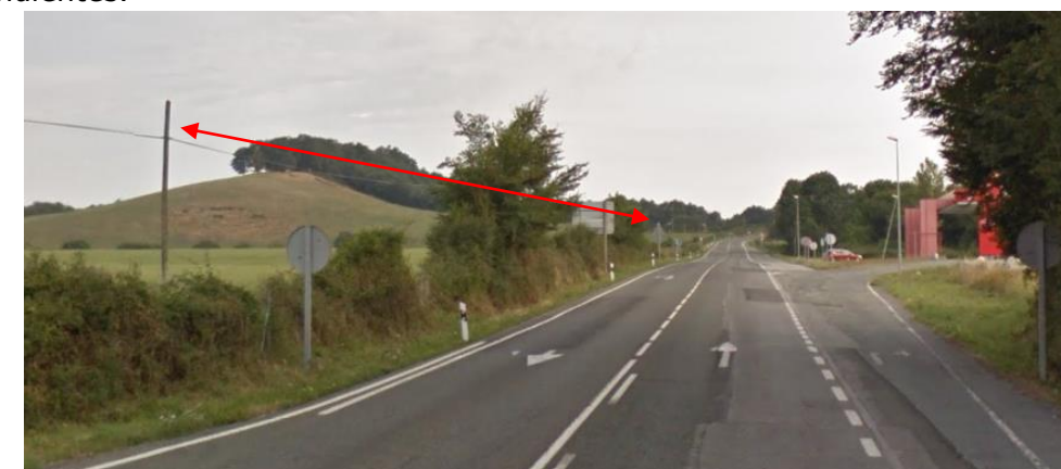
Imagen 1- Inicio tramo (PK 22+500) afección línea telefónica aérea y postes
