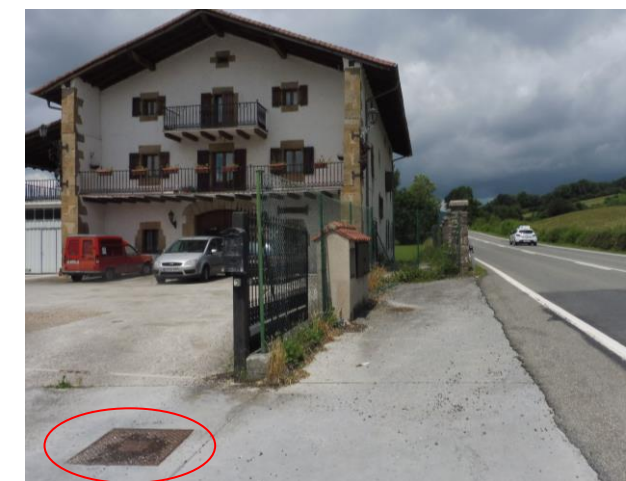
Imagen 6- Arqueta a recrecer correspondiente a canalización de línea eléctrica de BT
