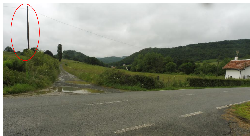
Imagen 1- Poste de madera telefónico a desplazar ubicado en la NA-4230 a la que se accede desde el PK 25+000.
