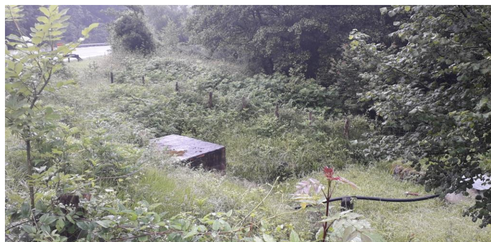
Imagen 7- Caseta de bombeo correspondiente a la Red de Abastecimiento a Oronoz
