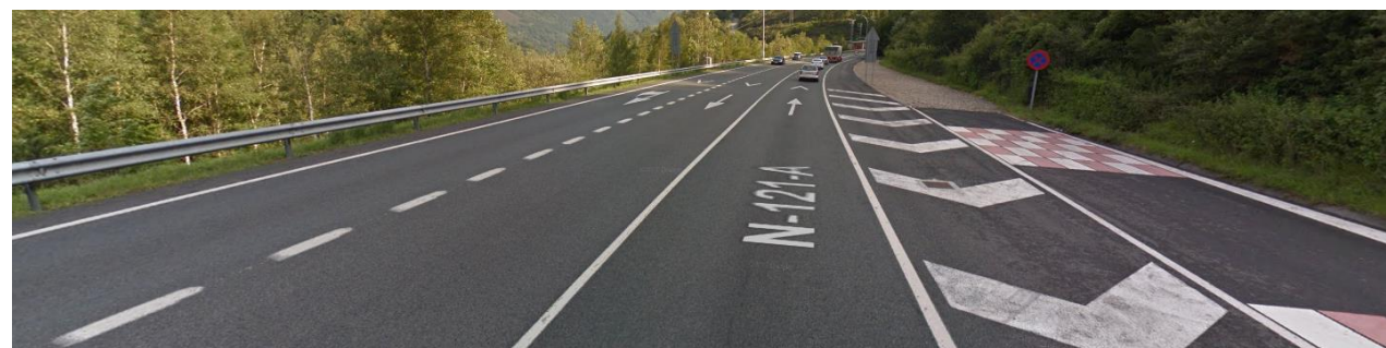
Imagen 5: Fotografía de la zona en estudio, se puede apreciar la arqueta situada encima del cebreado, a su izquierda un carril de circulación y a la derecha el carril de frenado de emergencia.
