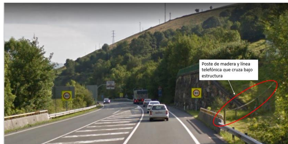
Imagen 5- Cruce de línea telefónica bajo estructura PK 34+400
