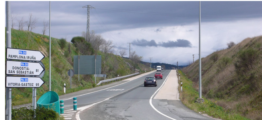
FOTO 4. VISTA DE LA CARRETERA PA-30 EN LA ZONA DE UBICACIÓN DE LA PASARELA.
