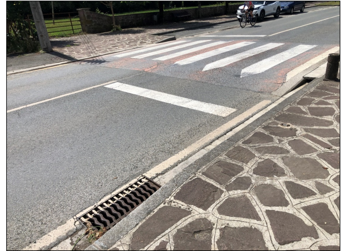
Imagen 11. Detalle de rejilla existente sobre la carretera NA-8307
