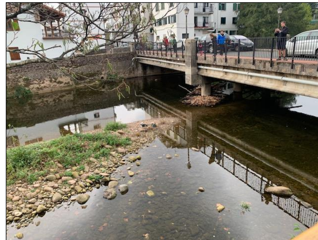
Imagen 16. Vista aguas abajo Puente Giltxaurdi (Fuente: Elaboración propia)
