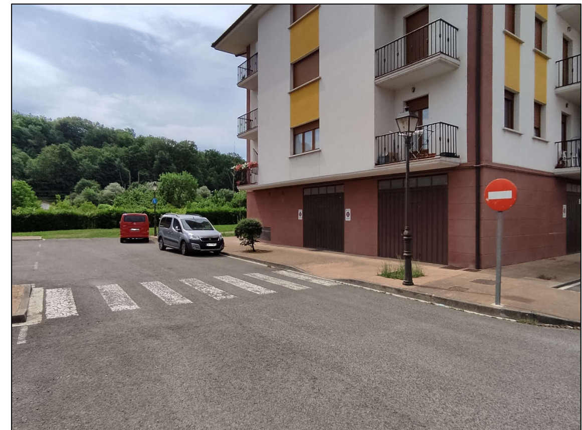
Imagen 5. Acera que será ampliada para permitir el paso de vehículos a los garajes (Fuente: Elaboración propia)
