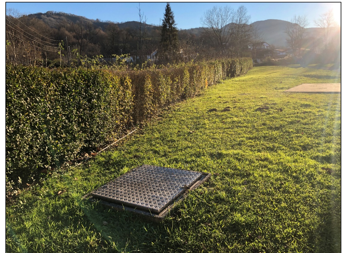
Imagen 9. Tapa del pozo arenoso situado en la margen derecha del río Baztán.
