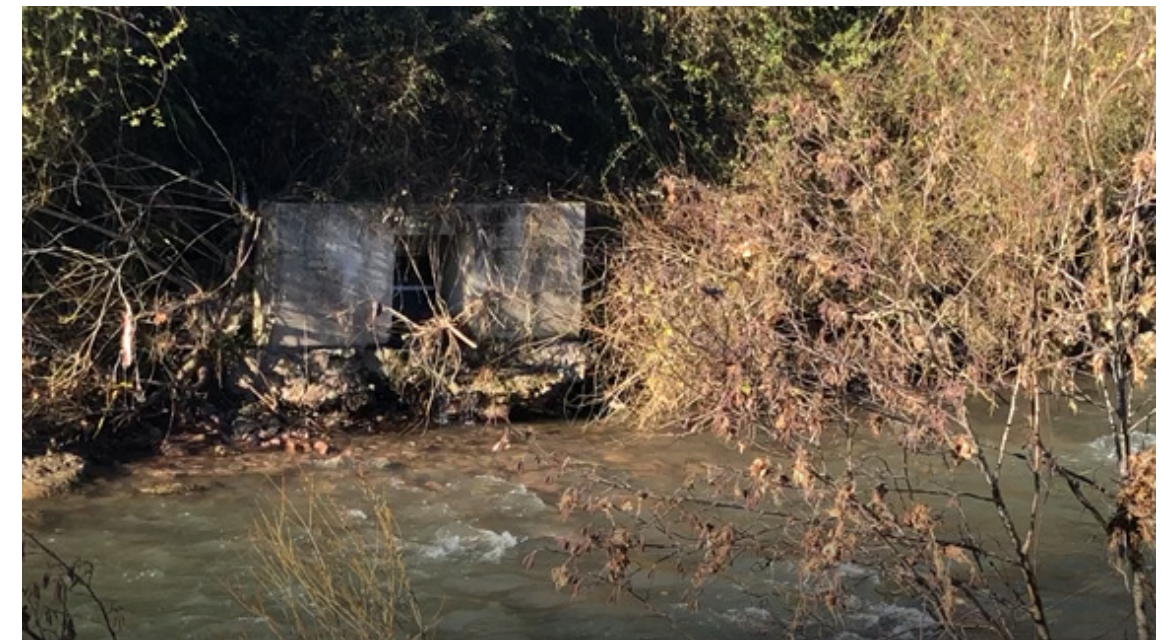
Imagen 12. Desagüe existente al cauce
