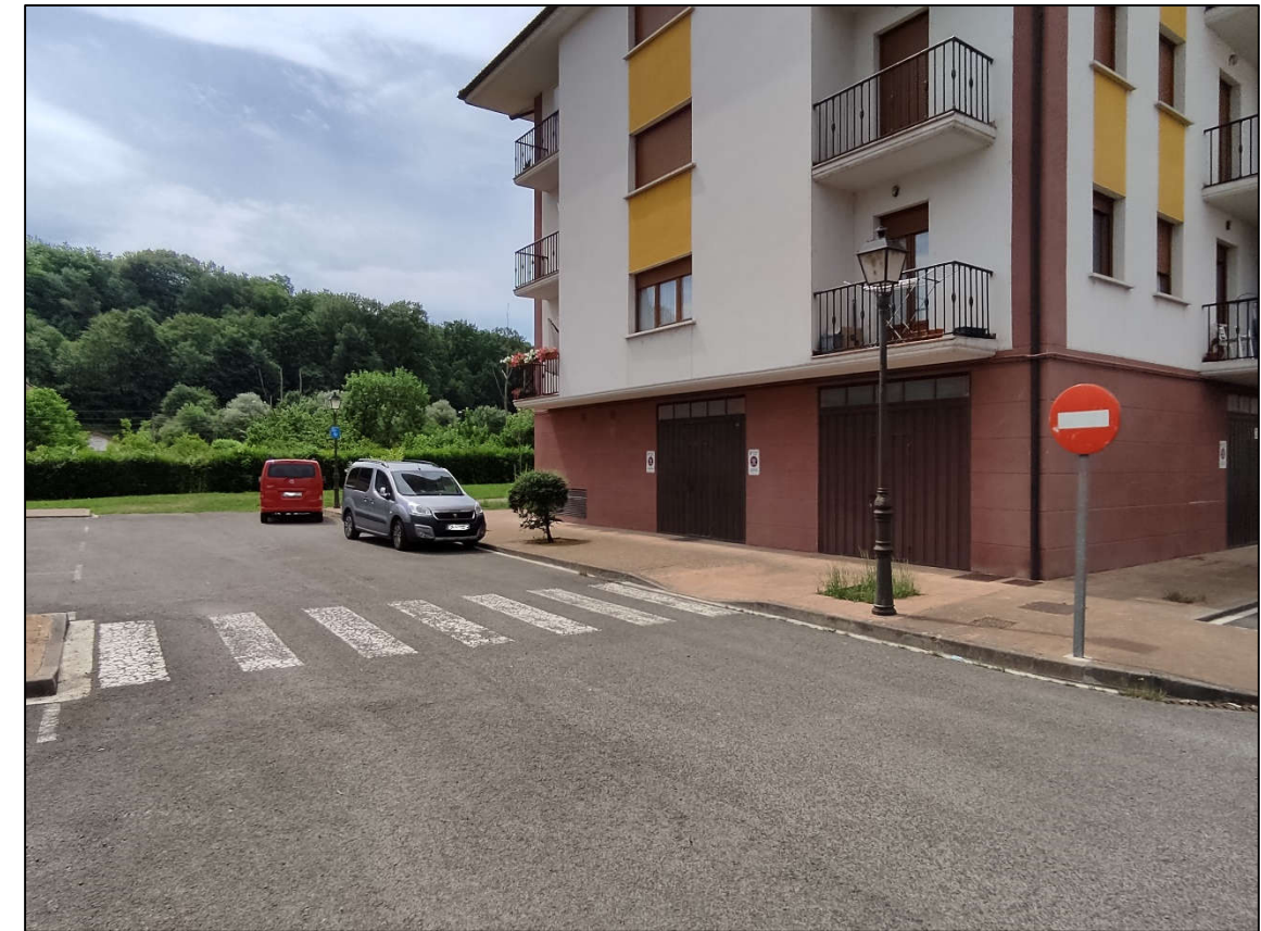
Imagen 13. Acera que será ampliada para permitir el paso de vehículos a los garajes (Fuente: Elaboración propia)
