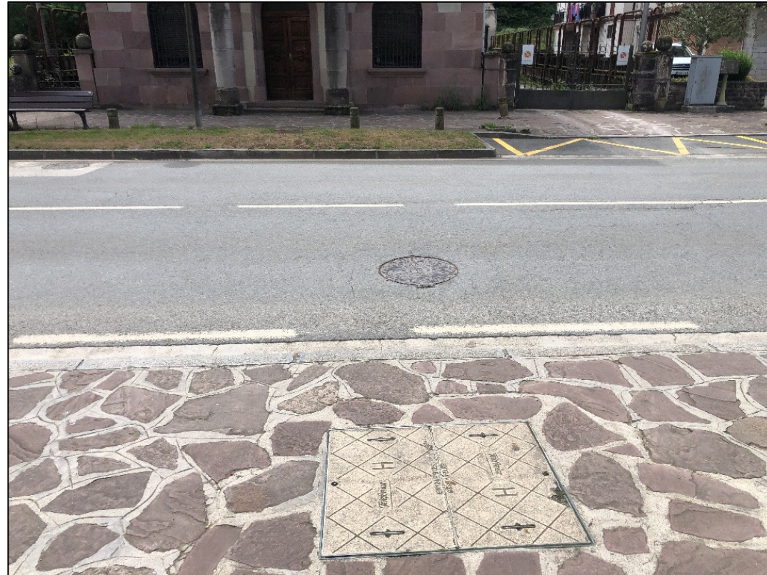
Imagen 13. Arqueta de telefónica existente en la acera.
