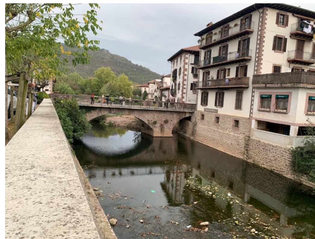
Imagen 17. Vista del Puente Txokoto desde aguas abajo (Fuente: Elaboración propia)
