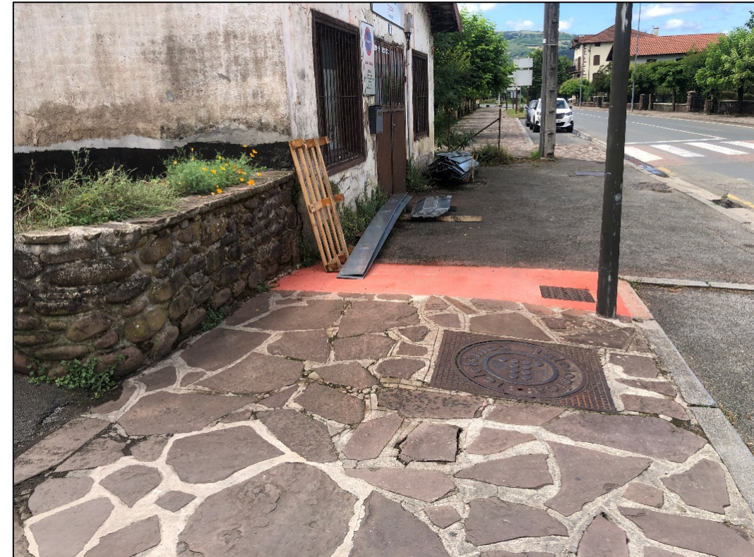
Imagen 14. Arqueta de telefónica existente en la acera.
