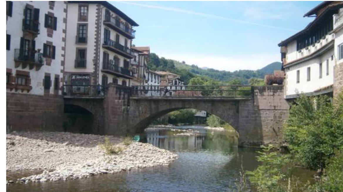
Imagen 20. Vista del Puente Txokoto desde aguas arriba (Fuente: Elaboración propia)
