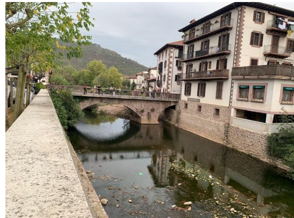
Imagen 21. Vista del Puente Txokoto desde aguas abajo (Fuente: Elaboración propia)
