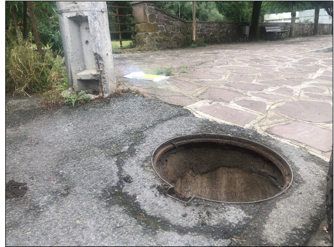
Imagen 8. Pozo de conexión del cruce de la carretera del saneamiento existente
