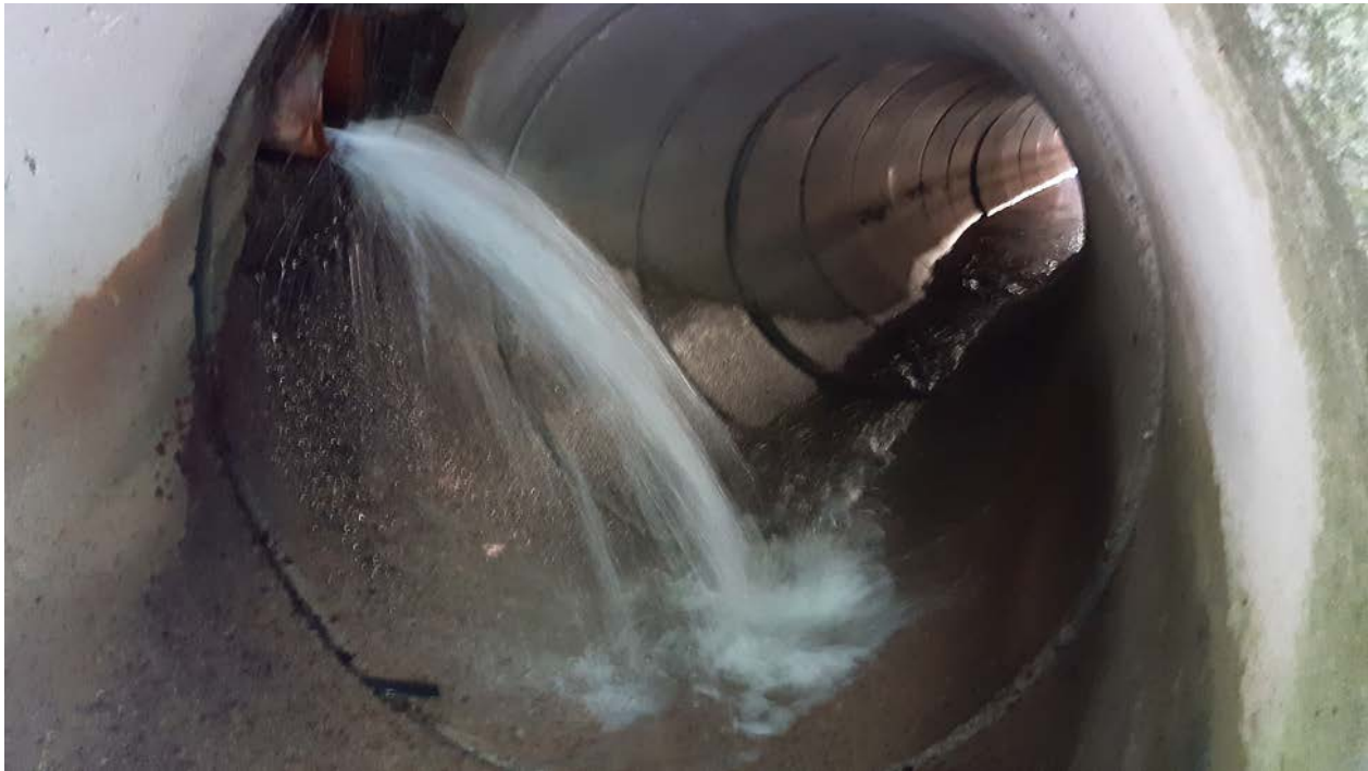
Fotografía 5.5.1.e.- Caudal drenado en la Boca norte del Túnel de Belate por el colector del hastial Este.
