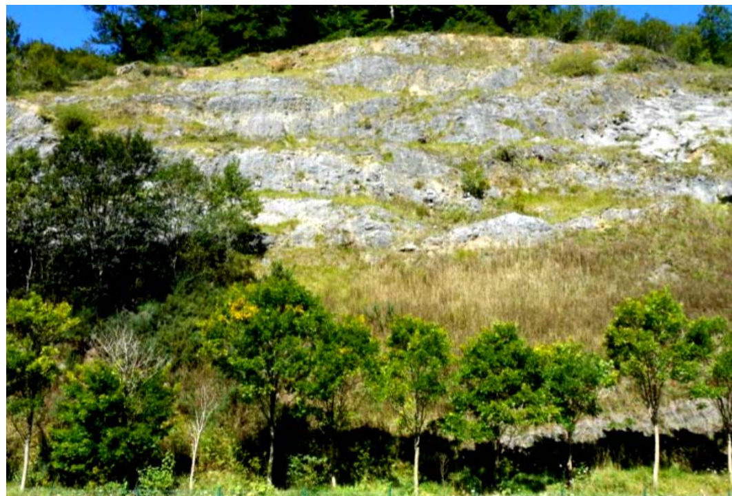
Fotografía 5.2.7.a.- Aspecto de un afloramiento de calizas del Muschelkalk en la boca sur del actual Túnel de Belate.
