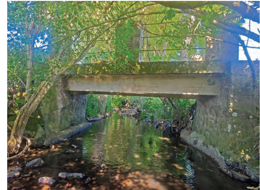
Figura 27. Regata Zaldazain: puente de escaso valor para la fauna. Fuente: Equipo redactor.
