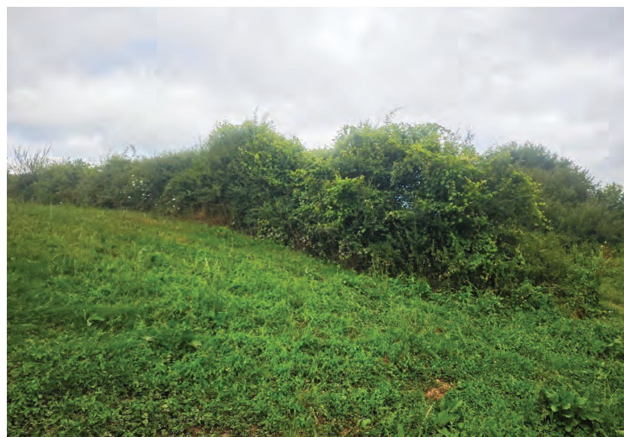
Figura 262. Seto vivo afectado. Fuente: Equipo redactor.
