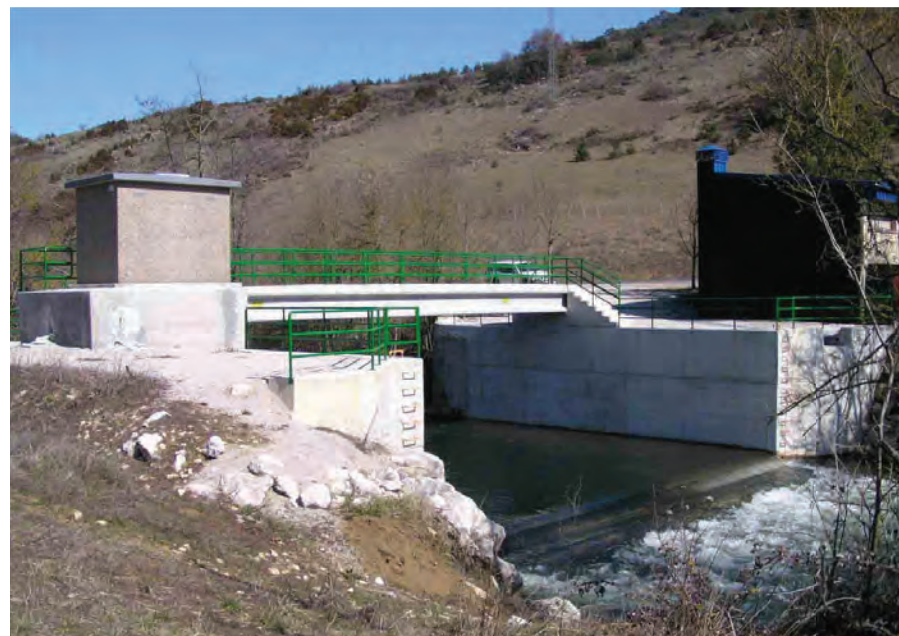
Figura 29. Estación de aforo de Olave en el río Ultzama vista desde la margen derecha. Fuente: SAIH Ebro.
