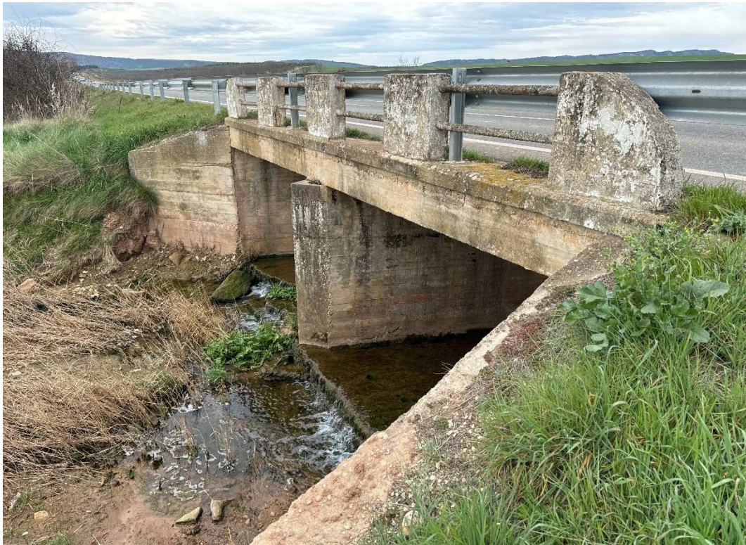
Obra de paso puente doble vano (L=9 m)
