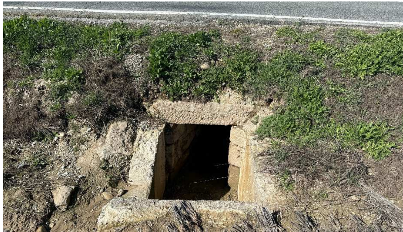
Obra de Fábrica Marco 1000 mm x 700 mm de hormigón.
