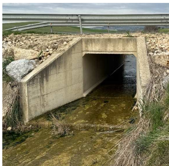
Obra de Fábrica Marco a ampliar en el Pk 2+540
