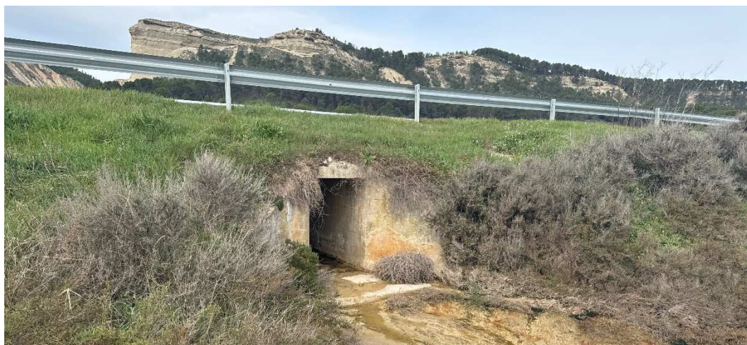
Obra de Fábrica Marco 1000 mm x 1700 mm de hormigón.
