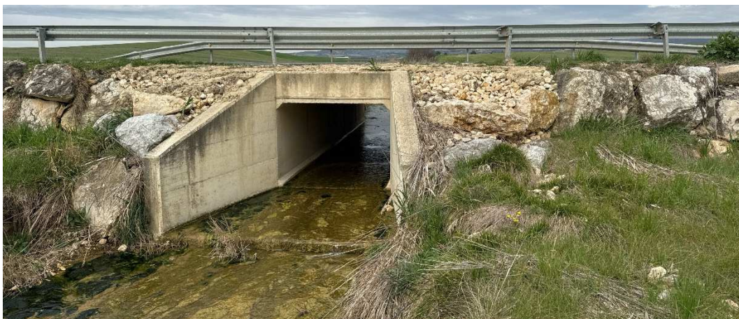
Obra de Fábrica Marco 1500 mm x 2000 mm de hormigón
