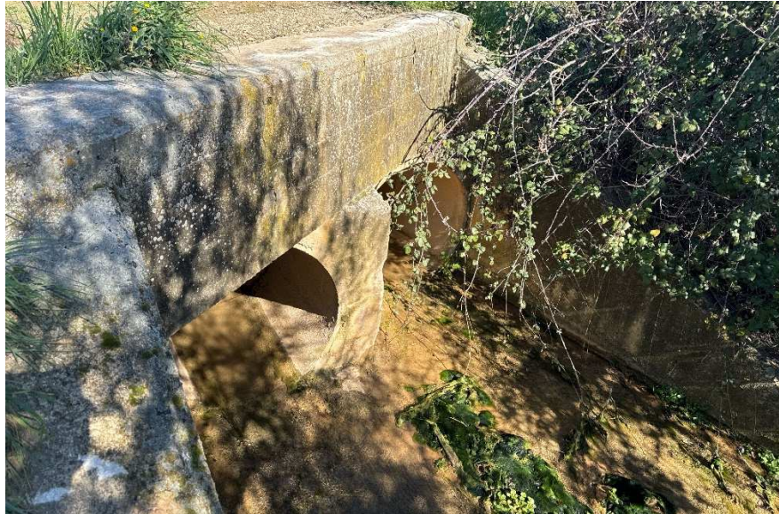
Obra de Fábrica 2xØ 1000 mm de hormigón.
