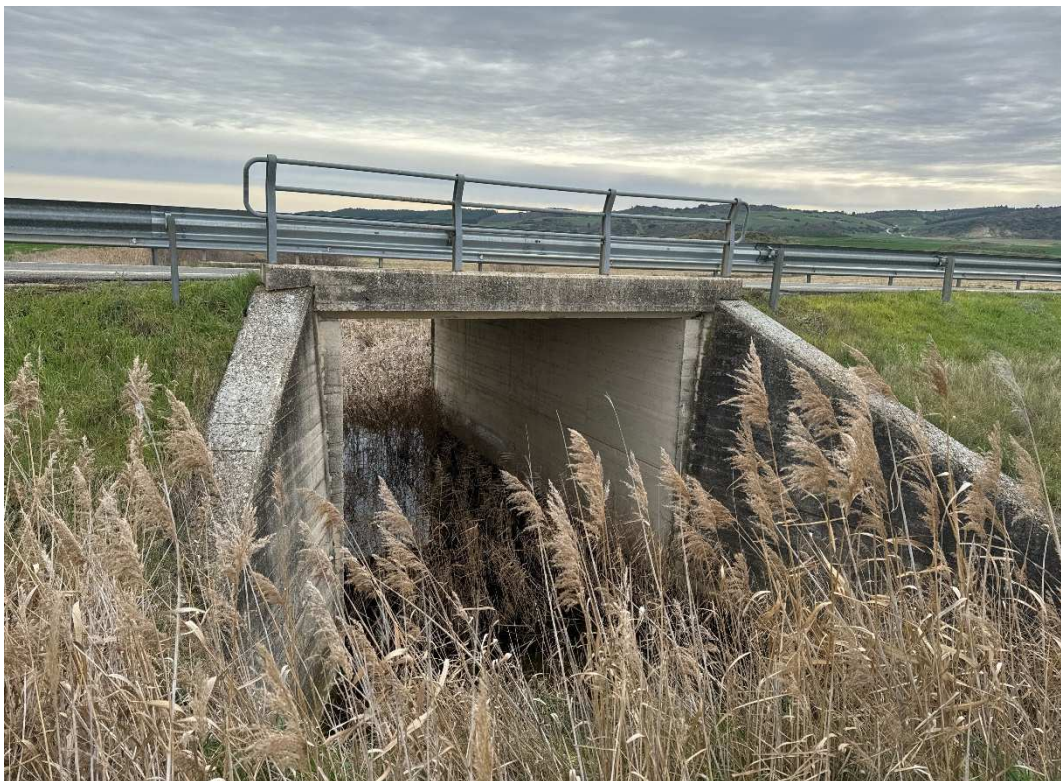
Obra de paso marco 4500mm x 4500mm
