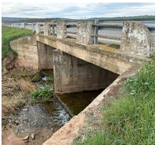
Obra de paso a ampliar en el Pk 5+040
