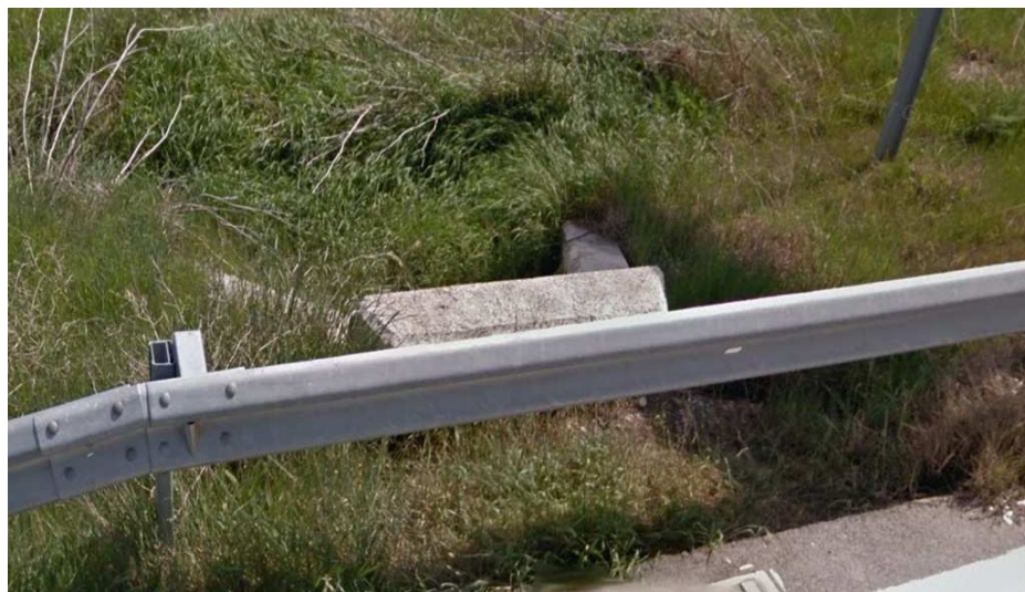
Obra de Fábrica de hormigón junto a la glorieta.
