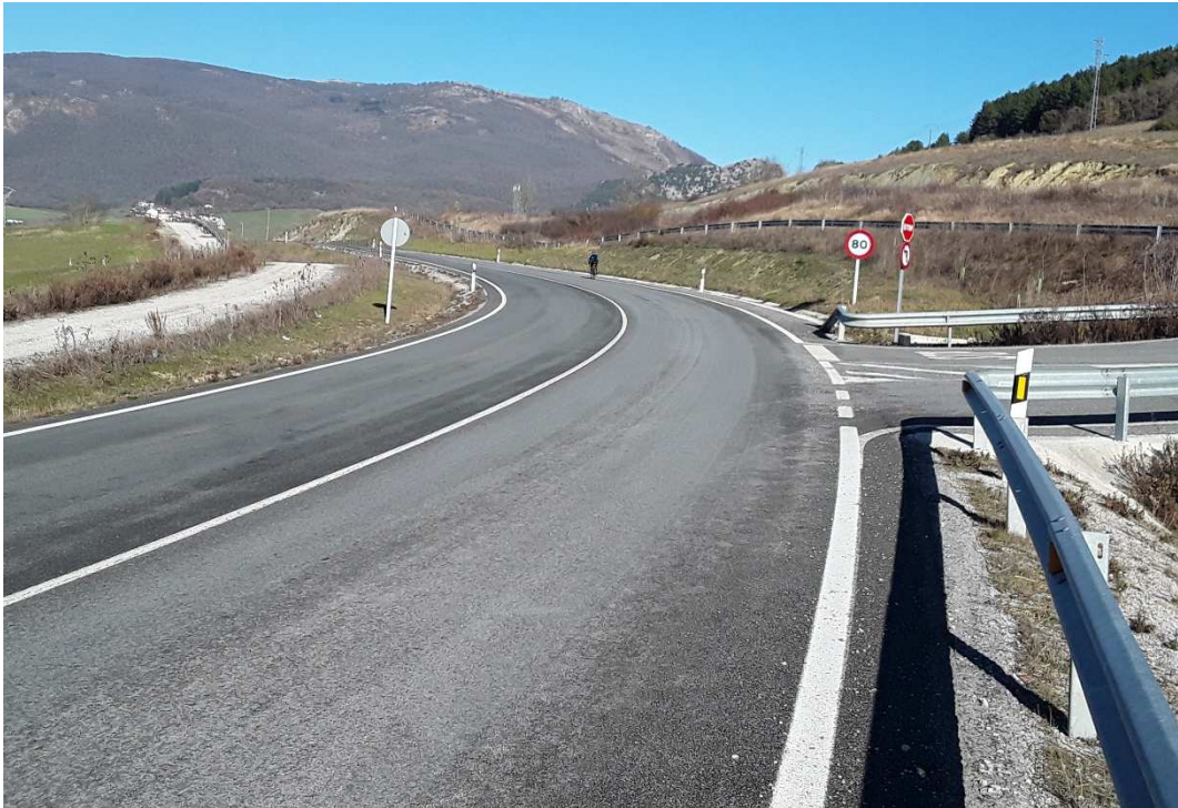
Acceso vía de servicio desde NA7010
