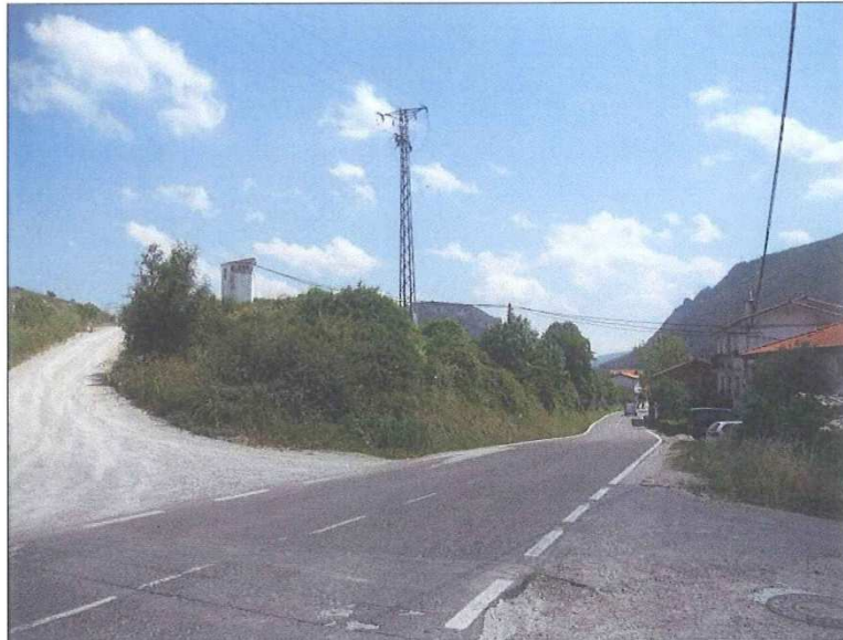
Vista sur del furo entronque norte de la NA-7010 y la futura variante
