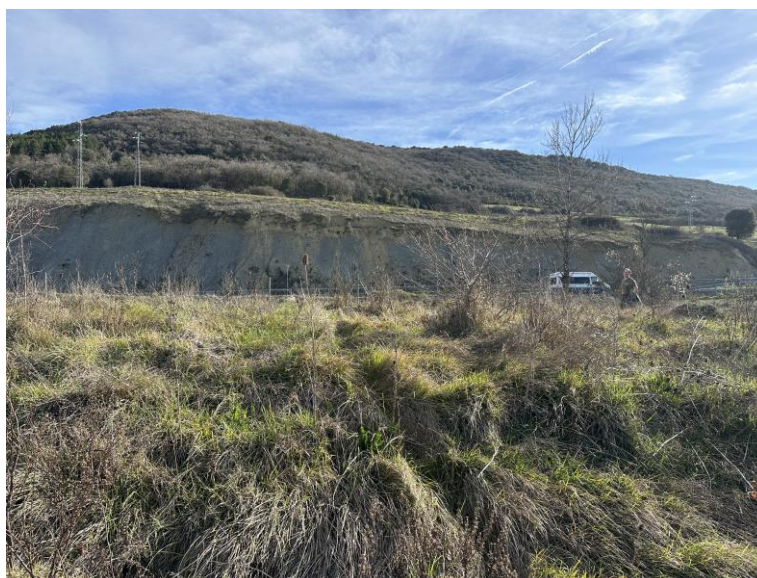
Detalle del talud existente, presencia de nivel cuaternario y sustrato rocoso margoso
