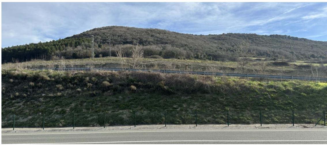
Detalle del talud existente
