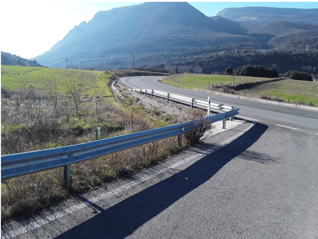
Acceso vía de servicio desde NA7010
