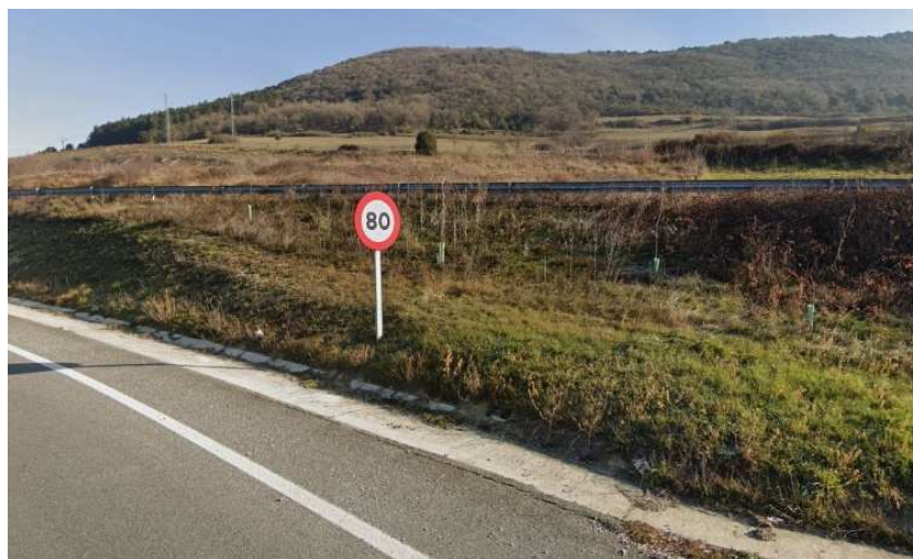
Figura 3. Señal vertical a eliminar en NA-7010, sentido Pamplona
