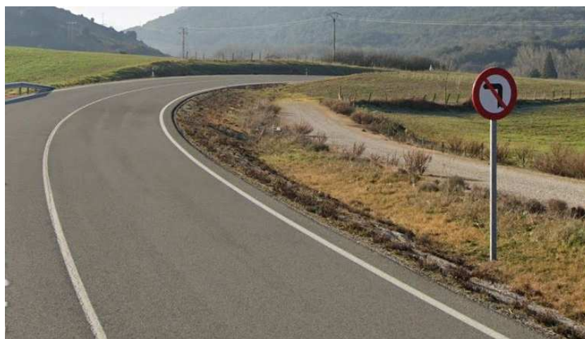
Figura 2. Señal vertical a desplazar en NA-7010, sentido Pamplona
