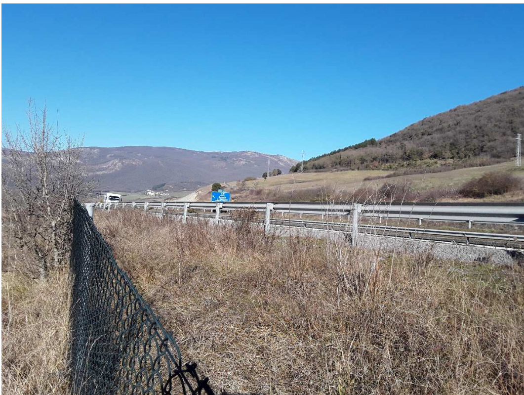
Tramo del carril de aceleración
