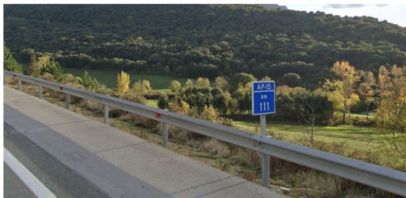
Figura 6. Señal vertical a desplazar en la A-15, sentido Pamplona
