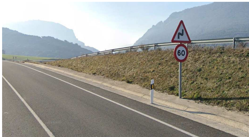
Figura 1. Señal vertical a eliminar en NA-7010, sentido Pamplona
