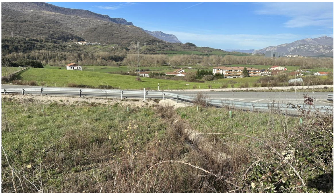
Detalle del obra drenaje
