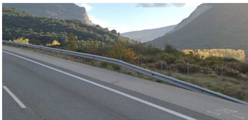
Figura 7. Barrera metálica bionda a retirar o reutilizar en la A-15, sentido Pamplona
