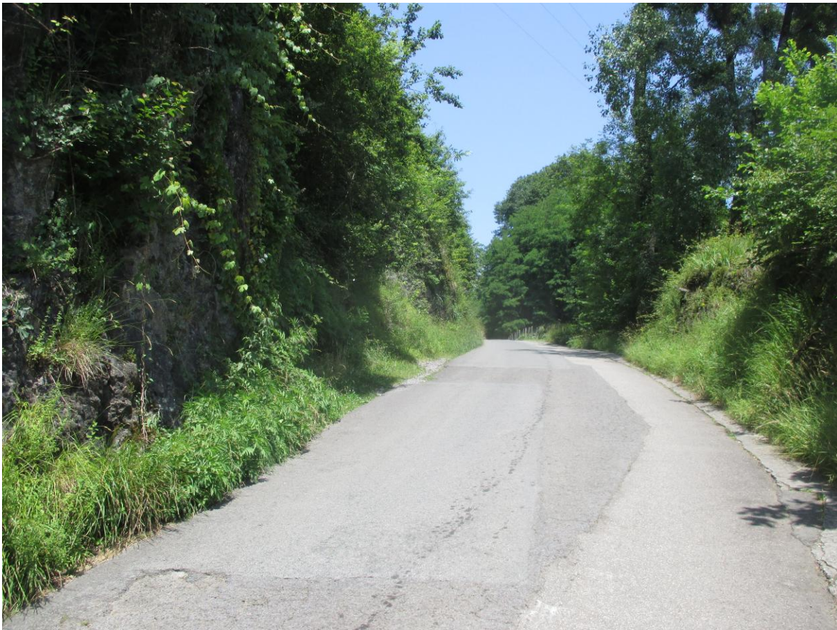
Figura 58. Desmontes existentes en el camino asfaltado.
