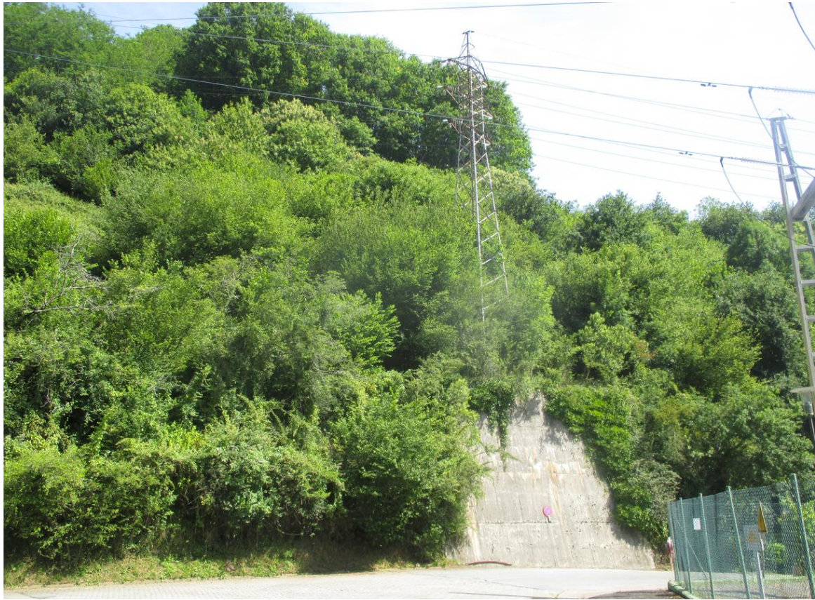
Fotografía 1. Aspecto de la ladera en la que se emplaza el trazado. PK 0+600.
