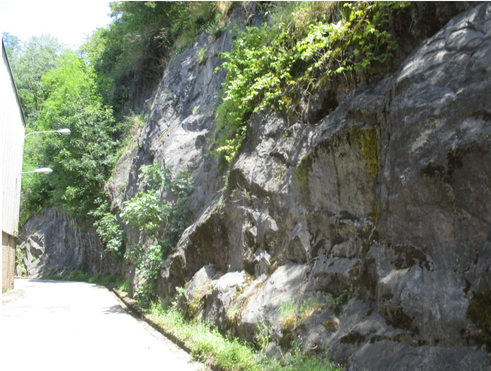
Fotografía 13. Vista del talud cercano en PK 0+940 en la unidad Cc.
