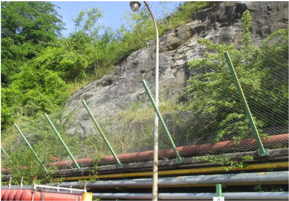
Fotografía 14. Vista del talud cercano en PK 0+420 en la unidad Cc.
