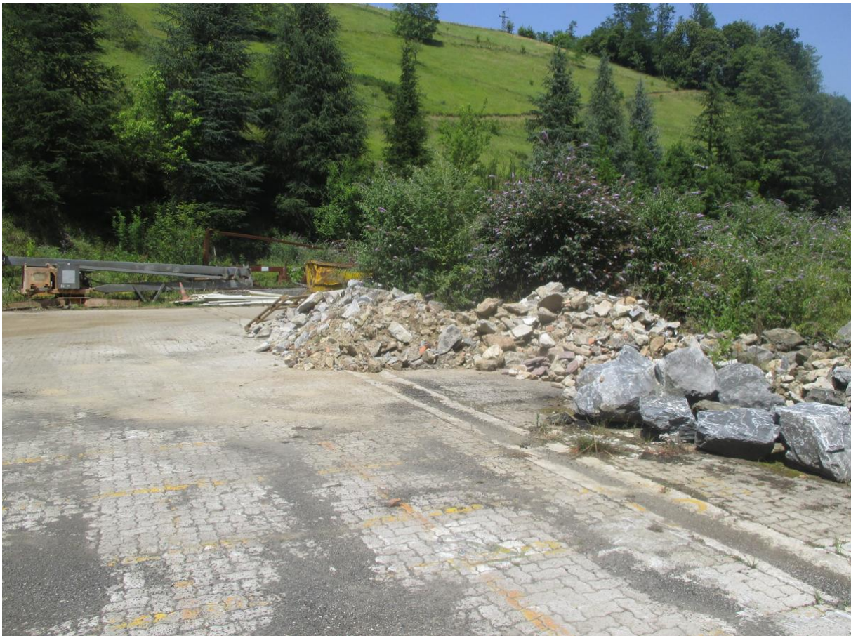
Fotografía 5. Explanada de asfalto y hormigón con varios acopios de restos de la construcción identificado en PO-11. Final del tramo.
