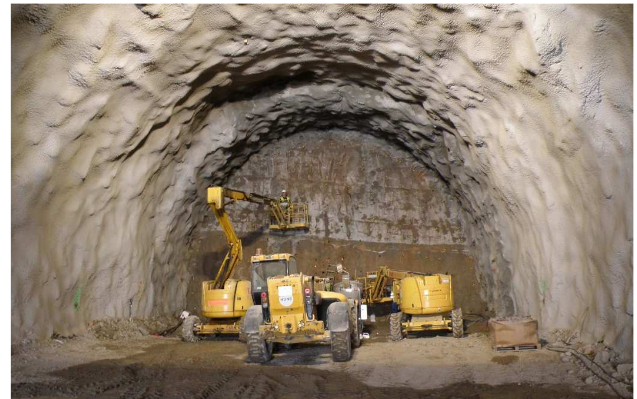
Fotografía 3.1.1.a.- Excavación de un túnel a Sección Completa.
