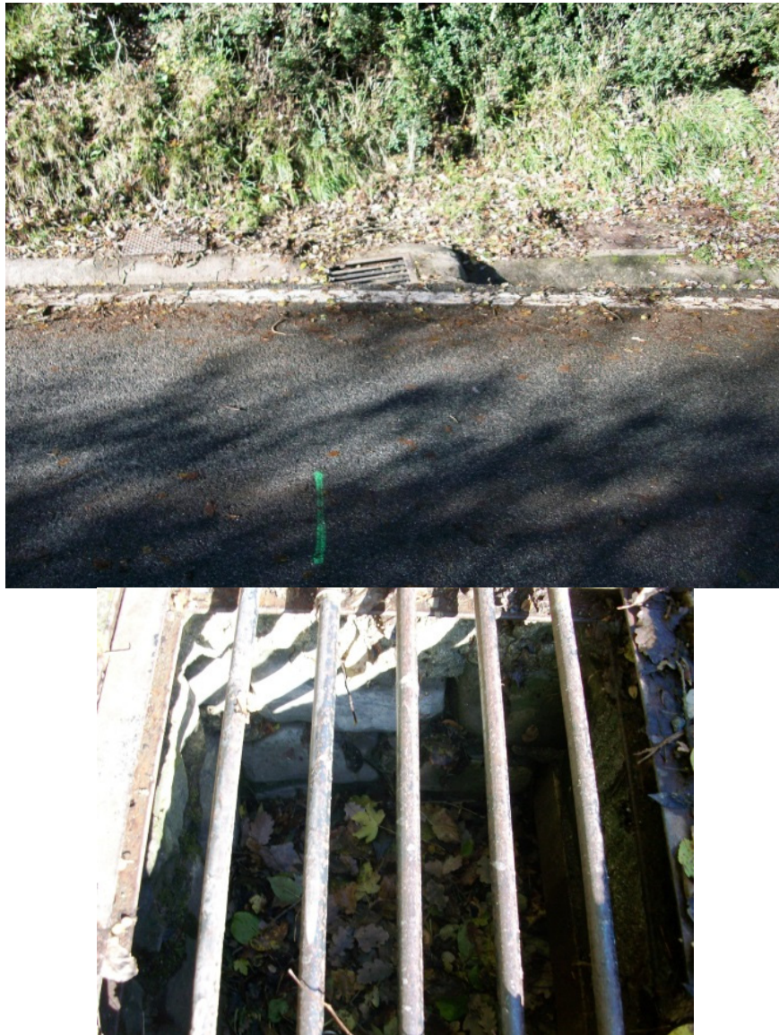
Sumidero, arqueta obra de drenaje
