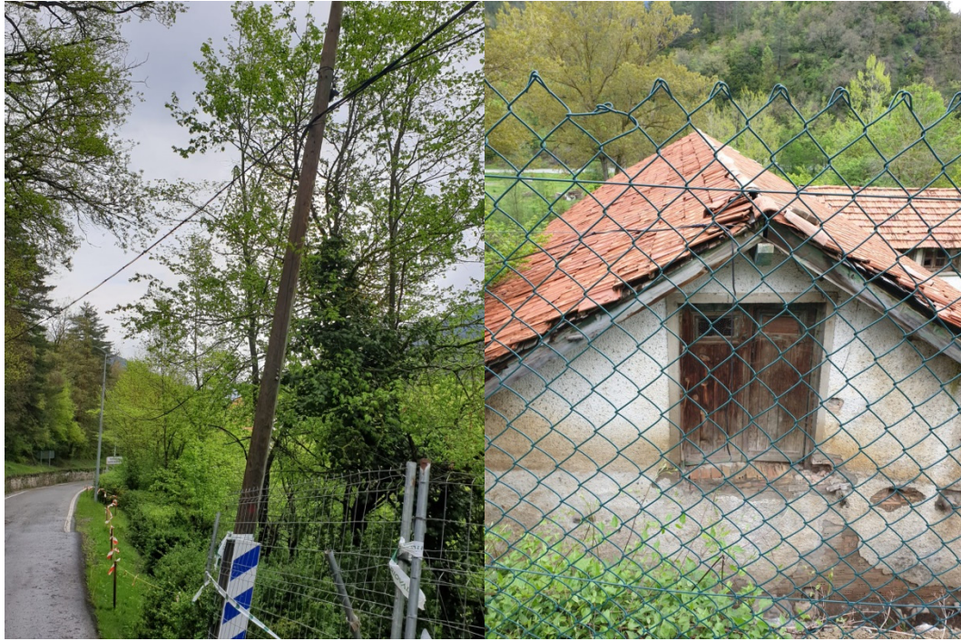
Cruce del cable y llegada al corral
