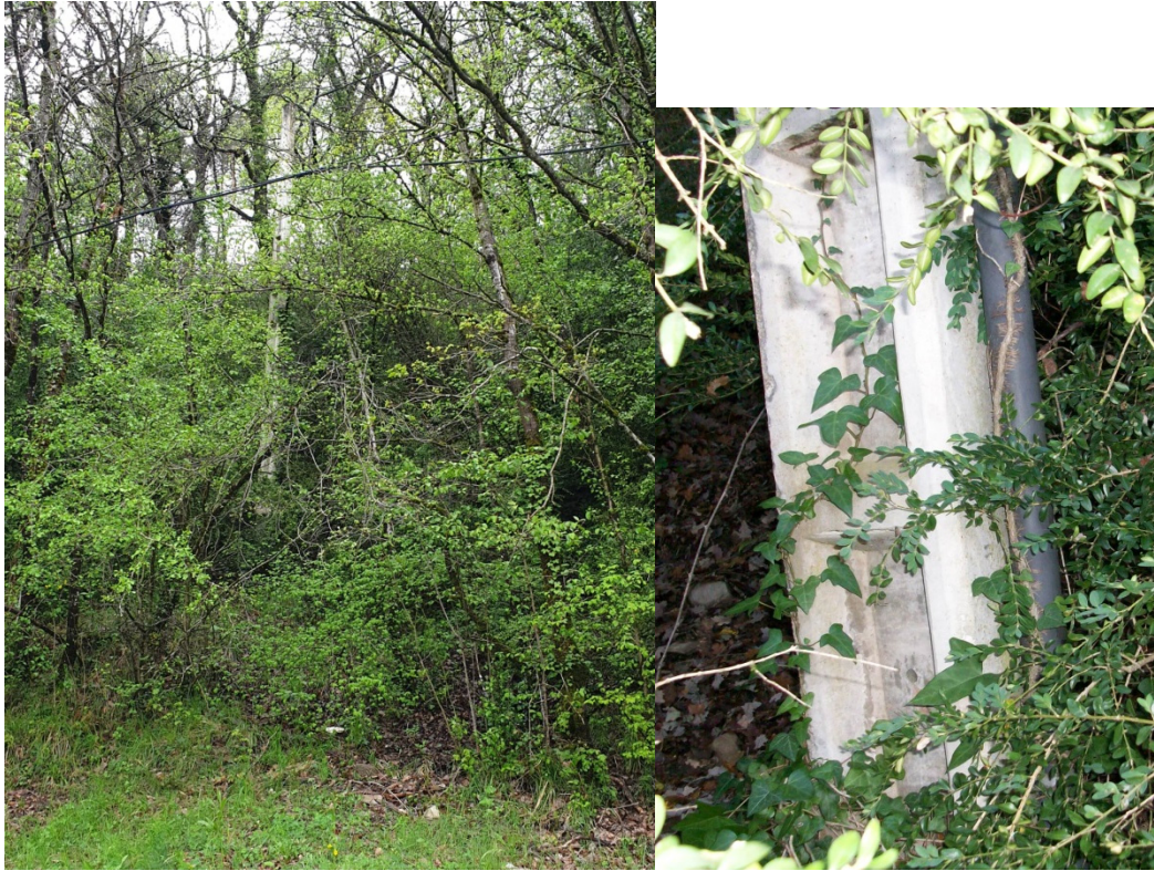
Vista del poste y conducción del cable a subterráneo
