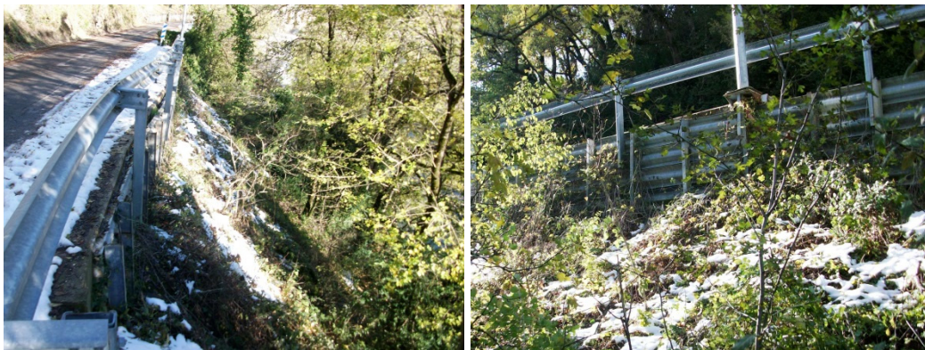
Detalles de la situación actual del sostenimiento existente
