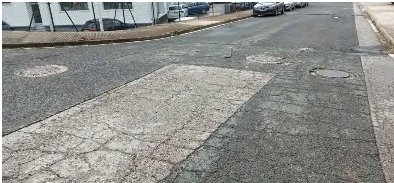
Entrada al Polígono de Akaborro.
