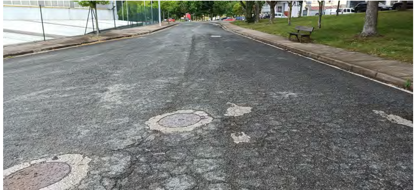
Vial de la variante de la carretera NA-2409.
