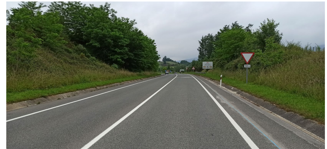
FOTO 2. VISTA DESDE LA CARRETERA DEL EMPLAZAMIENTO DE LA PASARELA EN DIRECCION FRANCIA.
