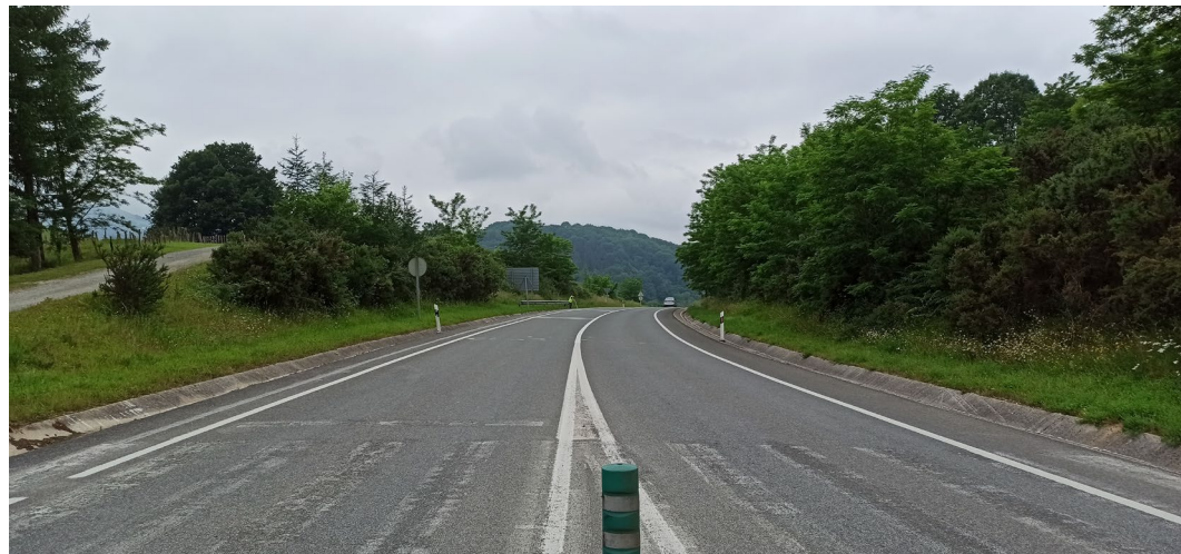
FOTO 1. VISTA DESDE LA CARRETERA DEL EMPLAZAMIENTO DE LA PASARELA EN DIRECCION PAMPLONA.
