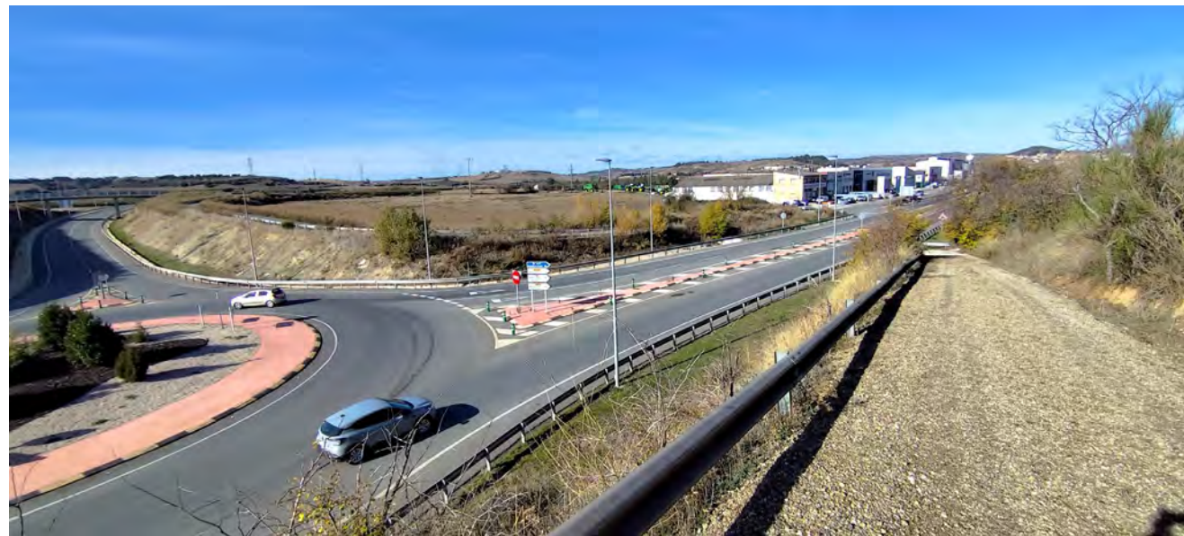
FOTO 1. VISTA DESDE EL CAMINO DE LA ERMITA DEL EMPLAZAMIENTO DE LA PASARELA EN DIRECCION A TAFALLA.
