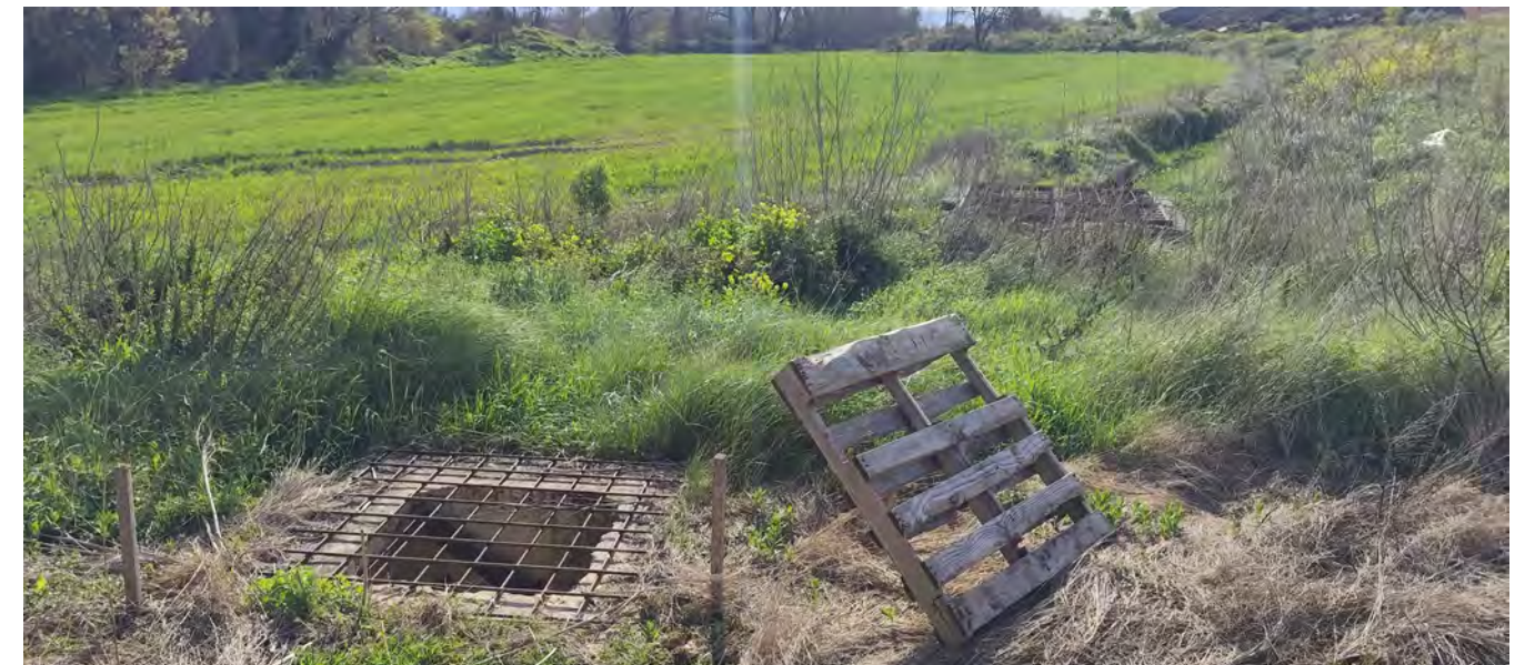
FOTO 4. VISTA DE LA FINCA EN EL TRAMO FINAL DE LA SENDA CICLABLE.
