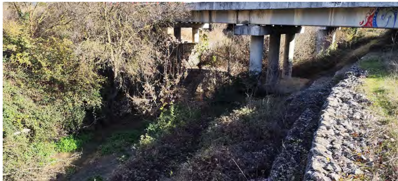
FOTO 3. VISTA DEL RÍO CIDACOS A SU PASO BAJO EL TABLERO DE LA AP-15.
