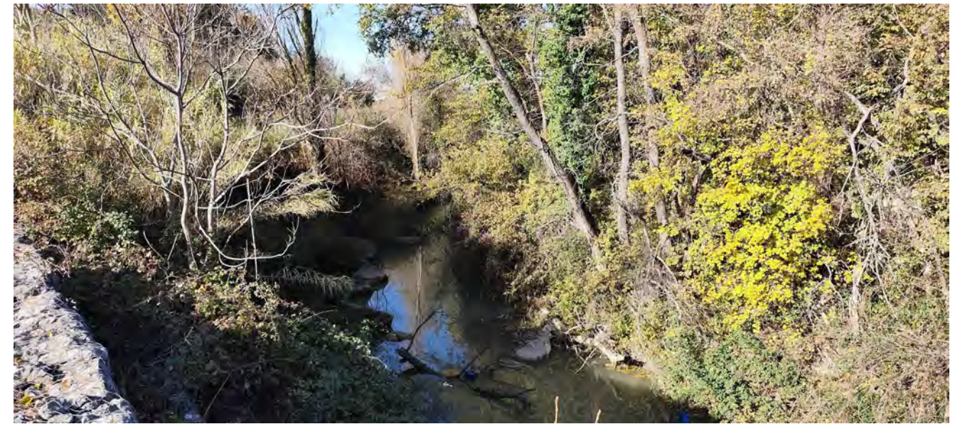
FOTO 2. VISTA AGUAS ARRIBA DEL RÍO CIDACOS A SU PASO BAJO EL TABLERO DE LA AP-15.
