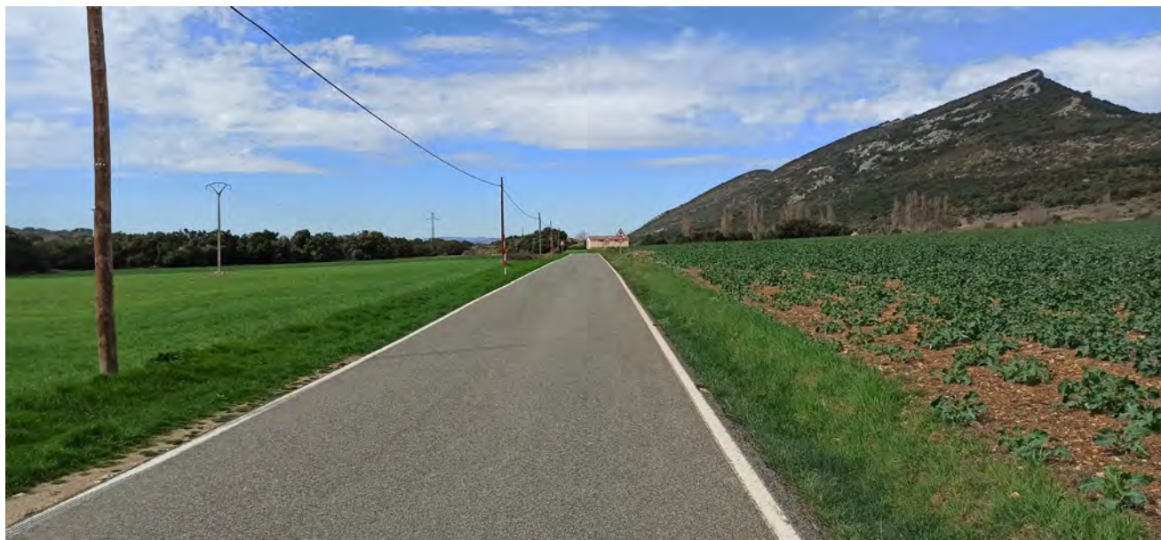
Vista de la traza en sentido decreciente del kilometraje en las proximidades del Pk 1+160.
