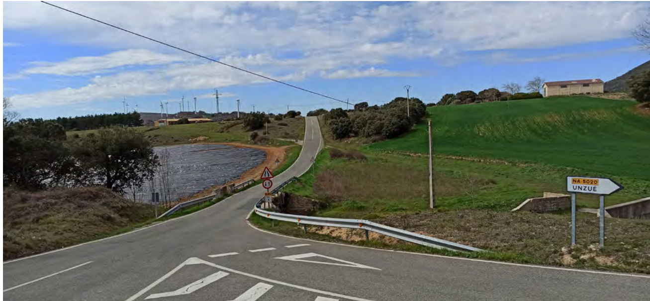
Vista de la traza en sentido decreciente del kilometraje en las proximidades del Pk 0+920.
