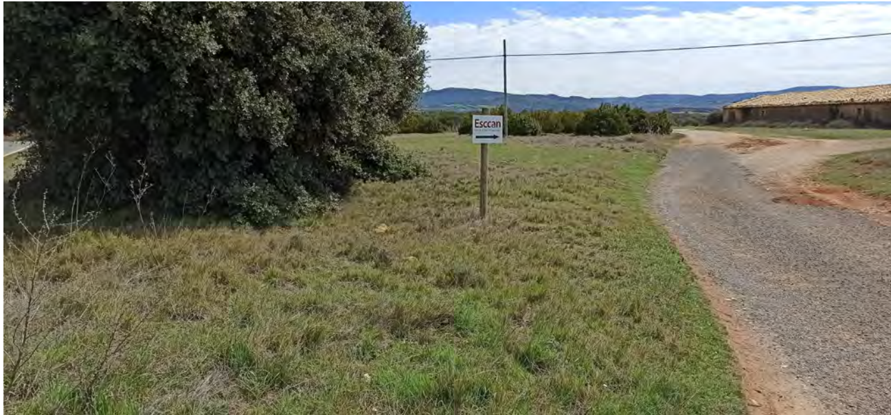
Vista de la de acopios e instalaciones en las proximidades del Pk 0+600.
