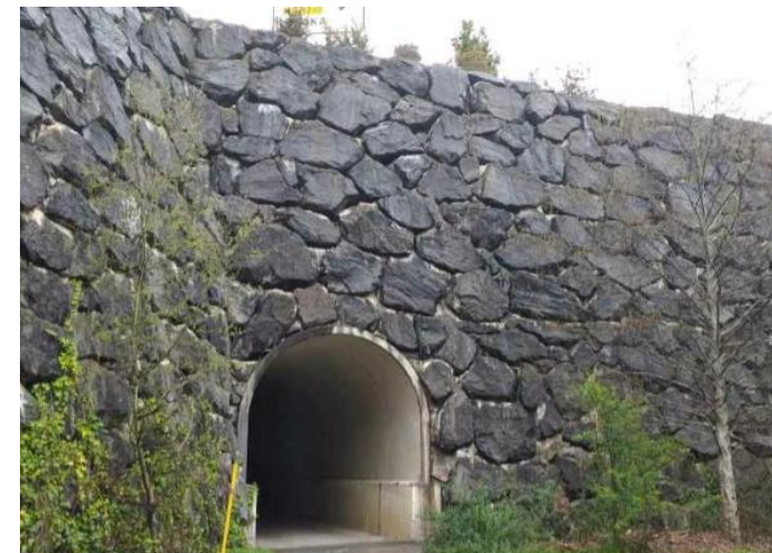
Boca sur del túnel
