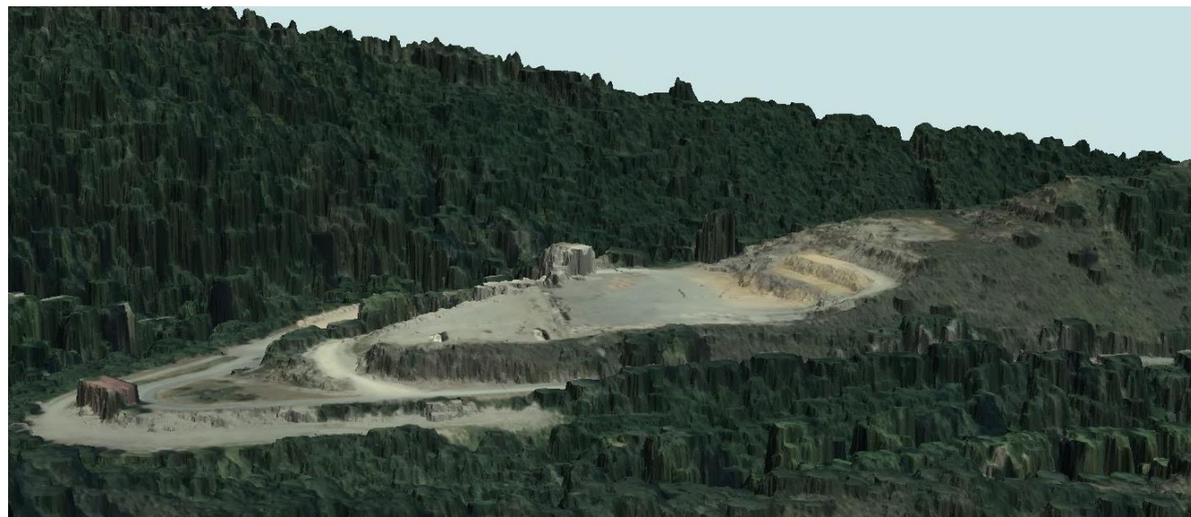
Estado actual Vertedero Sunbilla
