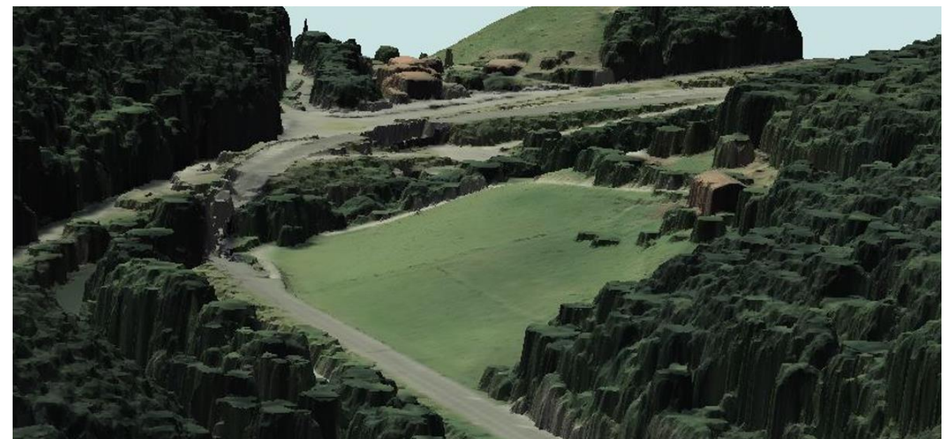
Estado Actual Vertedero Lesaka
