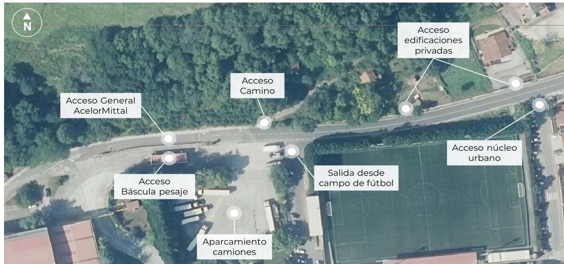
Figura 4. Carretera NA-4001. Accesos a instalaciones en el tramo final de carretera existente
