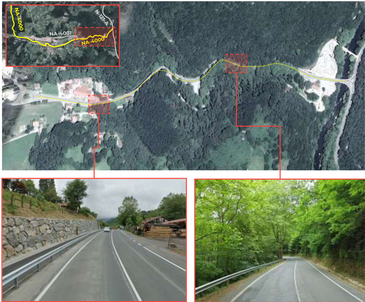
Fotografía 1. Carretera NA-4000 entre el PK 0+000 y el PK 1+000.
