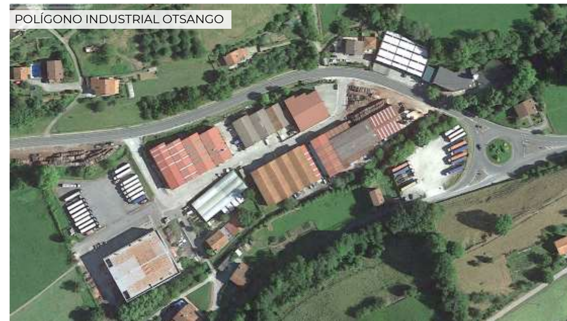
Figura 2. Carretera NA-4001. Polígono industrial de Otsango.
