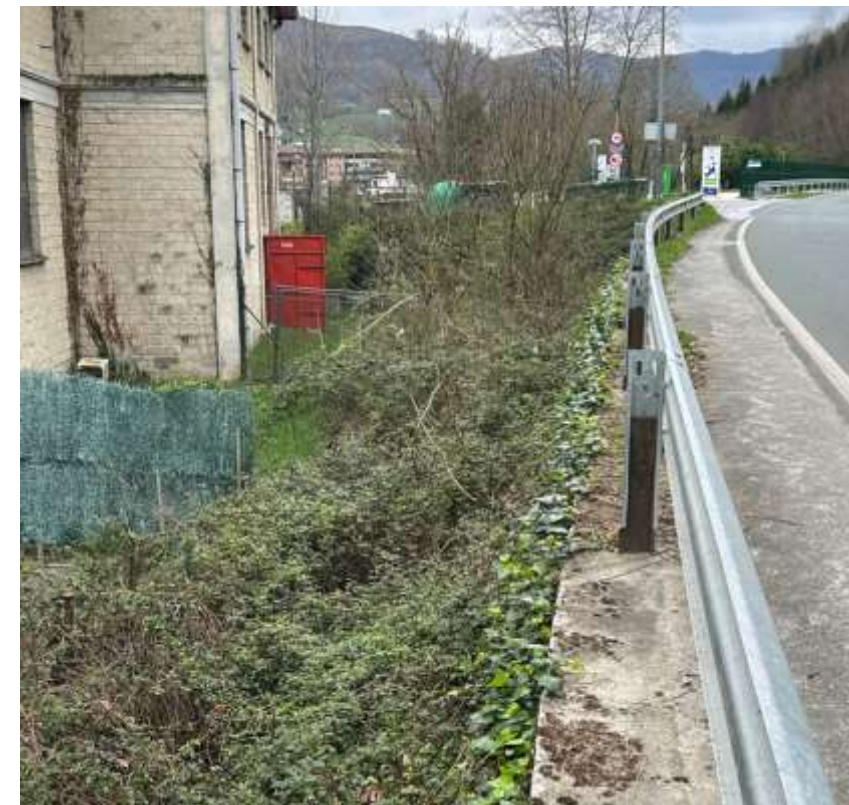
Fotografía 6. Muro existente a desplazar y prolongar por construcción de acera.
