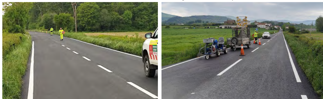
En 2025 se ha procedido a la reparación del firme y al extendido de una capa de 4 cm.
