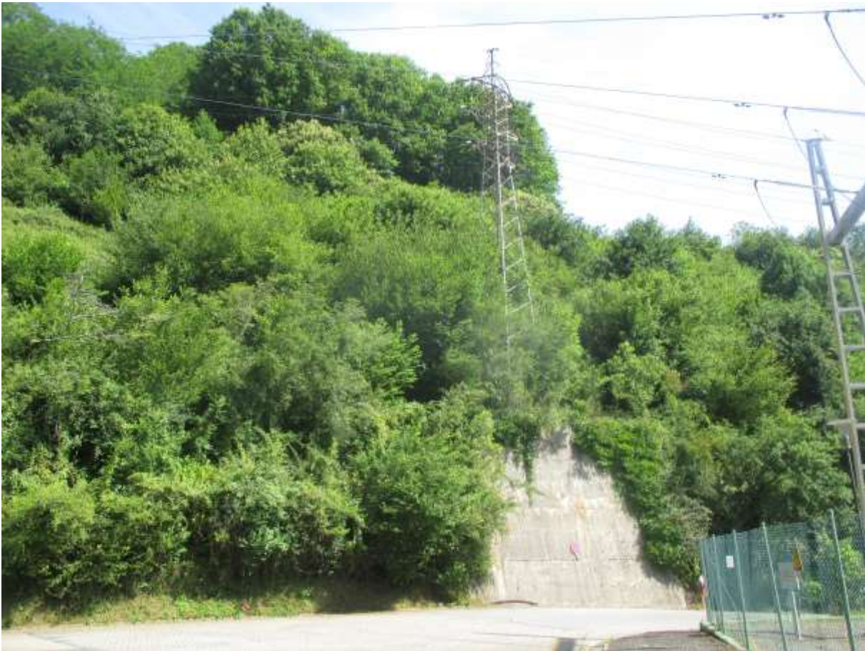
Fotografía 1. Apoyo Línea eléctrica MT-01
