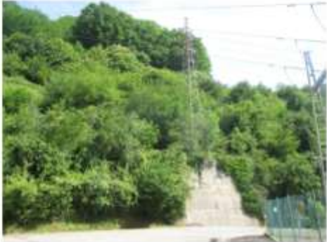
Fotografía 1. Apoyo línea eléctrica MT-01
