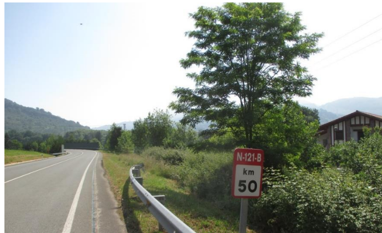
Ilustración 1. PK 50+070 de la carretera N-121B.
