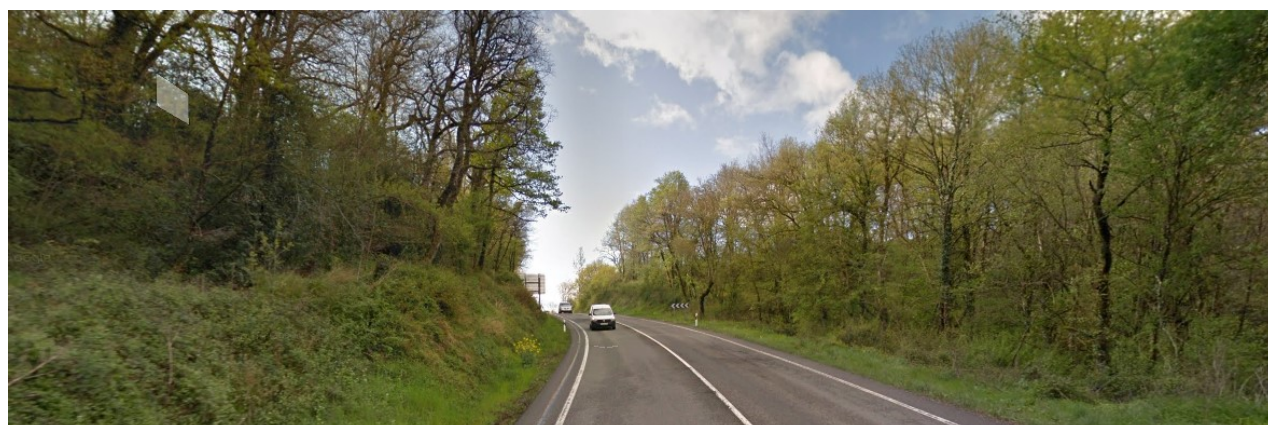
Vista de la N-121 A en las proximidades de la travesía de Ventas de Arraitz
