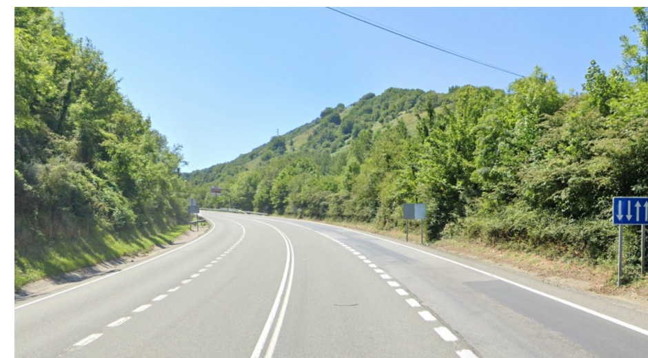
Línea telefónica aérea afectada PK 35+160
