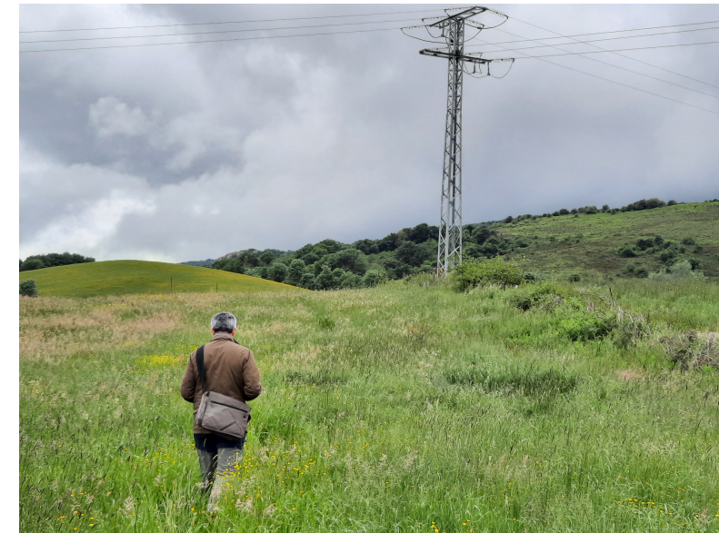
Vista de la torre de MT existente situada en margen dcha. de la Variante
