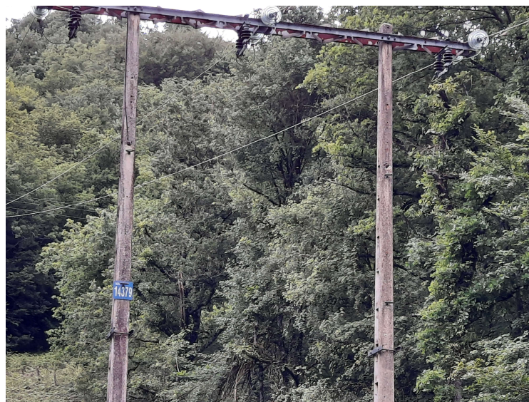
Vista de la torre de MT existente en la margen izquierda del trazado de la Variante (PK 25+910).
