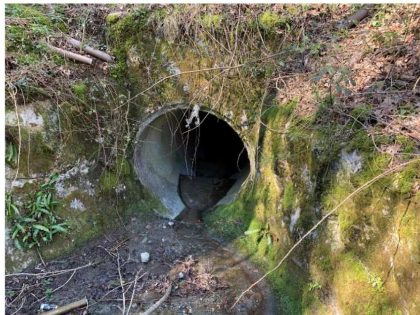
Pk 32+440 Tubo circular de hormigón de 1.800mm
