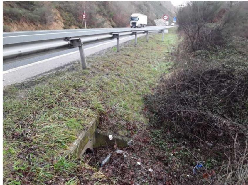
Pk 27+370 Tubo circular de hormigón de 600mm
