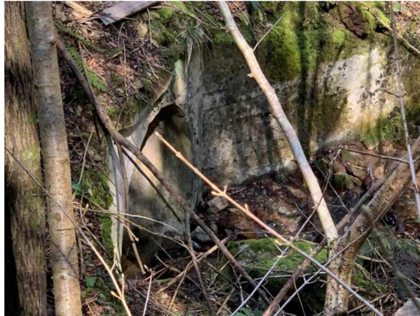
Pk 31+250 Tubo circular de hormigón de 1.800mm
