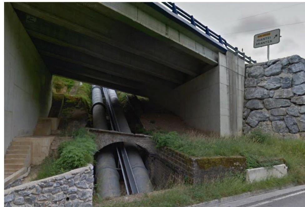
2. En el p. k. 62+200 existe un canal de desagüe de la instalaciones de Iberdrola Renovables que se ve afectado por la ejecución de la ampliación de la plataforma en la N-121-A. Este tramo se ha identificado como **SE.IR-01**
