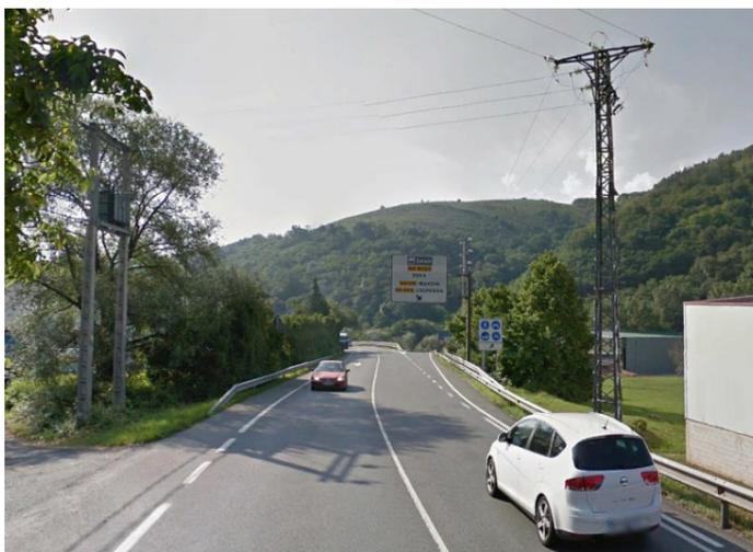
**S.E. LE 20:** Líneas eléctricas aéreas de baja tensión sobre postes de hormigón que parten del centro de transformación en ambos lados. Un tramo tiene un desarrollo paralelo a la calle de acceso a la N 121-A y el otro tramo continúa paralela con la carretera hasta que atraviesa la N-121-A en el p.k. 65+320 aproximadamente. El tramo de línea eléctrica, se ve afectada por la ejecución del Proyecto. Se repondrá la línea eléctrica en ambos sentidos del transformador.
