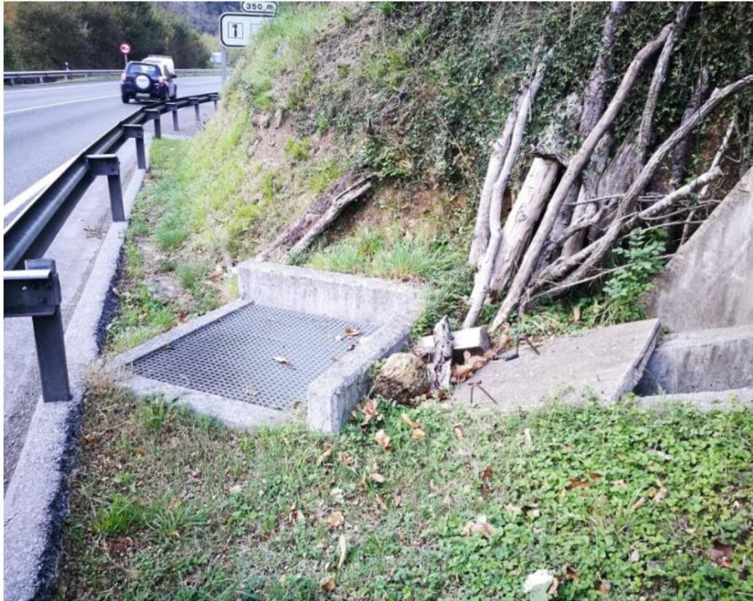
La reposición consiste en retranquear la arqueta en 2 m hacia el interior de la canalización existente manteniéndose la dirección de la canalización existente. El tramo que quede dentro de la nueva plataforma y de la cuneta se realizará mediante una tubería enterrada del mismo diámetro de la que cruza la carretera existente.
