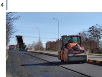
Refuerzo asfalto.
