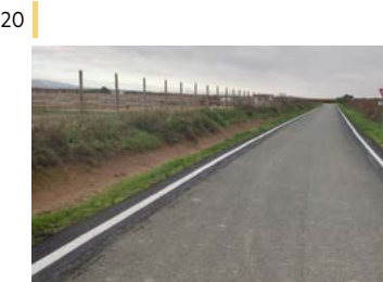
Recuperación de márgenes de carretera NA-6891 Corella-Grávalos.
