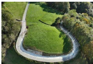
Acondicionamiento y mejora de 3 curvas.
