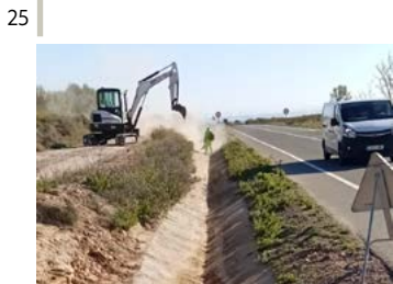
25 | Limpieza de calzada, cunetas y rebaje de márgenes.
