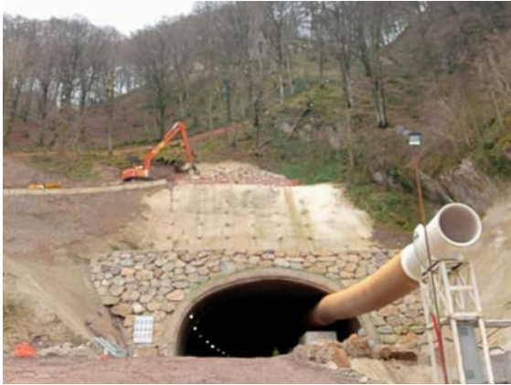
Emboquille norte del nuevo túnel de Belate. Construcción de escollera.
