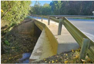
Reparación en puente.
