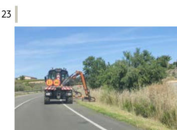
Desbroce de márgenes.
