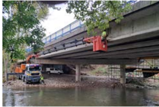
Reparaciones en estructuras.
