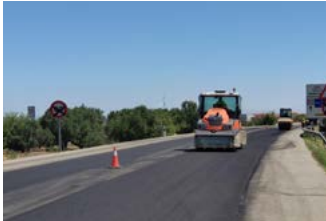
Refuerzo de firme N-113, Pamplona / Iruña-Madrid.
