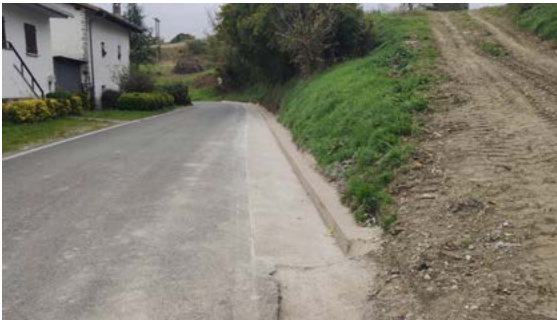
0001-EXP1-2024-000095 | Cuneta revestida en la carretera NA-7012 Erice de Iza.
