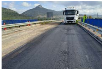
Impermeabilización de varios puentes.
