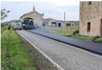
Refuerzo y saneo de aglomerado.
