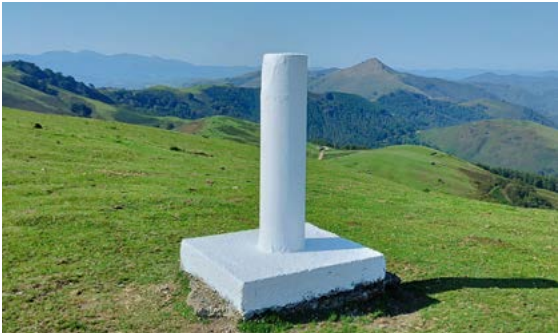
Vértice LIZARTZU, reconstruido y recién pintado.
