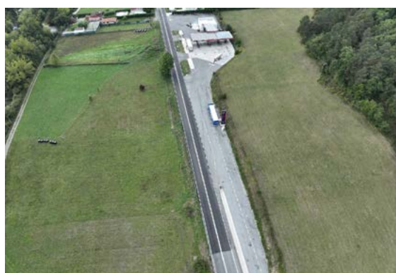
Vista de la zona.
