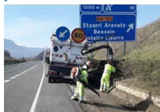
Limpieza de caz y cunetas de hormigón.
