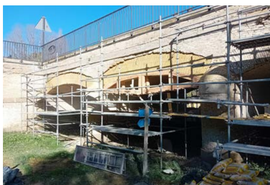
Reparación puente de Peralta.
