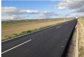
Refuerzo de firme NA-624, Peralta / Azkoien-Andosilla.
