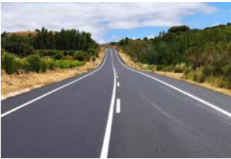
Refuerzo y saneo de aglomerado.
