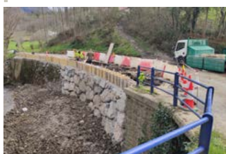
Saneos y escolleras.
