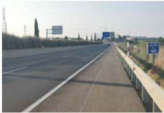
Fresados de firme A-68, Autovía del Ebro.
