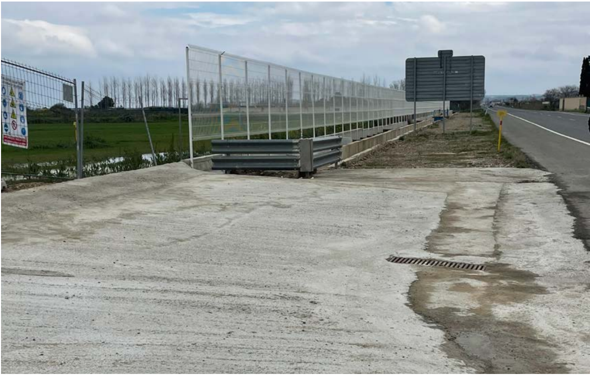
AOP 2024-5 | Cubrir acequia en la carretera NA-128 Peralta.
