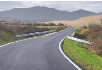
Refuerzo y saneo de aglomerado.
