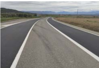
Refuerzo y saneo de aglomerado.
