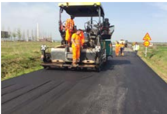
Refuerzo y saneo de aglomerado.
