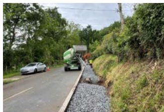
Ejecución de cuneta de hormigón.
