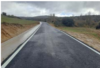
Ejecución de cunetas pisables de hormigón.
