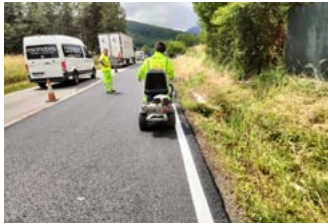
Nueva señalización horizontal y repintado.
