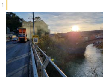
Reparación en puente.
