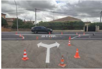
Refuerzo de firme N-121-C, Tudela-Tarazona.
