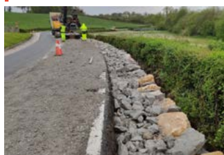
Saneos y escolleras.
