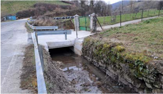
0001-EXP1-2024-000134 | Sustitución de O.F. en la carretera NA-1700 Uitzi.
