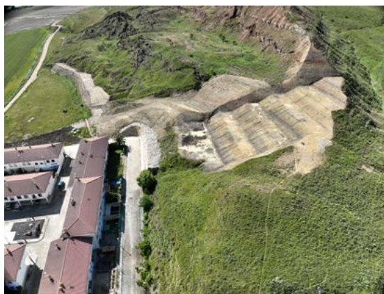
Fotografía de la zona con la obra terminada.
