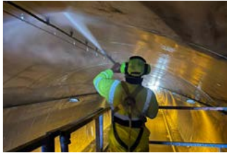
Limpiezas y pintado de túneles.
