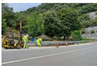
Colocación y recolocación de barrera bionda.
