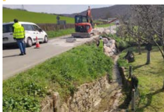
Saneos y escolleras.
