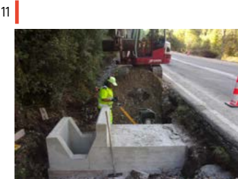
Excavación y relleno de bermas.
