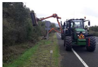
Desbroce de márgenes.
