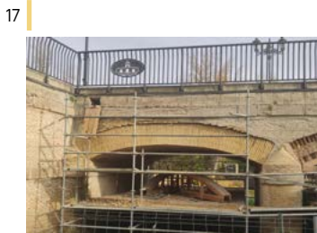
Rehabilitación de puente Chico en Peralta / Azkoien.
