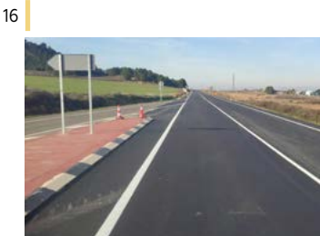
Refuerzo de firme NA-6810, Montes del Cierzo-Corella.
