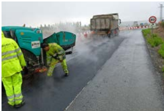
Bacheo con extendidora.
