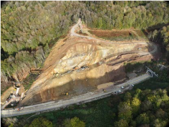
Boca sur del túnel de Belate, en la carretera N-121-A.
