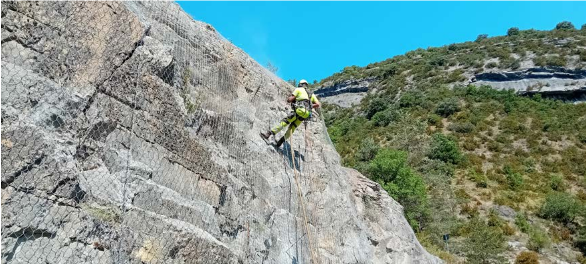
Colocación malla metálica en talud, NA-137.
