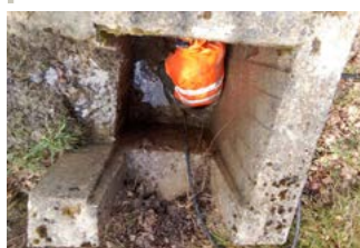
Limpieza de obras de fábrica, pocillos y salvacunetas.
