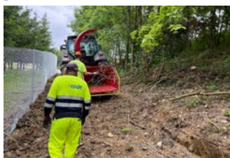
Trabajos de tala y poda.
