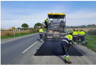
Refuerzo y saneo de aglomerado.
