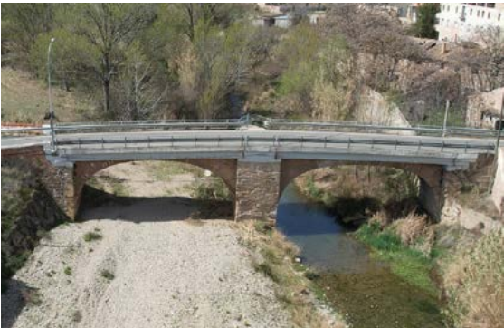
Imagen lateral del puente.
