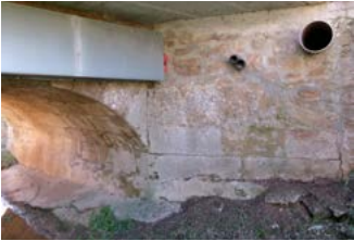
Reparación en puente.
