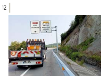
Barreras de seguridad y malla de cerramiento.
