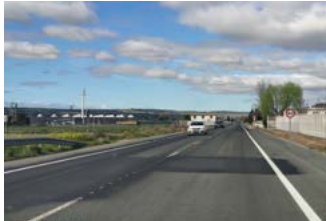
Fresado y bacheo de firme NA-128, Peralta / Azkoien-Carcastillo-límite de Zaragoza.
