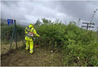
Desbroce de malla de cerramiento.
