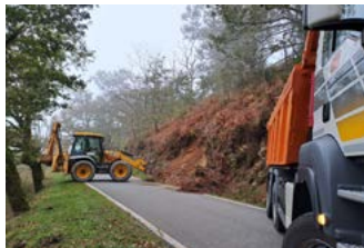
Limpieza cunetas de tierra.
