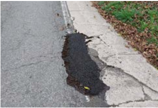
Bacheo en frío.
