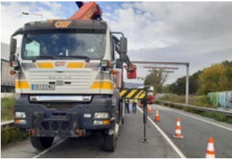
Mantenimiento de señalización vertical y balizamiento.
