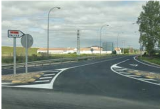
Refuerzo de firme NA-660, Venta de Arlas-Cadreita.
