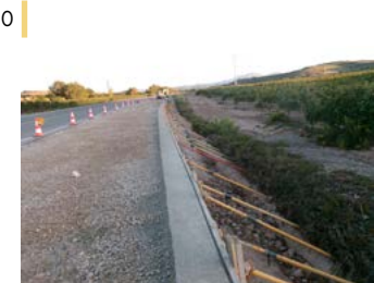
Excavación, terraplén y afirmado.
