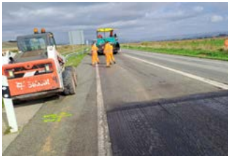
Rehabilitación de firme en las carreteras del centro de conservación de Tafalla.
