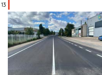
Refuerzo de firme NA-115, Tafalla-Peralta / Azkoien-Rincón de Soto.
