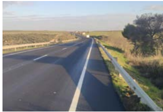
Refuerzo de firme N-121, Pamplona / Iruña-Tudela.
