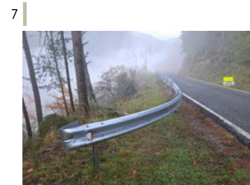
Señalización y balizamiento.
