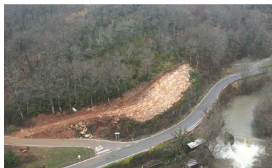
Imagen previa trabajos de voladura.
