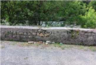
Rehabilitación de estructura de mampostería.
