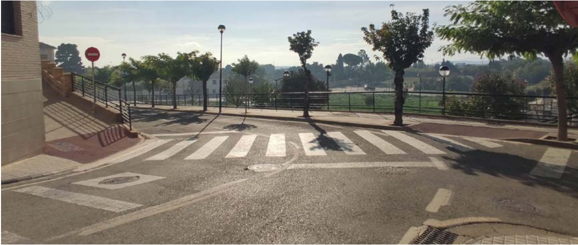
AOP 2024-7 | Paso de peatones en la carretera NA-6840 Murchante.
