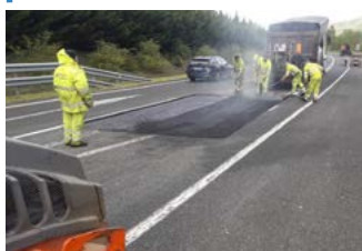
Fresado y extendido de aglomerado.
