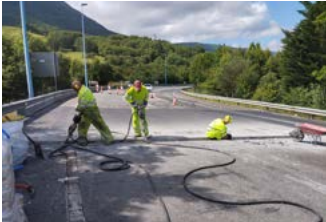
Reparación de juntas de dilatación en estructuras NA-240-A, NA-2410 y NA-1001.
