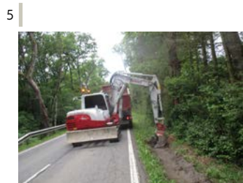
Limpieza de cunetas de tierra, hormigón y arcenes.
