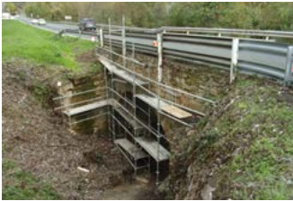
Reparación en puente.
