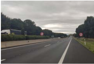
Refuerzo de firme A-68, Autovía del Ebro.
