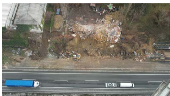
Superficie sobre la que se ha realizado el trabajo.
