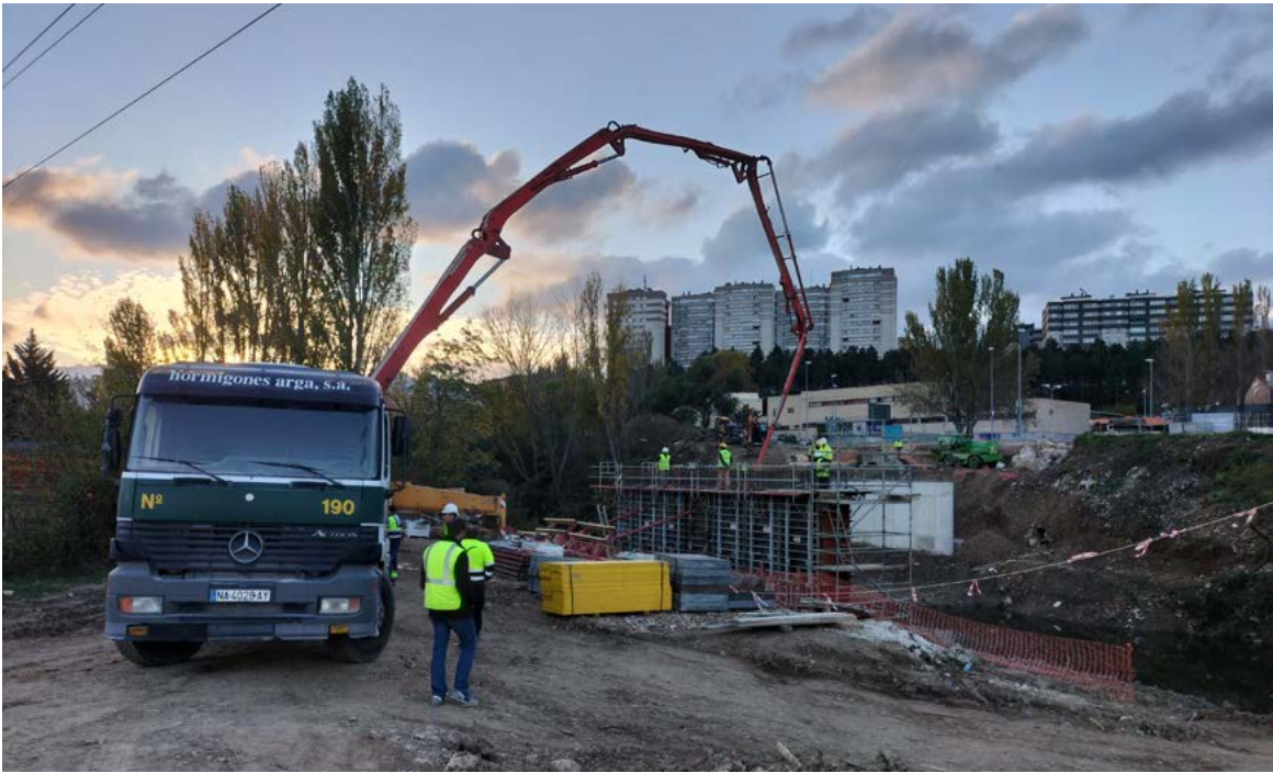
Hormigonado con bomba en el puente de Barañáin / Barañain-Landaben.
