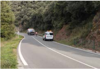
Barrido de calzada y arcenes.
