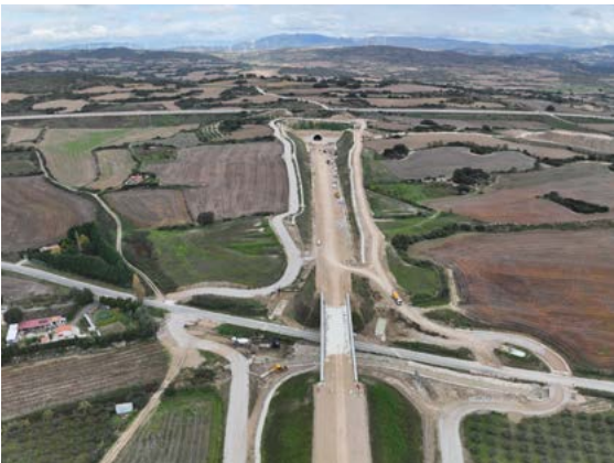
Obras del TAP a su paso por Tafalla.
