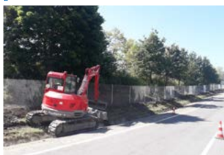
Colocación de malla de cerramiento.
