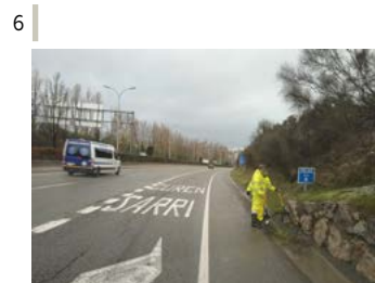
Limpieza de drenajes y obras de fábrica.
