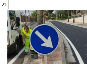
Reposición de señalización vertical.
