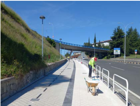
Carril bici Zizur Mayor / Zizur Nagusia, remates finales en pavimento de aceras.
