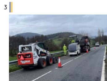
Fresado y reposición de asfalto con miextendedora.
