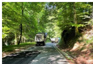
Fresado y reposición de tramos pendientes hasta km 7.
