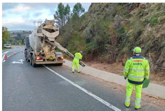
Hormigonado de cunetas, NA-132.
