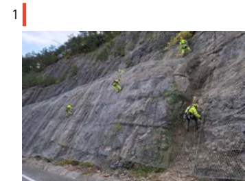
Estabilización de taludes.
