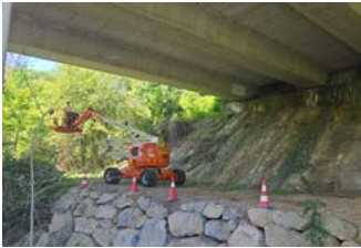
Reparación de estructura P.K. 127+400.
