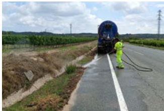
Limpieza de calzada y desbroce de márgenes (2 y 4 m).
