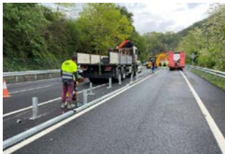
Barrera de seguridad colocada.
