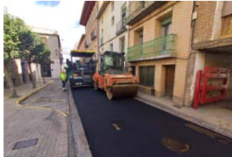
Refuerzo de firme NA-160, Tudela-Fitero.
