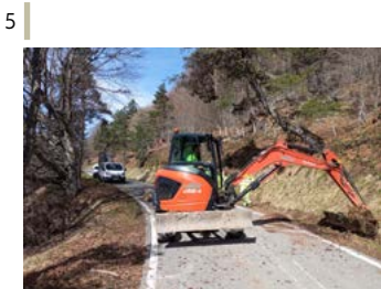
Limpiezas y desbroces.
