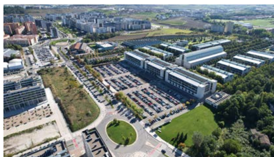
Vista aérea del aulario principal.
