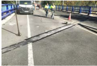
Mantenimiento de barandillas de puentes.
