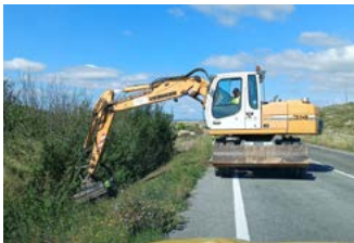
Limpieza de cunetas en tierras y hormigón. Pantalla vegetal y podas.
