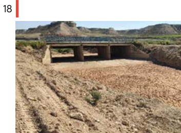
Limpieza de puente en barranco La Torre NA-126, Tudela-Tauste.
