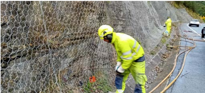
Colocación malla metálica en talud, NA-137.
