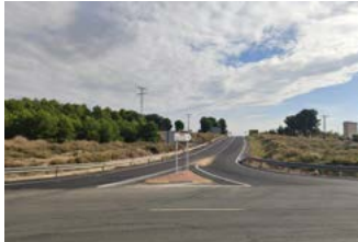
Refuerzo de firme NA-125, Tudela-Ejea.
