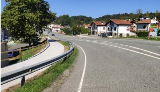
AOP 2024-24 | Pavimentación camino en la carretera NA-1300 Lekunberri.
