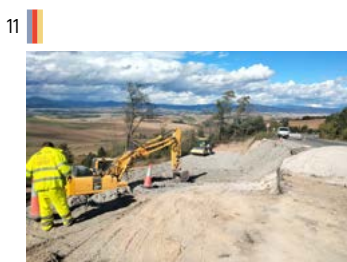
Saneos, desmontes y ensanches.
