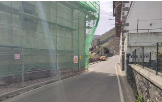
AOP 2024-392 | Colocación de andamio en la carretera NA-1700 Leizta.
