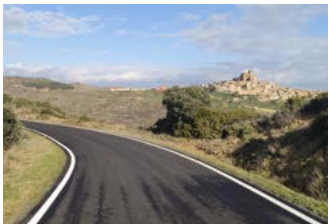
Refuerzo y saneo de aglomerado.
