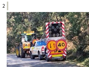
Desbroce de márgenes de carreteras.
