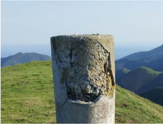
Estado en el que se encontraba el vértice LIZARTZU.
