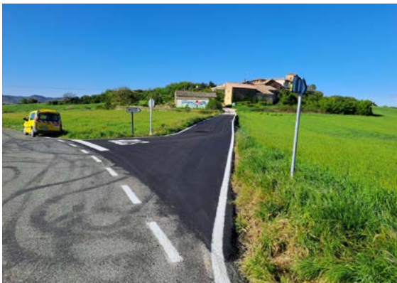
0001-EXP1-2024-000040 | Pavimentación de acceso en la carretera NA-7020 Irujo.
