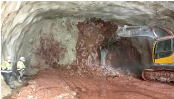
Frente excavación. Duplicado túnel de Belate.
