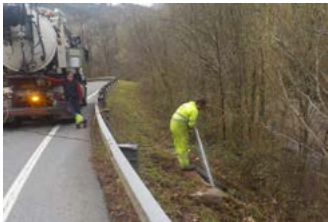
Limpieza de obras de fábrica.
