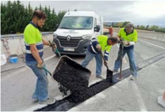
Juntas de dilatación de puentes.
