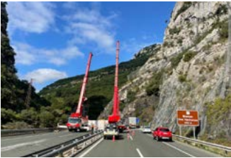
Trabajos atención a la vialidad.
