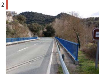
Reparación en puente.
