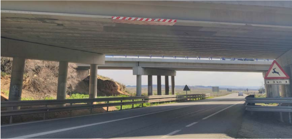
AOP 2024-307 | Reparación de estructura en la carretera NA-160.
