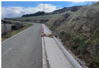
Ejecución de cunetas pisables de hormigón.
