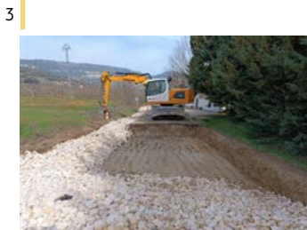
Saneos y cuneta de hormigón.
