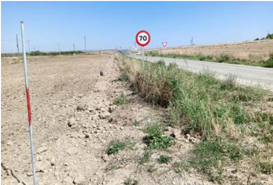
AOP 2024-74 | Colocación de aspersores en la carretera NA-5510 Rada.
