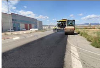
Refuerzo de firme N-113, Pamplona / Iruña-Madrid.
