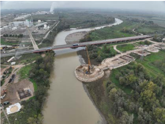
Obras del TAP a su paso por el río Ebro.
