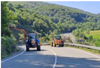
Desbroce de taludes.
