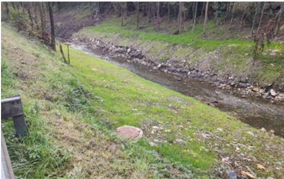
0001-EXP1-2024-000402 | Demolición presa en la carretera NA-170 Leizta.
