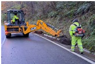
Limpieza cunetas hormigón.
