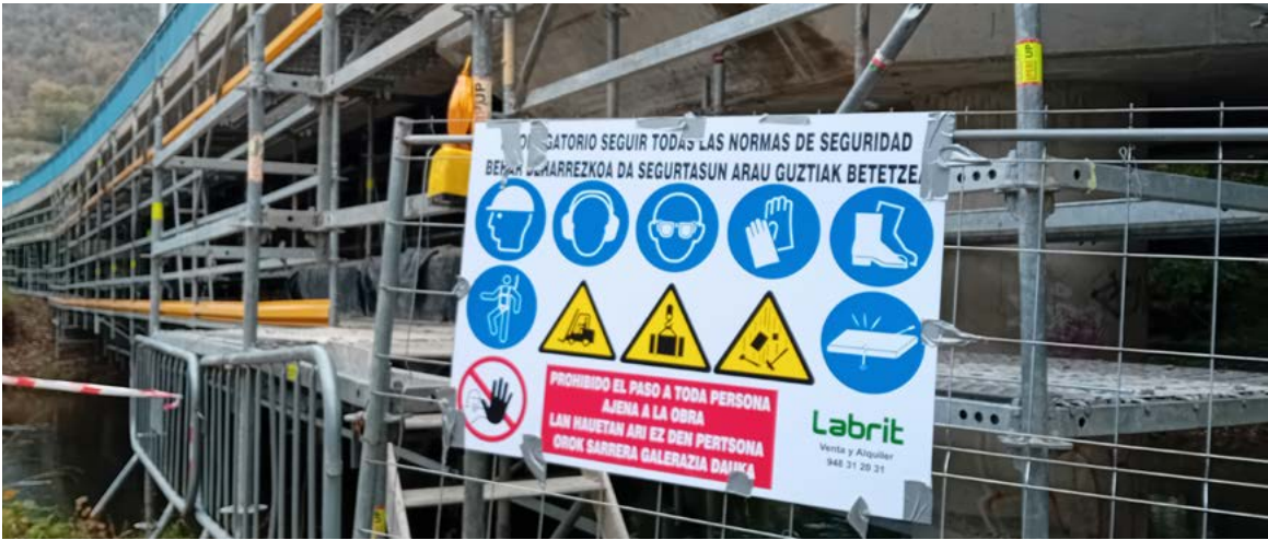
Señalización de seguridad en reparación del puente de Sorauren.
