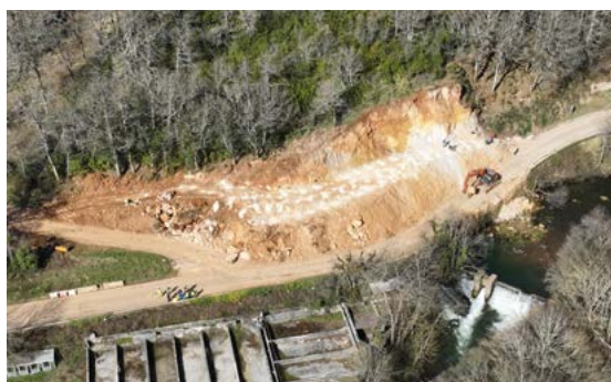
Imagen previa trabajos de segunda voladura.
