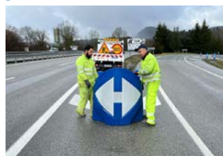
Reposición de elementos de balizamiento (Balizas divergentes, Hitos H-75).
