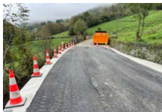
Zunchos y recrecido de arcenes con hormigón.
