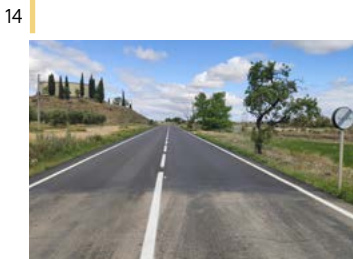
Refuerzo de firme NA-5200, Ribaforada-Cortes.
