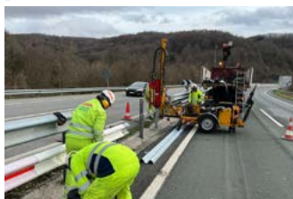
Reposición y recolocación de barrera de seguridad.
