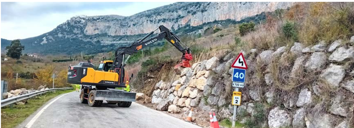
Reparación de escollera, NA-7110.
