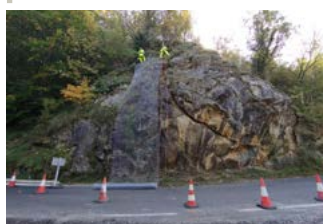
Instalación de malla y bulones en talud.
