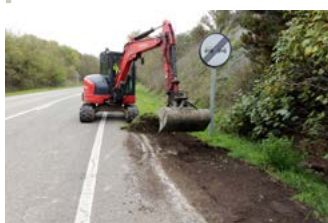
Limpieza de cuneta de tierra y rebaje de bermas.
