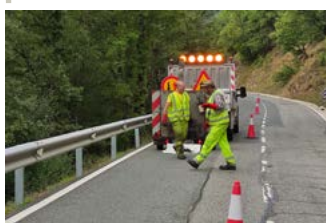
Sellado de grietas en caliente.
