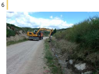
Limpieza cunetas y mejora de camino.
