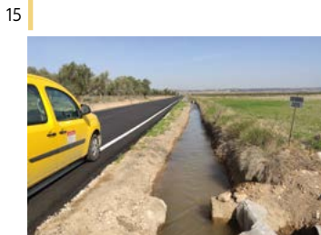
Refuerzo de firme y reconstrucción de arceres.
