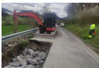
Saneos y escolleras.
