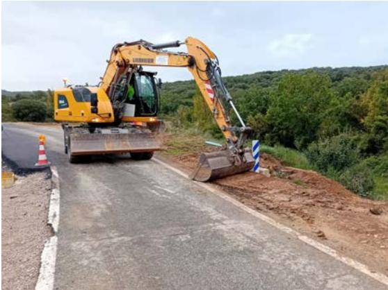
Trabajos de ampliación de la NA-5163.
