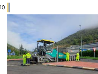
Fresados, refuerzos, reciclado de firmes.
