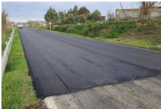
Refuerzo y saneo de aglomerado.
