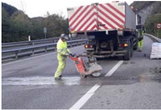
Reparaciones juntas de dilatación estructuras.
