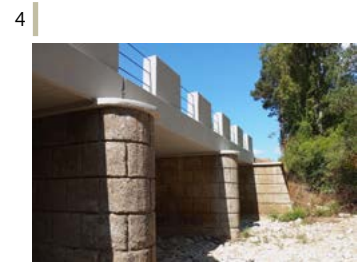
Reparaciones de puentes.
