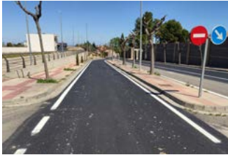
Refuerzo de firme N-121-C, Tudela-Tarazona.
