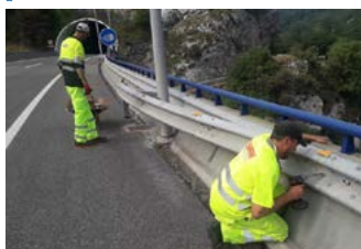
Reposición de captafaros-catadióptricos.
