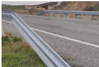
Reposición de barreras de seguridad y empalizadas.
