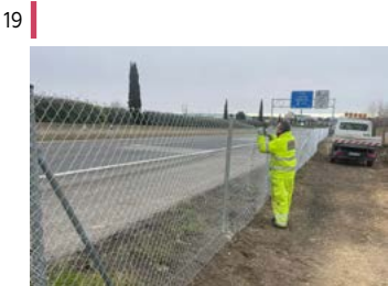
Reposición de malla en laterales.
