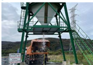
Trabajos en silos.
