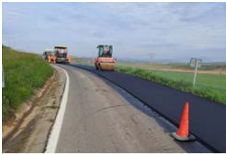
Saneos de firme, refuerzo y saneo de aglomerado.
