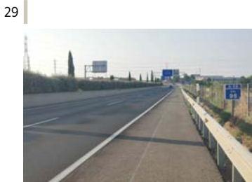
29 | Rehabilitación de firme de las carreteras.
