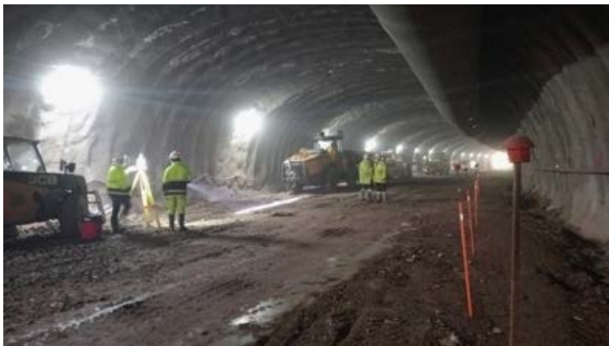
Trabajos interior nuevo túnel Belate.
