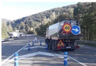
Barrido de márgenes de calzada.
