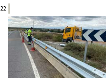
Reposición de barrera de seguridad.
