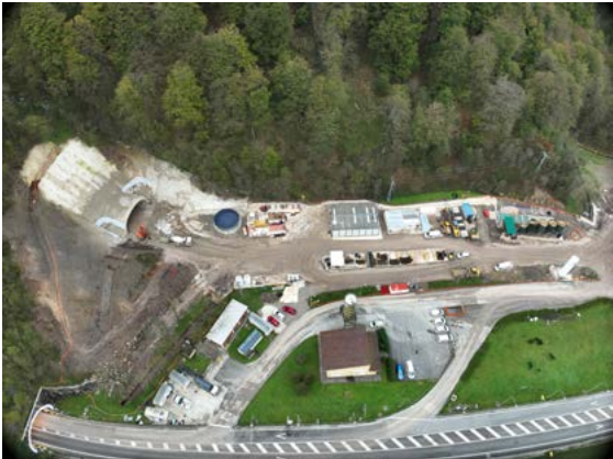
Boca norte del túnel de Belate, en la carretera N-121-A.
