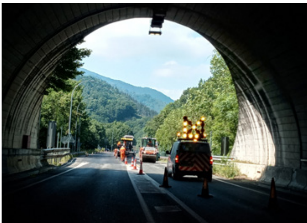
_Señalización por obras de asfaltado.
