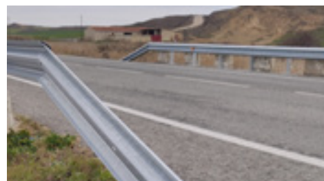
18 | Reposición de barreras de seguridad y empalizadas.
