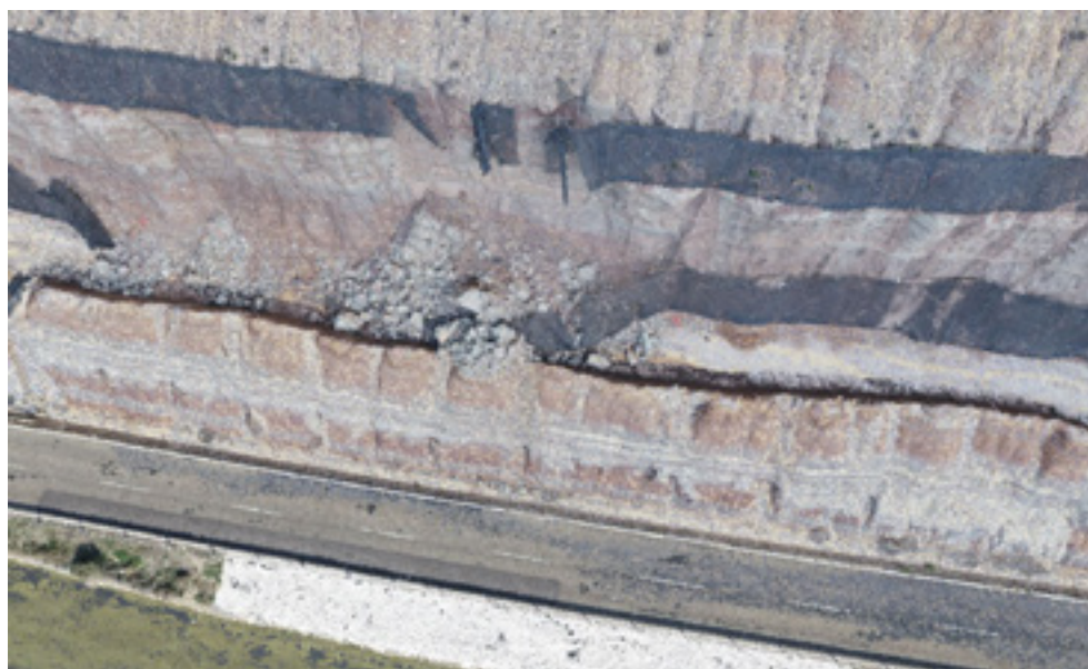
_Nube de puntos 3D de la zona del talud.
