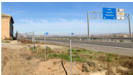
13 | Reposición de malla en laterales.
