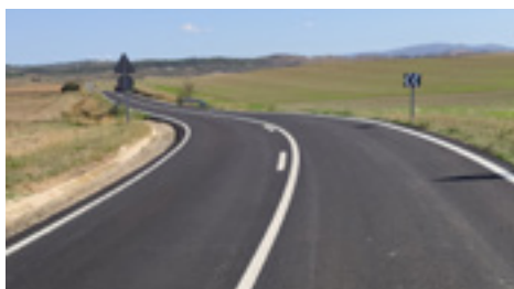
— 9 | Saneos de firme, refuerzo y saneo de aglomerado.
