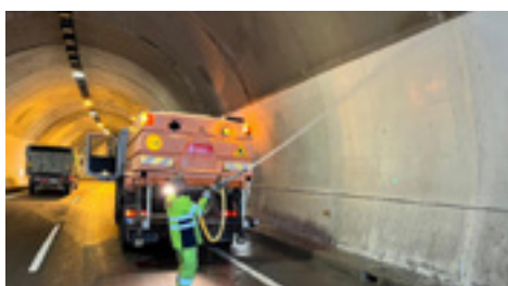
9 | Limpieza y pintura hastiales túneles.
