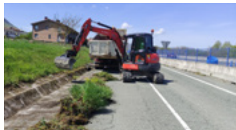
4 | Limpieza de cuneta de hormigón.
