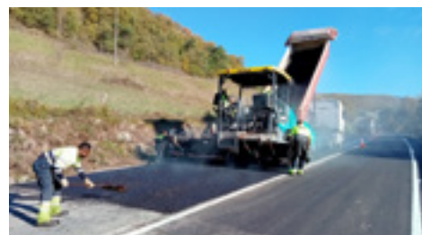
10 | Refuerzos y fresados con equipo de asfaltado.
