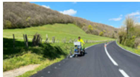
14 | Nueva señalización horizontal y repintado.
