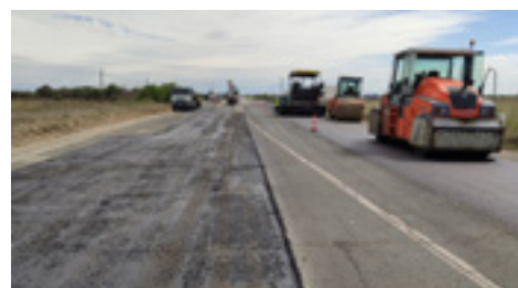
6 | Refuerzo de firme NA-8708 (P.K. 0+800 a P.K. 2+000).
