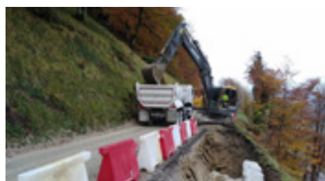
10 | Saneos y escolleras.
