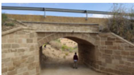
9 | Rehabilitación de puente, (río Queiles).
