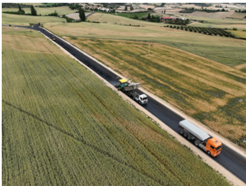
_Saneos y refuerzo de aglomerado en la NA-7310 Metauten.
