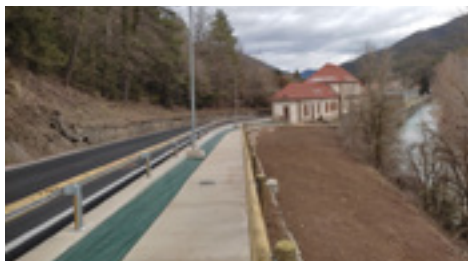
3 | Estabilización de acceso a cementerio de Roncal / Erronkari.
