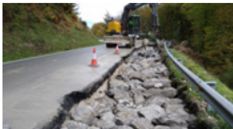
13 | Saneos y escolleras.
