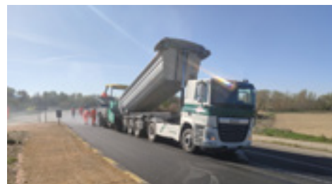
— 6 | Refuerzo y saneo de aglomerado.
