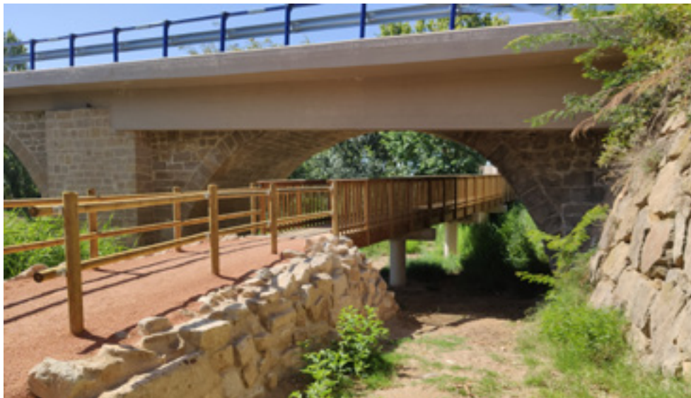
_AOP 2023-503 | Pasarela bajo la carretera NA-160. Cintrúenigo.
