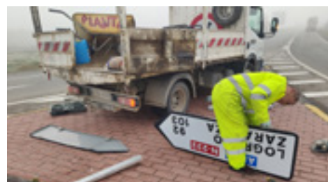
16 | Reposición de señalización vertical.
