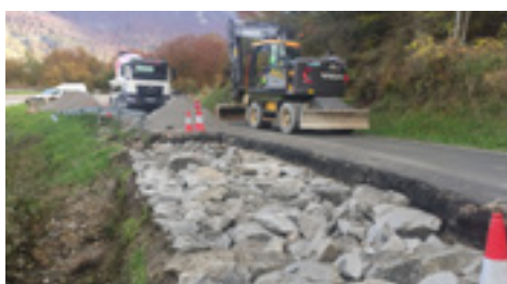
9 | Saneos y escolleras.
