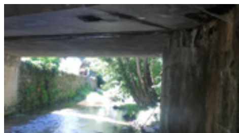
28 | Rehabilitación de estructuras.
