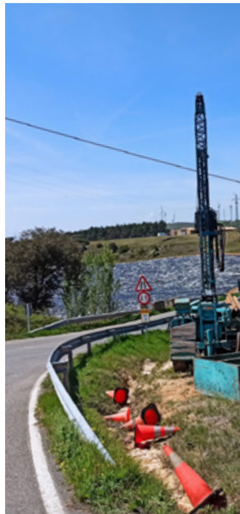
— Vista del emplazamiento del sondeo S-2 junto a la carretera NA-5010.
