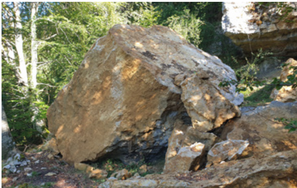
_Aspecto del bloque desprendido que obstruye el camino.
