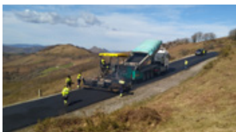
5 | Fresado y reposición de tramos pendientes hasta km 7.
