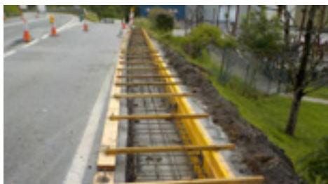
11 | Zunchos y recrecio de arcenes con hormigón.
