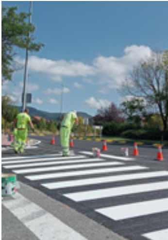
_Pintado de marcas viales en Olaz.
