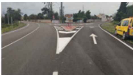
7 | Refuerzo de firme NA-6922 (P.K. 0+200 a P.K. 1+000).
