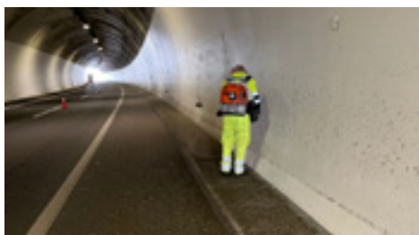
7 | Reposición de captafaros-catadióptricos.
