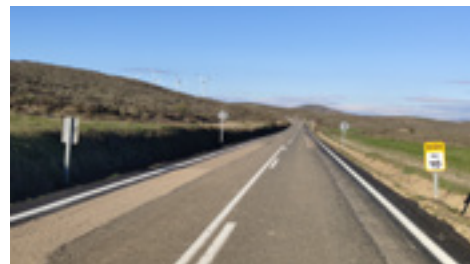
14 | Recuperación de márgenes de carretera.
