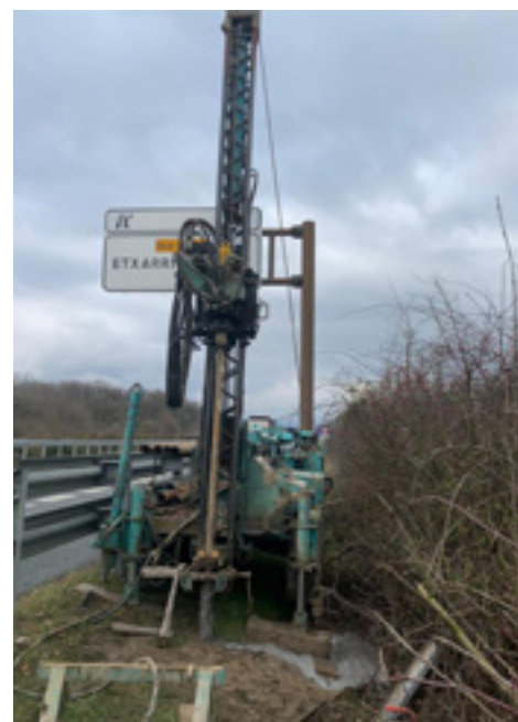
— Emplazamiento del sondeo S-1 en el arcén de la A-10.
