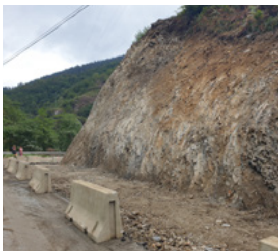
_Aspecto del talud excavado en esquistos en la carretera a Goizueta NA-4150.
