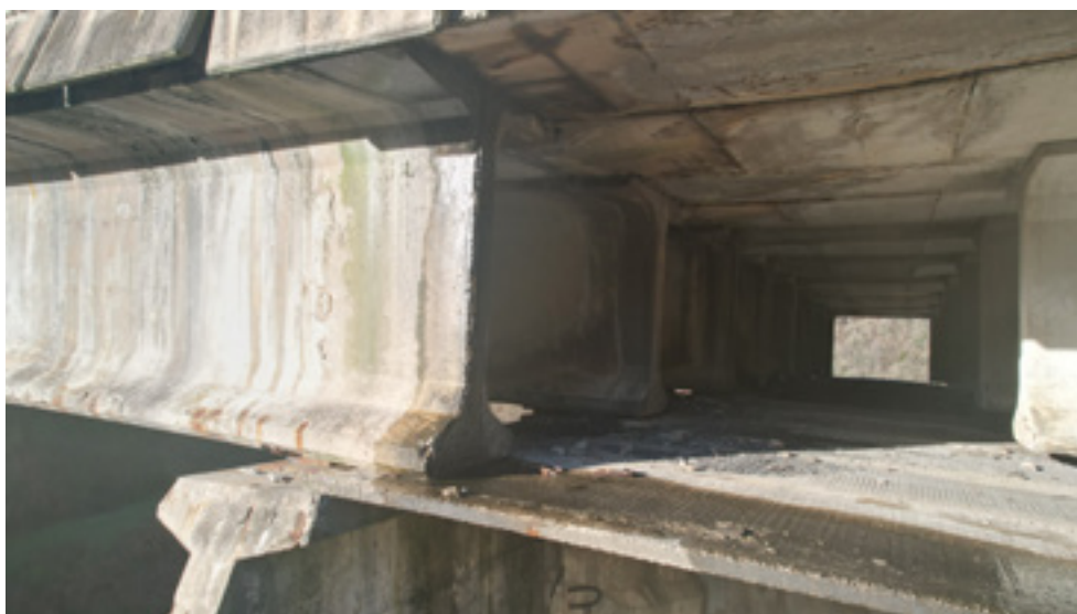
_Detalle de apoyo de las vigas.
