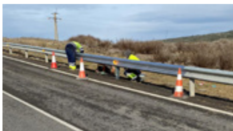
17 | Reposición de barrera de seguridad.
