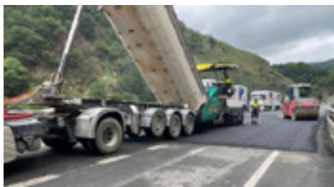
1 | Fresado y reposición.
