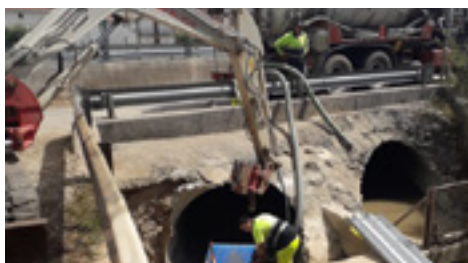
17 | Limpieza y hormigonado en balsa Uharte Arakil.
