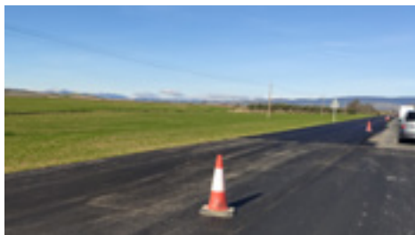
— 3 | Refuerzo y saneo de aglomerado.
