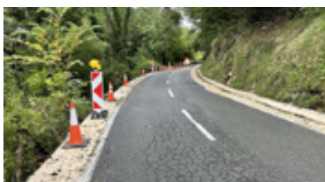
9 | Ejecución de cuneta de hormigón entre los PP.KK. 9+000 y 12+000.
