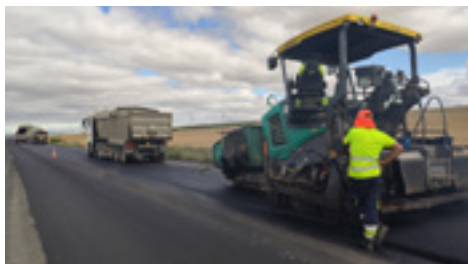
3 | Refuerzo de firme NA-134 (P.K. 65+000 a P.K. 66+380).
