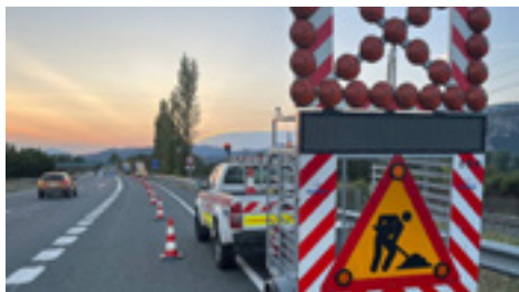
13 | Trabajos atención a la vialidad.
