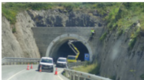
21 | Saneo y pintado de revestimiento de túnel.
