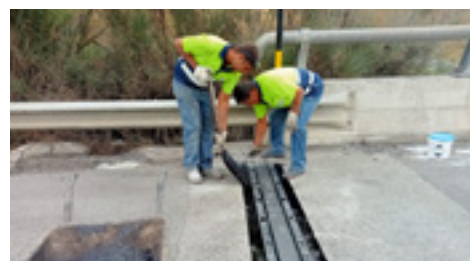
16 | Juntas de dilatación de puentes.
