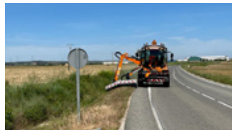
14 | Limpieza de calzada y desbroce de márgenes (2 y 4 m).
