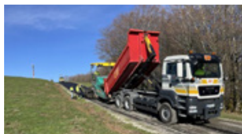
6 | Acondicionamiento y refuerzo con MBC.
