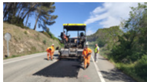
— 2 | Refuerzo y saneo de aglomerado.
