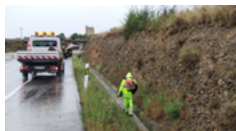
20 | Limpieza de calzada, cunetas y rebaje de márgenes.
