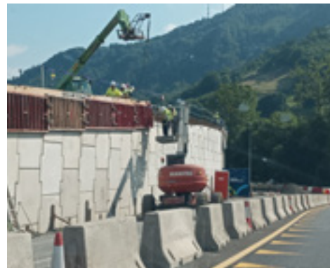
_Encofrado de aletas en obra de tierra armada.
