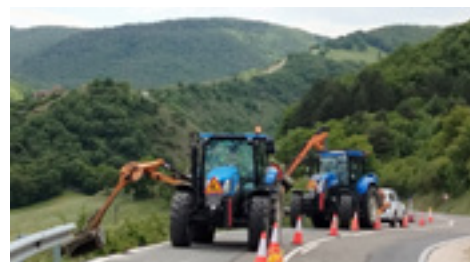
2 | Desbroce de márgenes de carreteras.
