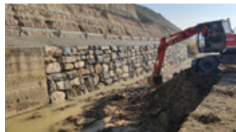
12 | Ejecución de escolleras por inundaciones.
