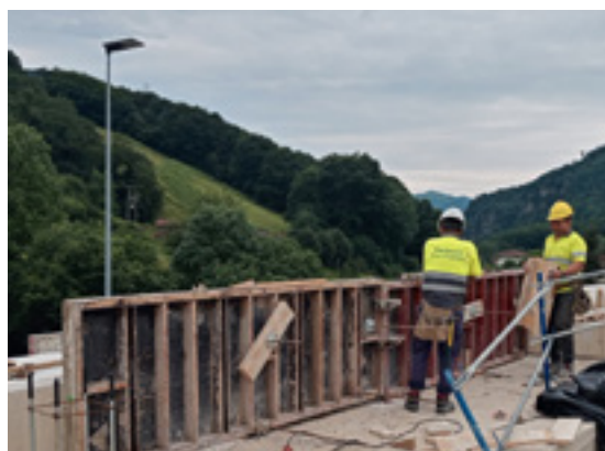
_Trabajos en el paso superior de Sunbilla, N-121-A.
