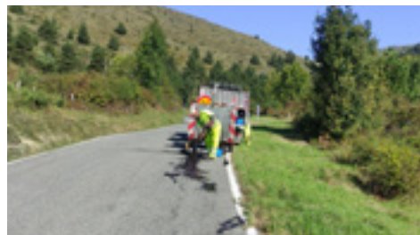
24 | Bacheo en frío.
