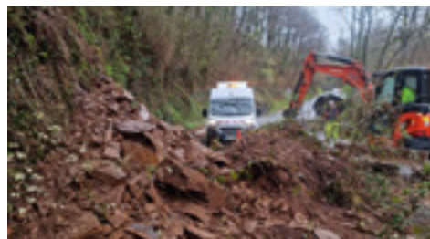
22 | Salidas de emergencia.
