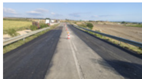
— 10 | Refuerzos y fresados con equipo de asfaltado.
