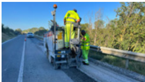
13 | Bacheo con extendidora.
