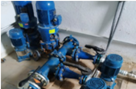
_Uztárroz. Reparación de bombas en el depósito base para abastecimiento de agua a la población.
