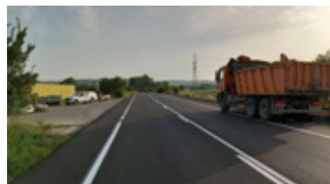
8 | Refuerzo de firme NA-6840 (P.K. 0+260 a P.K. 2+540).
