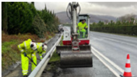
3 | Limpieza de caz y cunetas de hormigón.
