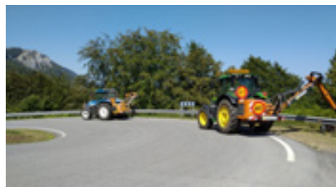
2 | Desbroces a 2 y 4 m de anchura.
