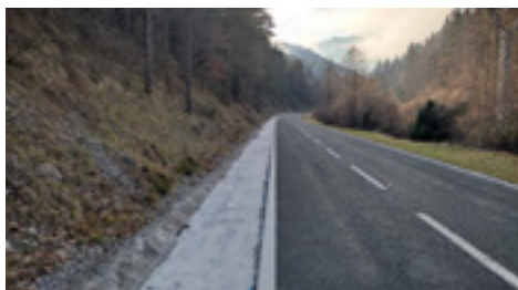
1 | Recrecido de cuneta y mejora de trazado.
