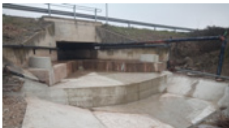
1 | Reparación en puente.
