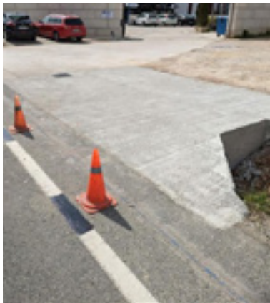
_AOP 2023-76 | Ampliación acceso en la carretera NA-7040. Puente la Reina / Gares.
