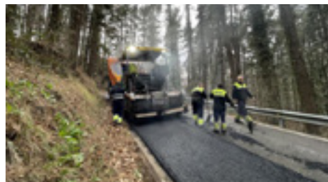
4 | Fresado y reposición de varias carreteras.
