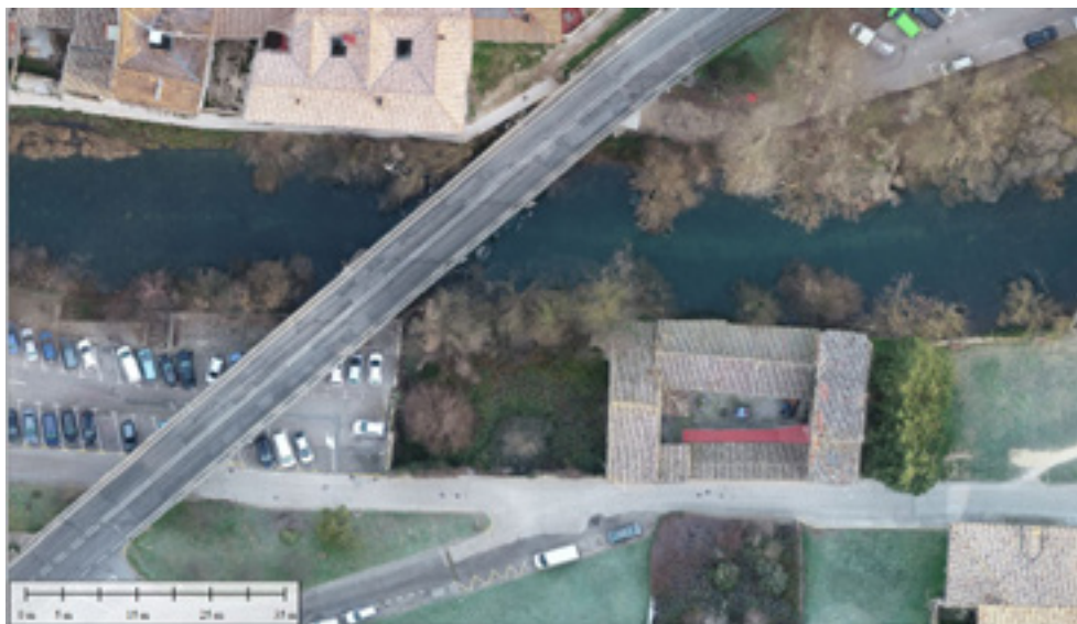
_Ortofotografía de 3 cm de píxel del puente Fortunato Aguirre.
