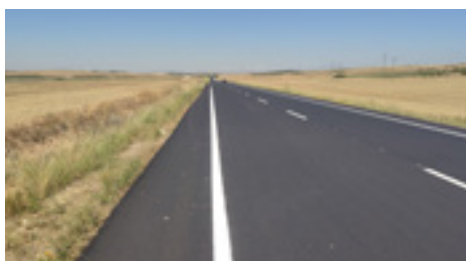
15 | Repintado de la Red Local y de carreteras afectadas por trabajos de MBC.
