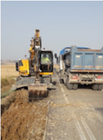
_Saneamiento de calzada NA-6140.
