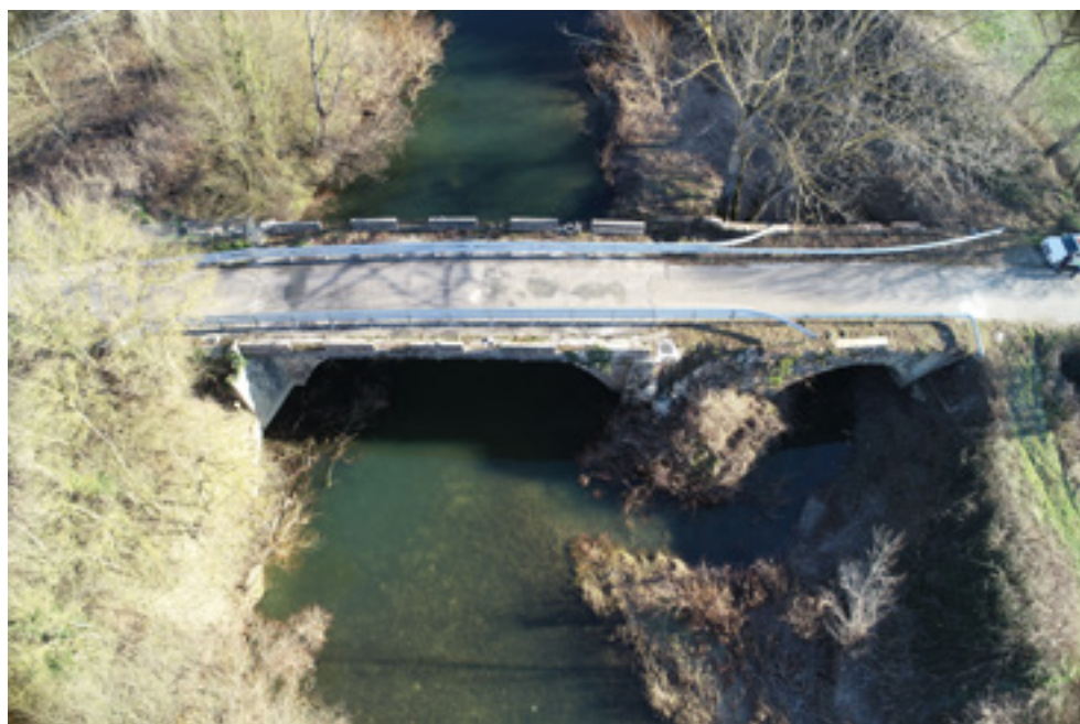
_Fotografía del puente.
