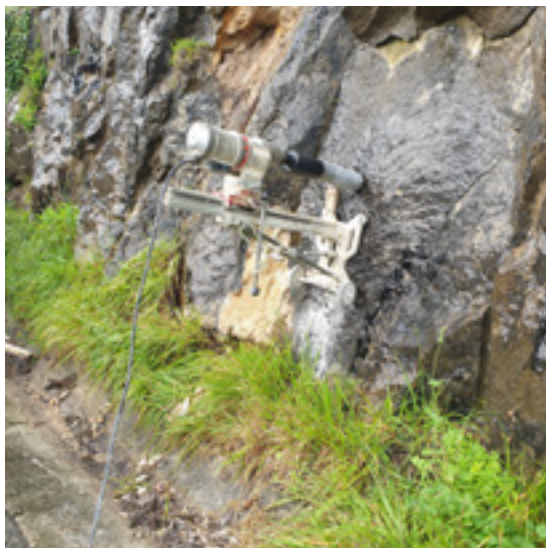
_Extracción de un testigo de roca a la altura de la intersección a Saragüeta en la carretera NA-1720.
