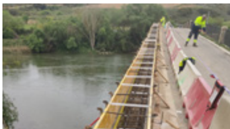
11 | Rehabilitación estructura, cambio sistema contención.
