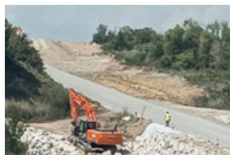
_Colocación de escollera.
