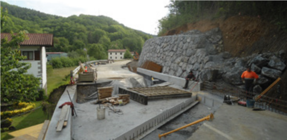
_AOP 2023-168 | Construcción de carril bici y paso inferior en la carretera NA-4000. Lesaka.
