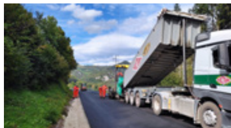
6 | Mejora de firmes.
