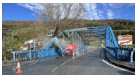
10 | Mantenimiento de la estructura metálica.
