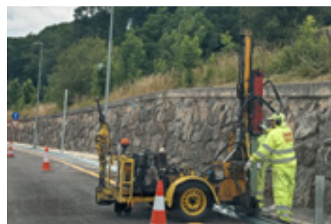
_Penetración de postes para bionda.
