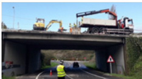
15 | Ejecución de zuncho para instalación pretil tipo H-3.
