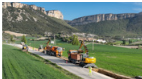
4 | Saneos y refuerzo aglomerado.
