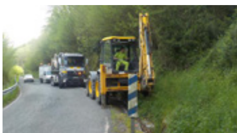
19 | Limpieza de obras de fábrica.
