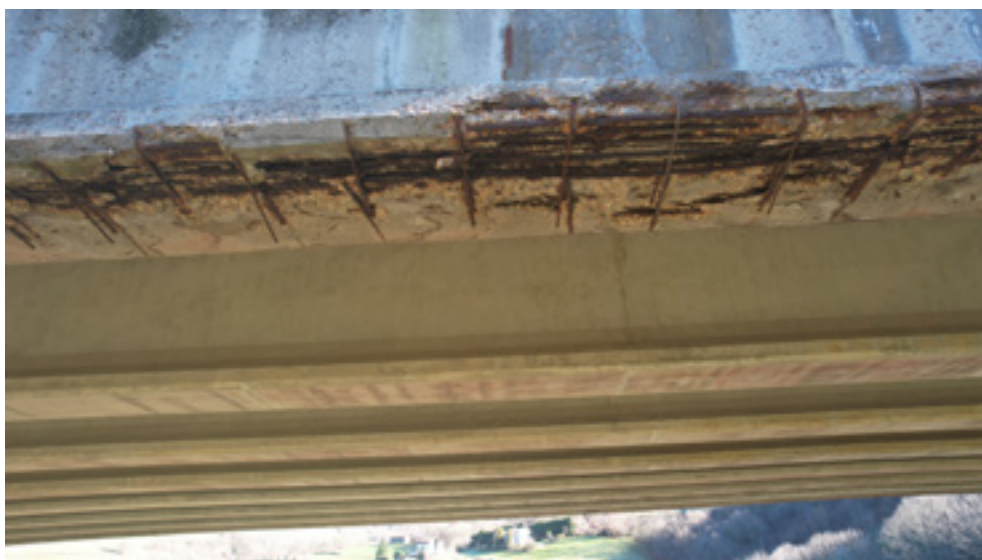
_Detalle de la parte inferior de las vigas.
