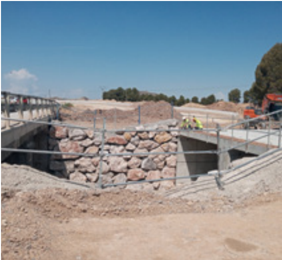
_Protección con vallado provisional en obra.
