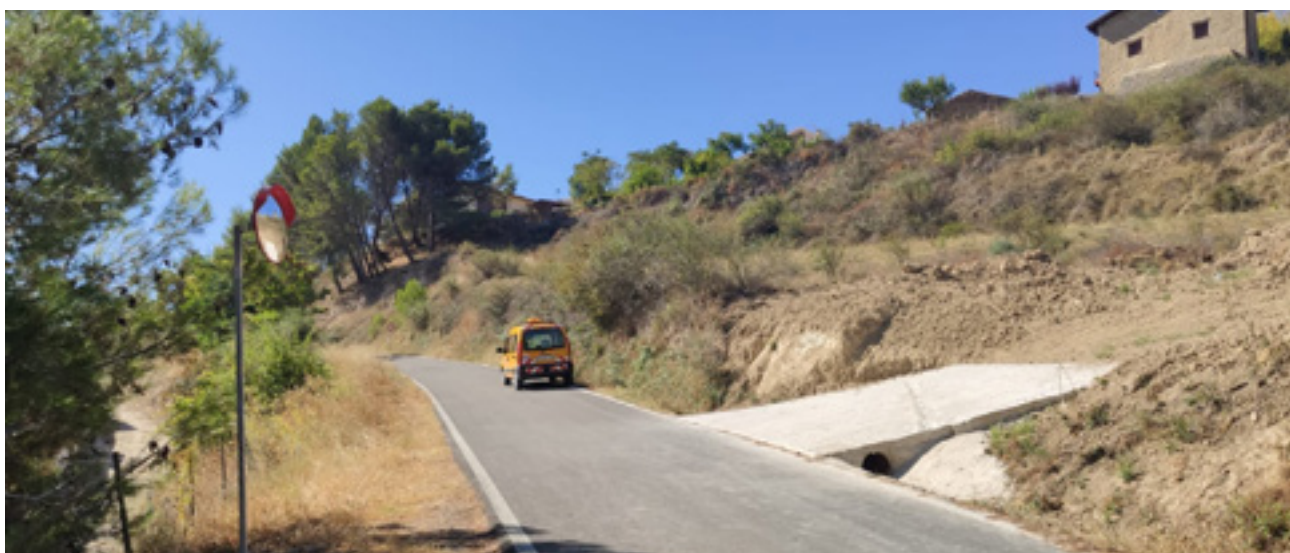
_AOP 2023-276 | Mejora de acceso en la carretera NA-7251, Armañanzas.
