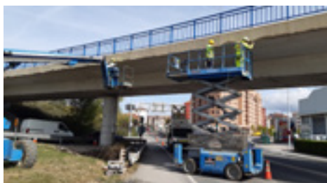
17 | Reparaciones en estructuras.
