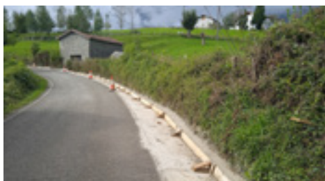
7 | Saneos, ensanches y cunetas pisables de hormigón.
