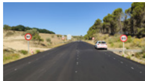
2 | Refuerzo de firme NA-134 (P.K. 59+870 a P.K. 60+980).
