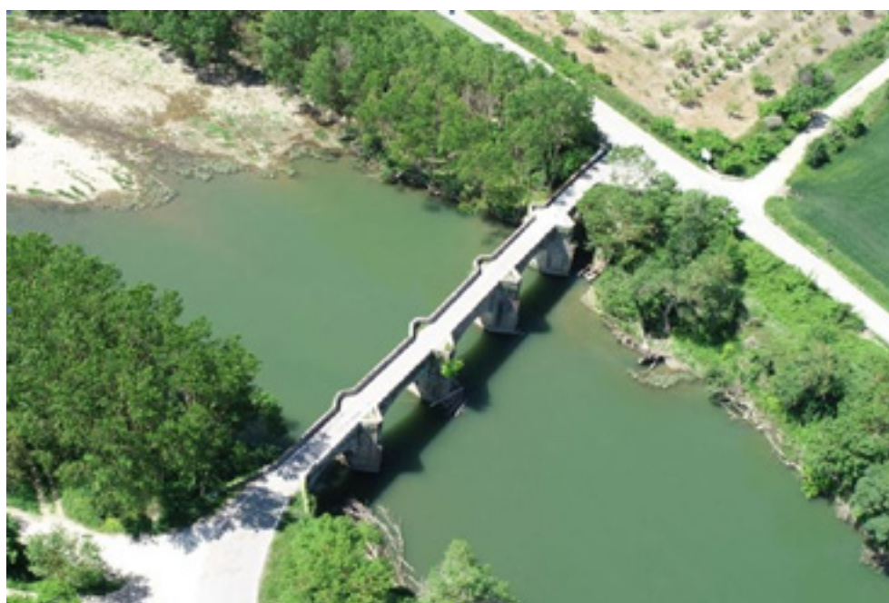
_Imagen utilizada para la realización de la ortofotografía del puente.
