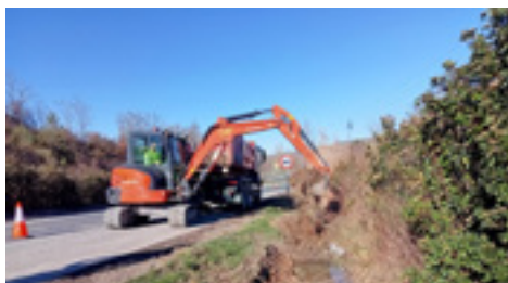
5 | Limpieza de cunetas de tierra, hormigón y arcenes.
