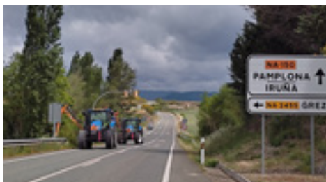
5 | Limpiezas y desbroces.
