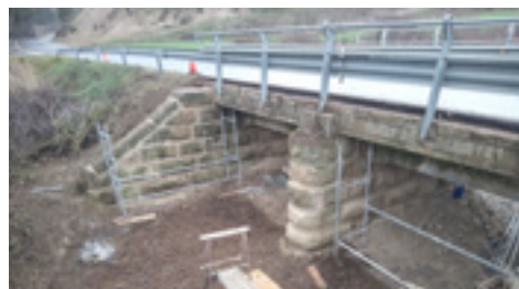
2 | Reparación en puente.
