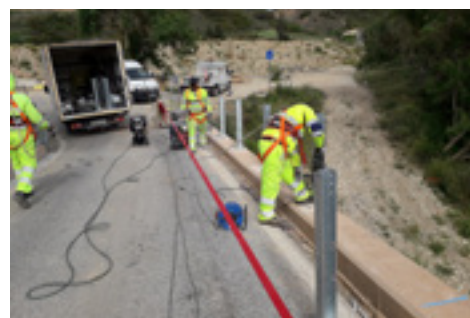
_Colocación postes en pretil.
