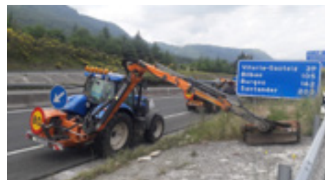
6 | Desbroce de márgenes.
