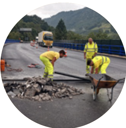
_Colocación de junta de dilatación sobre tablero de puente.
