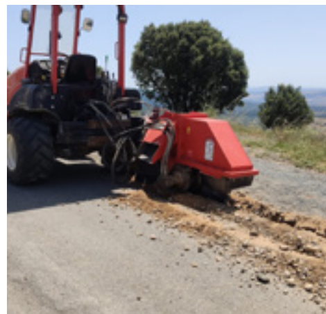
AOP 2023-142 | Conducciones de fibra óptica en la carretera NA-9103. Alto de El Perdón.
