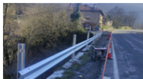
20 | Colocación y recolocación de barrera bionda.
