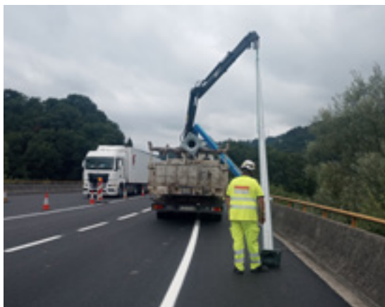
_Colocación de los postes de alumbrado.
