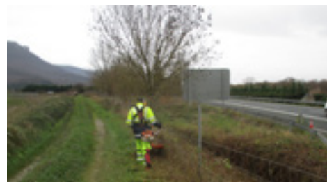
16 | Desbroce de malla de cerramiento.
