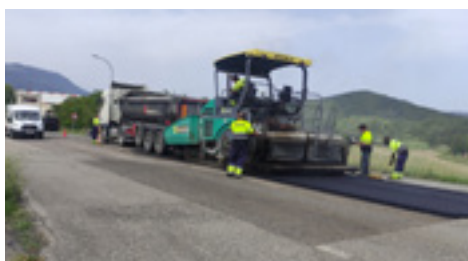
5 | Refuerzo de firme con MBC.
