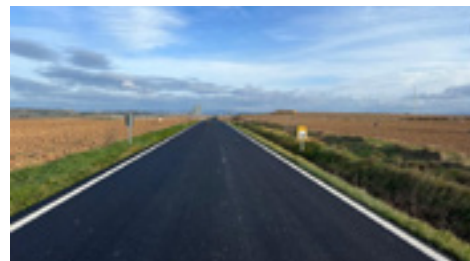
— 8 | Refuerzo y saneo de aglomerado.
