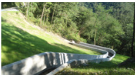
13 | Obras de fábrica realizadas.
