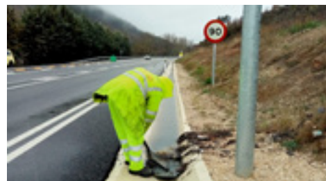
6 | Limpieza de drenajes y obras de fábrica.
