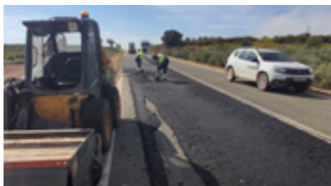
— 1 | Refuerzo y saneo de aglomerado.
