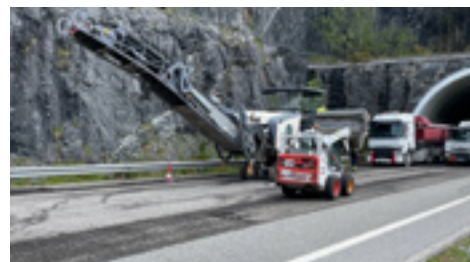
2 | Fresado y extendido de aglomerado.
