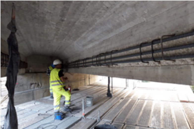
_Reparación de puente en Estella.
