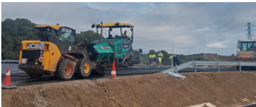
_Trabajos de asfaltado.
