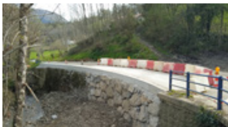
11 | Saneos y escolleras.
