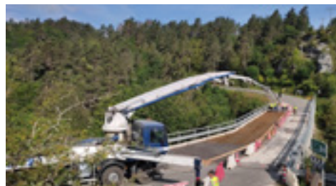
4 | Reparaciones de puentes.
