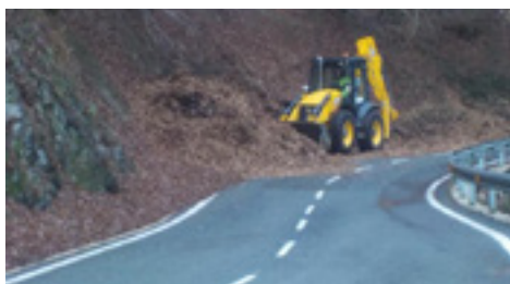
17 | Limpieza cunetas hormigón.
