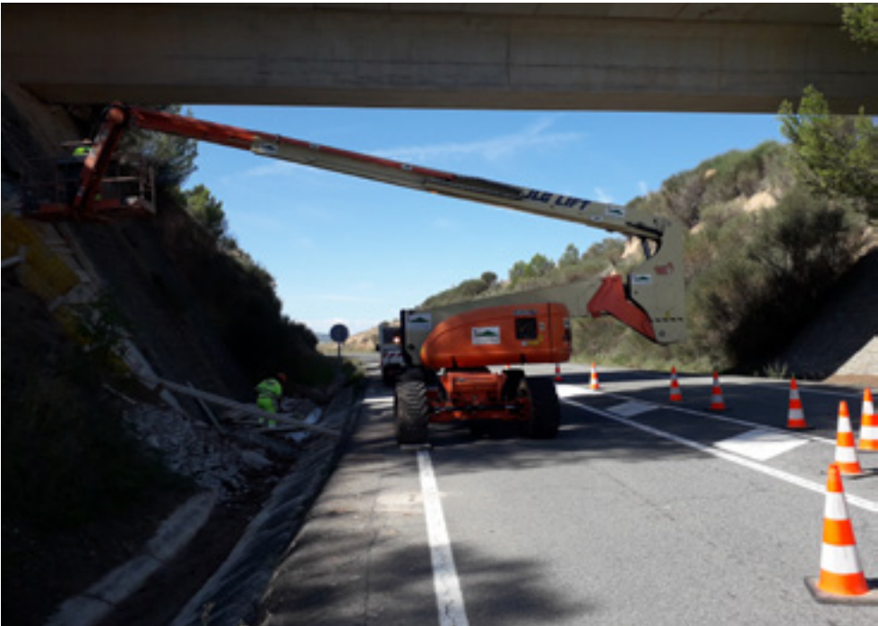
_Contención de talud NA-1120.
