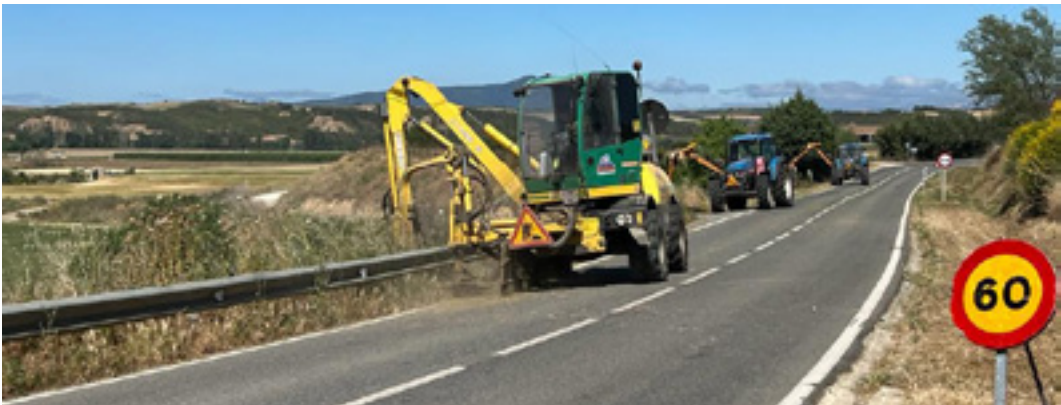
_Limpieza de calzada y desbroce de márgenes.
