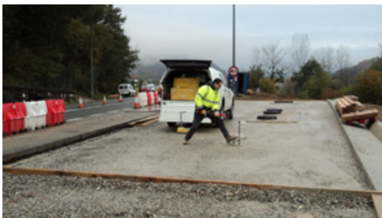
— Determinación de la densidad de compactación in situ.
