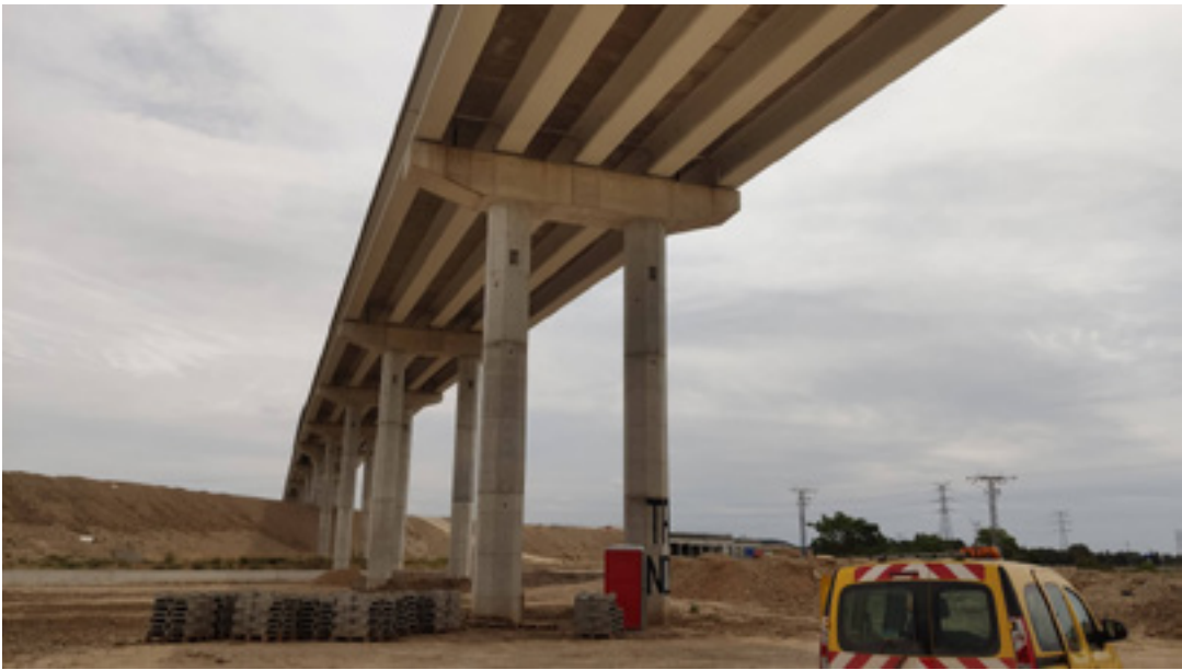
_AOP 2021-425 | Nuevo viaducto en nuevo trazado de la carretera NA-660. Marcilla.
