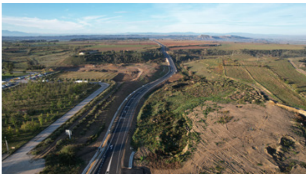
_ Reforma de la carretera NA-128 entre Caparros y Mérida.
