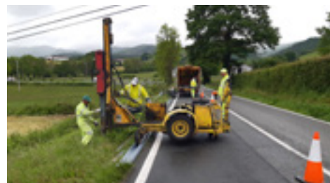
12 | Barreras de seguridad y malla de cerramiento.
