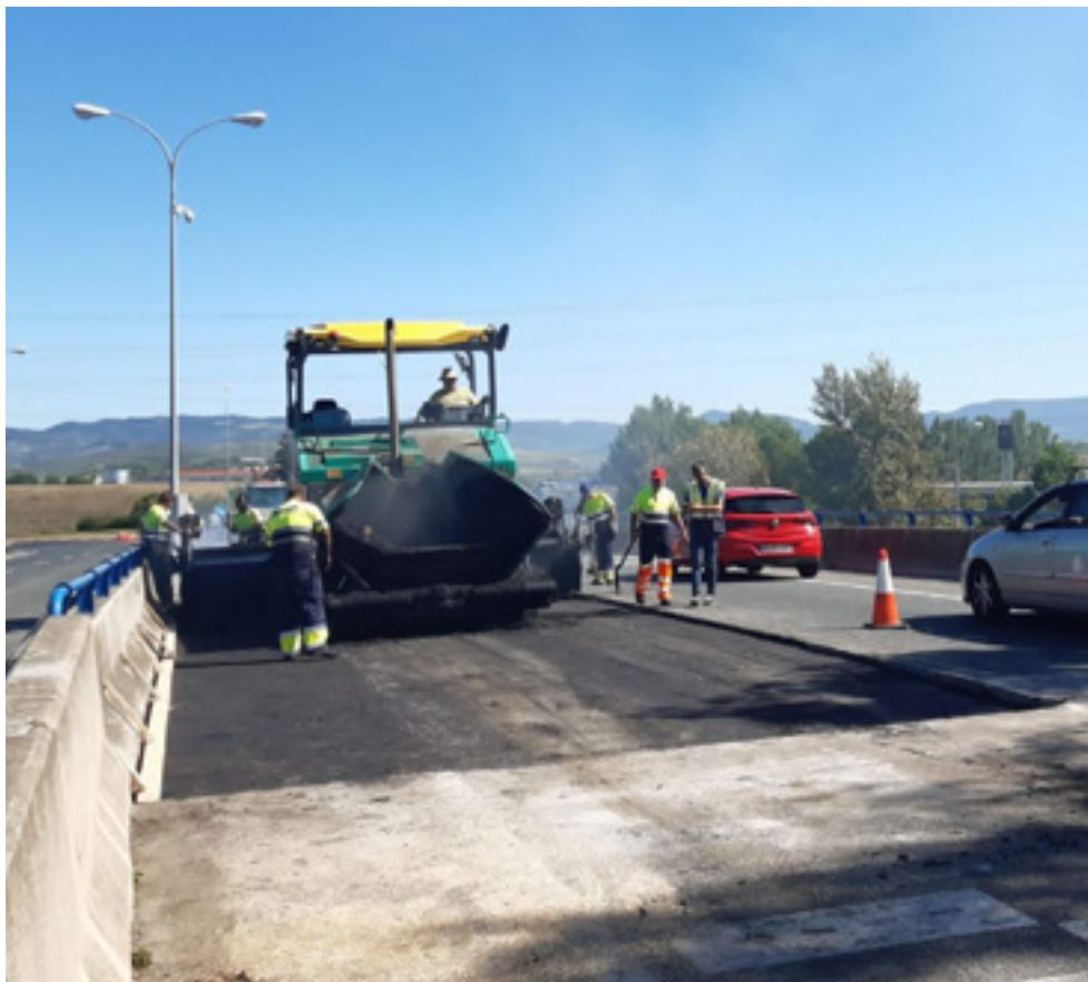
_Refuerzos y fresados con equipo de asfaltado.
