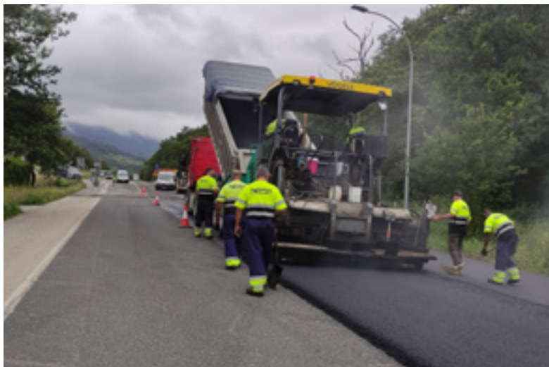
_Refuerzo de firme en NA-2410.
