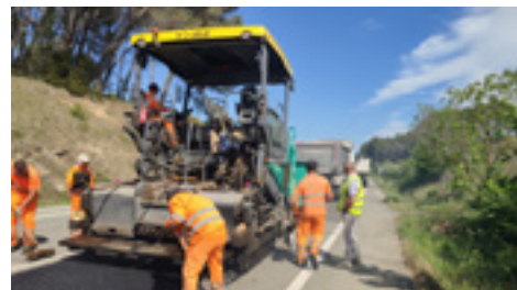
— 4 | Refuerzo y saneo de aglomerado.
