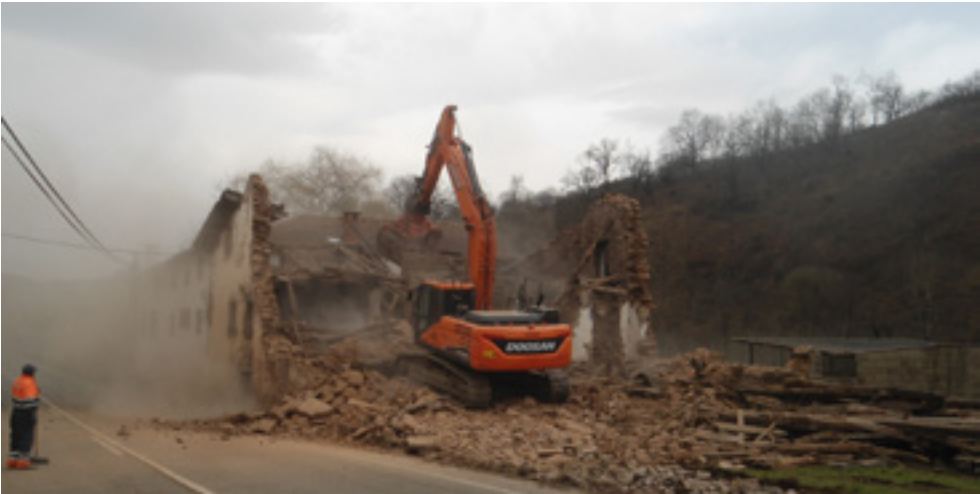
_AOP 2022-612 | Demolición edificio en la carretera N-121-B. Arizkun.
