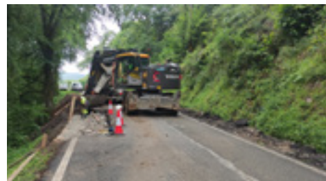
14 | Saneos y escolleras.
