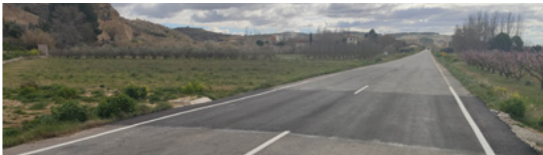
AOP 2023-107 | Cruce conducción riegos bajo la carretera NA-8715. Andosilla.
