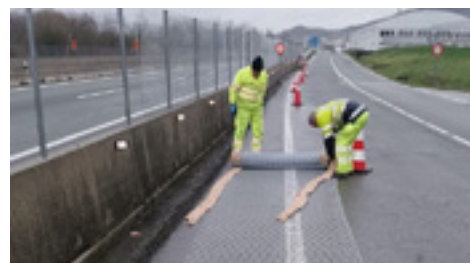
8 | Colocación de malla de cerramiento.
