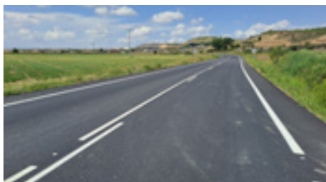
— 5 | Refuerzo y saneo de aglomerado.
