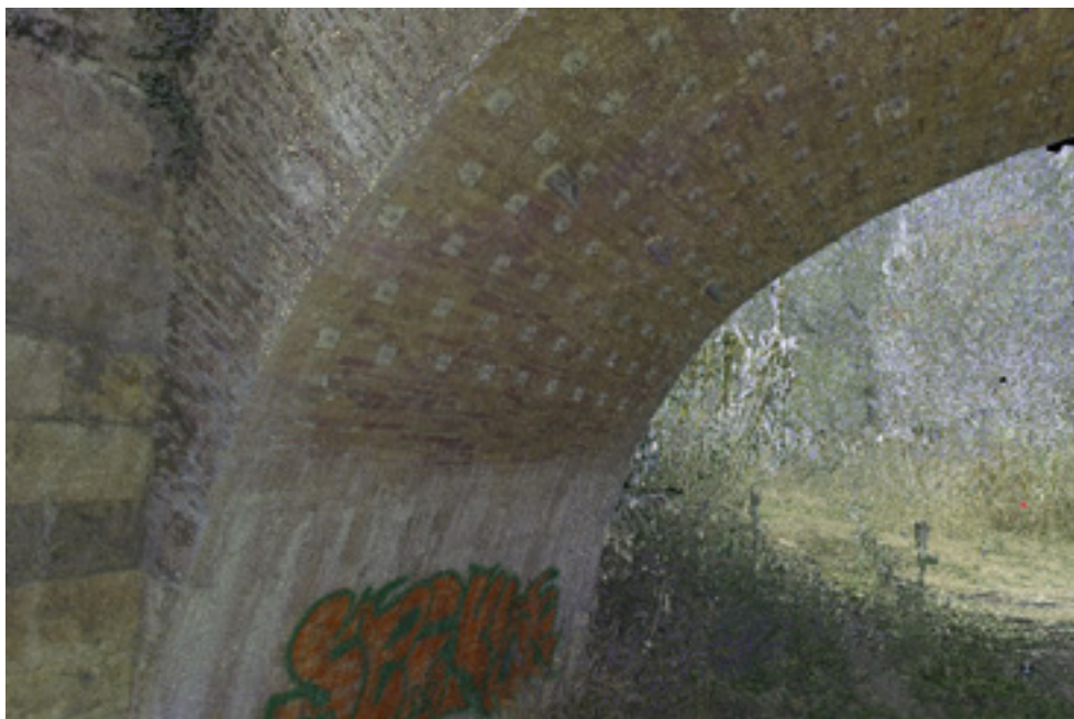
_Detalles de la nube de puntos 3D del puente de Fitero sobre el río Alhama.
