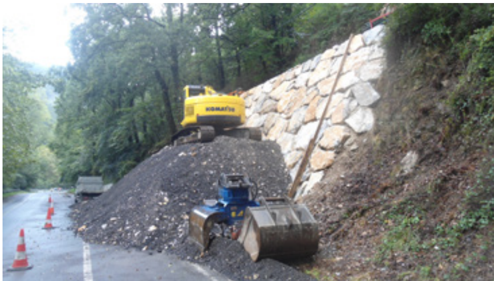
_AOP 2023-451 | Refuerzo canal y talud en la carretera NA-1210. Bera.
