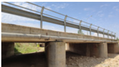
11 | Rehabilitación de puente en Fustiñana.
