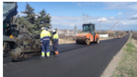
4 | Refuerzo de firme NA-6920.
