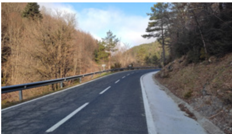
_ Recrecido de la cuneta de hormigón y mejora de trazado en curva en la NA-140.
