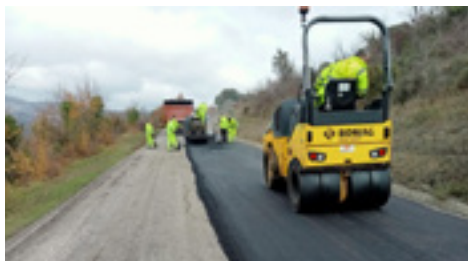
3 | Fresado y reposición de asfalto con miextendedora.
