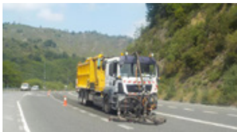
3 | Retexturizado entre los PP.KK. 64+970 y 65+895.
