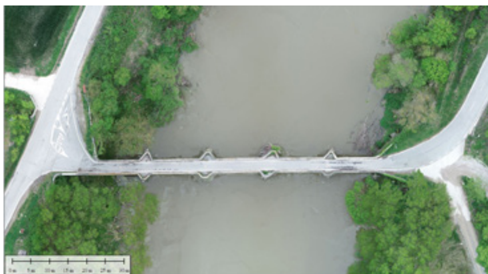
_Ortofotografía de 3 cm de píxel del puente.
