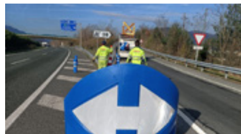
12 | Reposición de elementos de balizamiento (balizas divergentes, hitos H-75).
