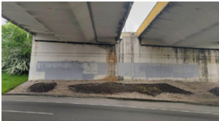
AOP 2023-320 | Instalación de conducción fibra óptica en estructura de la vía desdoblada PA-30. Egüés.
