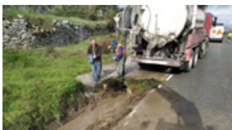
19 | Limpieza de obras de fábrica, pocillos y salvacunetas.
