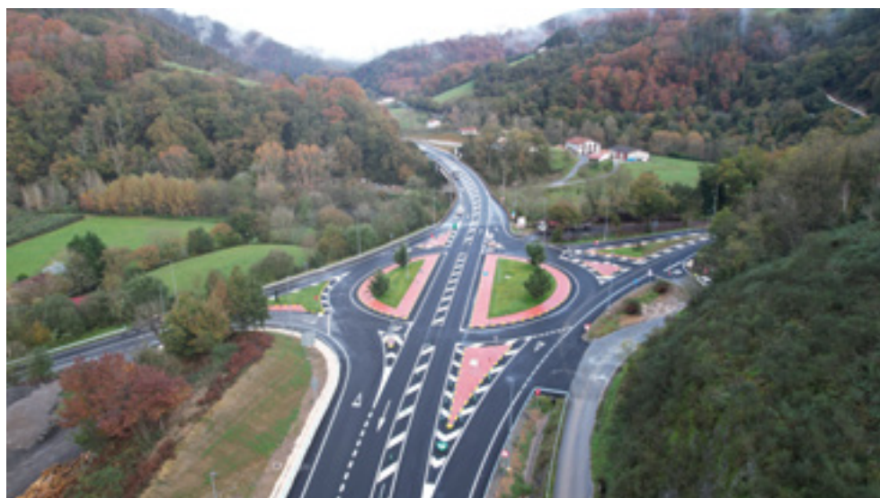
_Intersección de Sunbilla - norte en el P.K. 51 de la carretera N-121-A.
