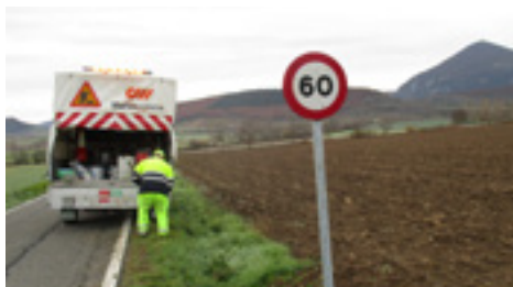
13 | Mantenimiento de señalización vertical y balizamiento.
