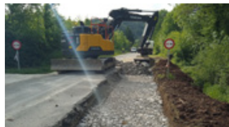
12 | Saneos y escolleras.
