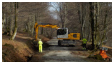
18 | Limpieza cunetas de tierra.
