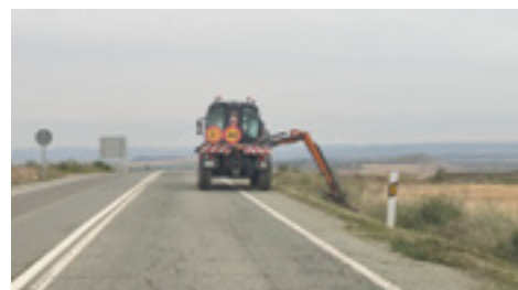
18 | Desbroce de márgenes.
