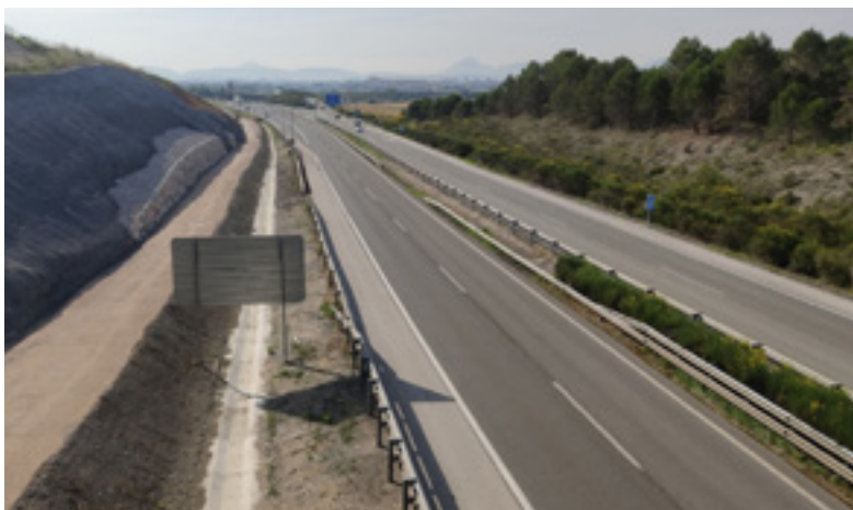
_AOP 2022-595 | Colector de saneamiento en la autopista AP-15. Berrioplano / Berriobeiti.
