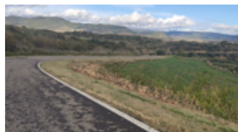
16 | Limpieza de cunetas en tierras y hormigón. Pantalla vegetal y podas.
