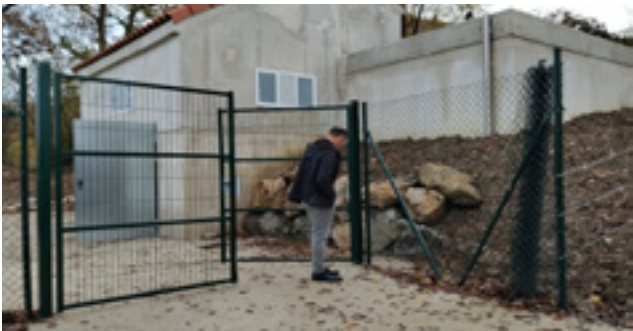
_Servicios de Ultzanueta. Renovación red en alta en Iraitotz y urbanización Iraitotz.
