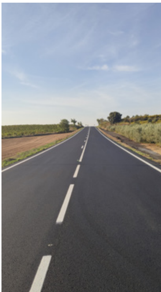
_Refuerzo y saneo de aglomerado.
