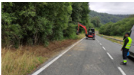
17 | Limpieza de cuneta de tierra y rebaje de bermas.
