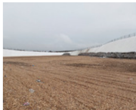
_ Montejurra. Ampliación de la fase 3 subcelda 1 del vertedero de Cárcar.
