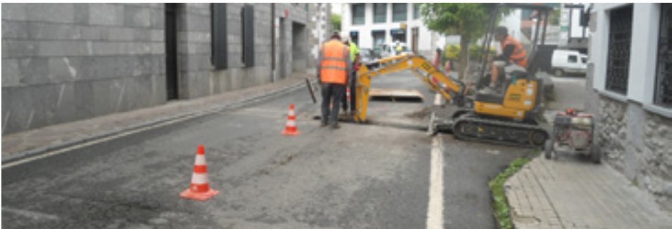
_AOP 2023-78 | Cruce conducción gas bajo la carretera NA-4000. Lesaka.
