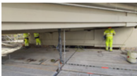
5 | Reparación en puente.
