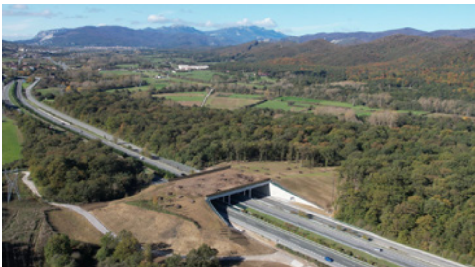
_ Ecoducto en el PK 21+850 de la carretera A-10.
