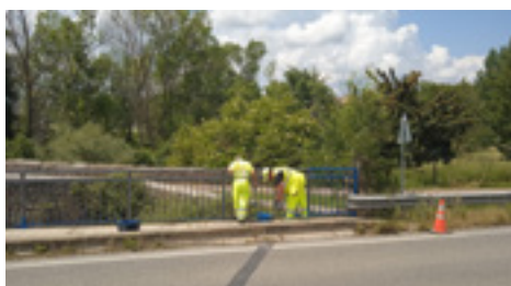
15 | Mantenimiento de barandillas de puentes.
