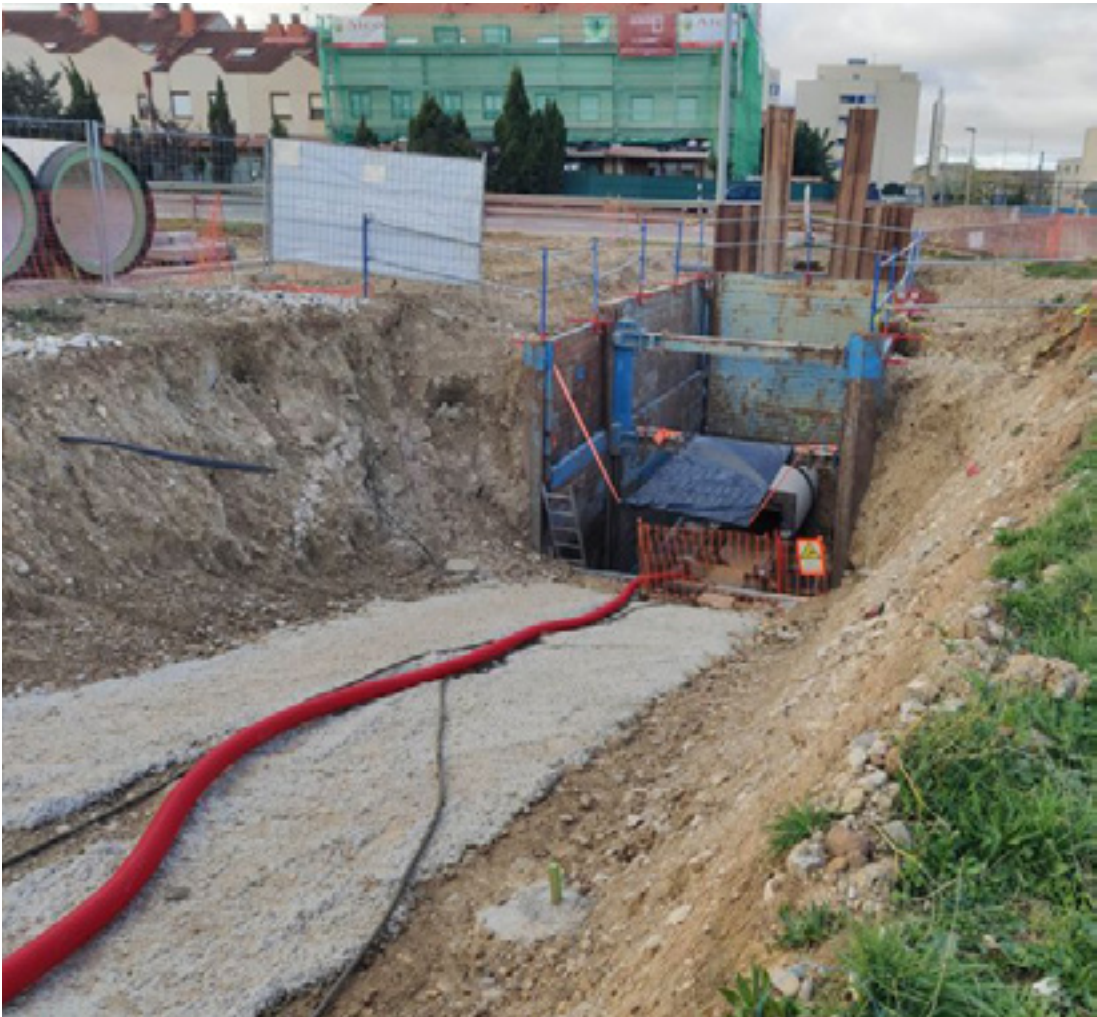
_AOP 2023-549 | Hinca colector bajo la carretera N-121. Beriáin.
