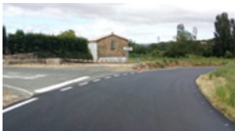
— 7 | Refuerzo y saneo de aglomerado.
