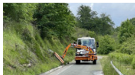
16 | Desbroce de taludes.
