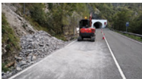
15 | Vaciado, reparación de mallas en taludes e instalación de nueva barrera dinámica.
