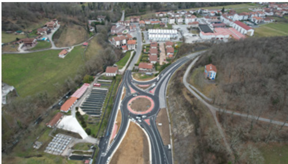
_Rotonda de Ornoz en el P.K. 41+750 de la carretera N-121-B.
