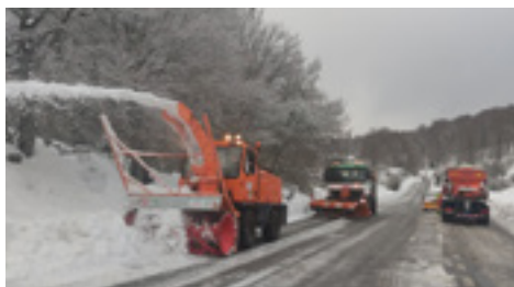
1 | Vialidad invernal y reparación de silos de sal.
