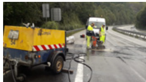
14 | Reparaciones estructuras (incluye juntas de dilatación).
