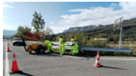
4 | Reposición y recolocación de barrera de seguridad.
