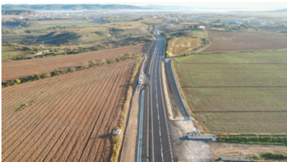
_Reforma de la carretera NA-128 entre Caparrosos y Mérida.
