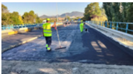
9 | Impermeabilizaciones de tableros de puentes.
