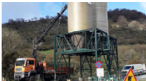
11 | Trabajos en silos.
