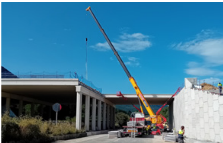
_Trabajos con gruas en el ecoducto sobre A-10.
