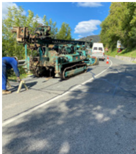
– Emplazamiento del sondeo S-1 en la calzada de la carretera NA-718.
