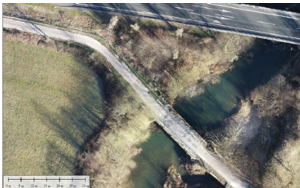
_Ortofotografía de 3 cm de píxel del puente de Arruazu.
