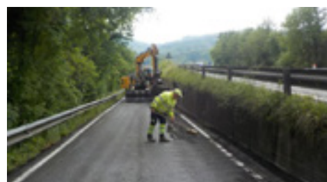
20 | Limpieza y rebaje de arcenes.
