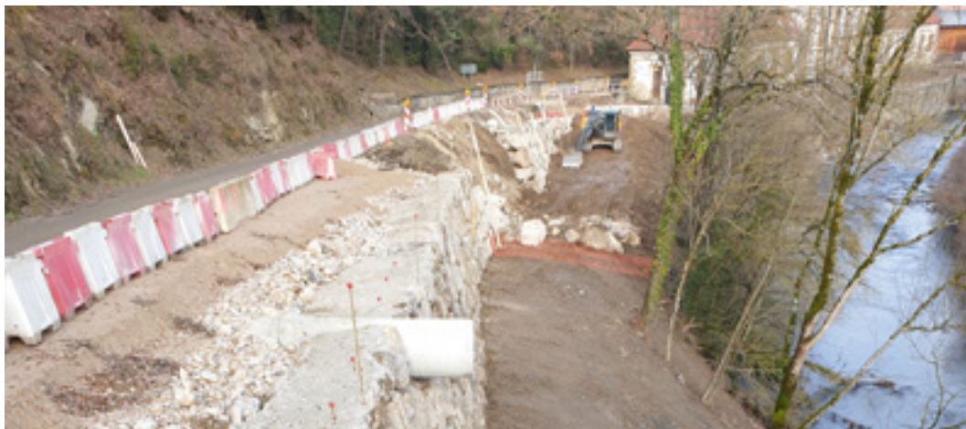
_Vista general de la escollera construida para el ensanchamiento de la calzada de la carretera NA-9202.
