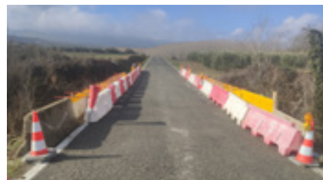
12 | Rehabilitación estructura, cambio sistema contención.
