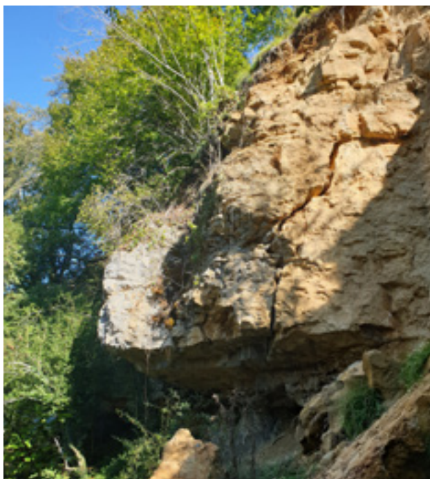
_Grieta abierta en el lateral del bloque con riesgo de desprendimiento y vista del voladizo originado por la erosión de las margas que afloran en su base.
