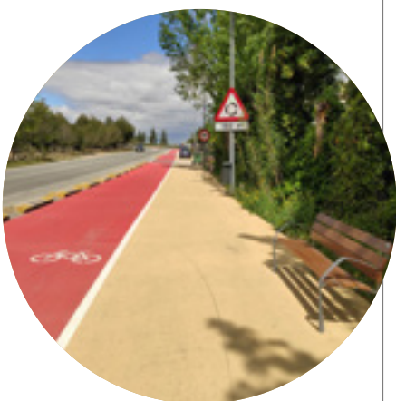
- AOP 2022-601 | Carril bici y paseo peatonal en la carretera NA-5230. Tudela-Fontellas.
