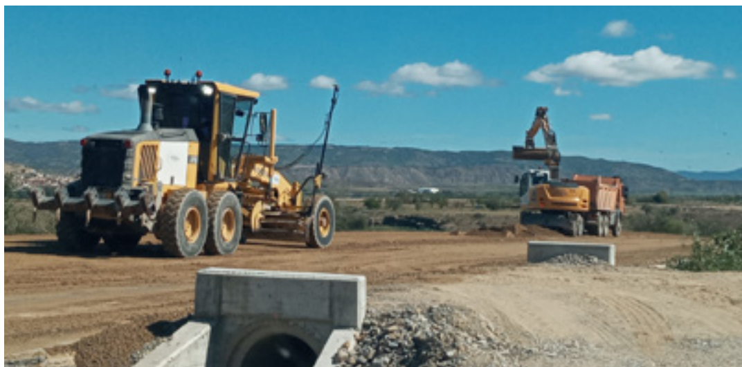
_Preparación de terraplén en traza.
