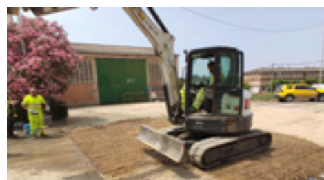
10 | Renovación de obra de fábrica Ø1500 mm.
