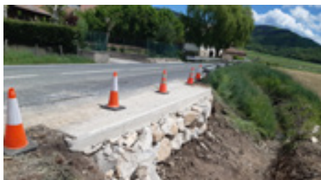
11 | Saneos, desmontes y ensanches.
