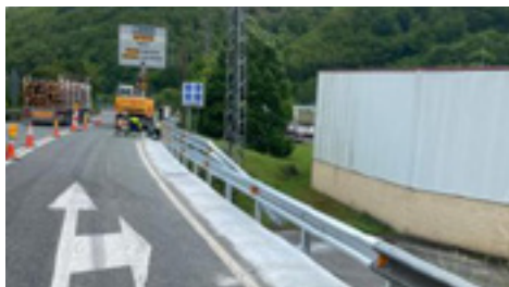
23 | Barrera de seguridad colocada.
