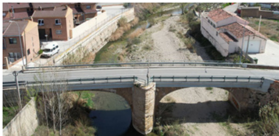
_Imagen lateral del puente.
