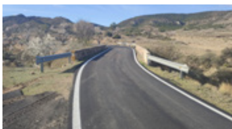
5 | Refuerzo de firme NA-6991 (Tramos).
