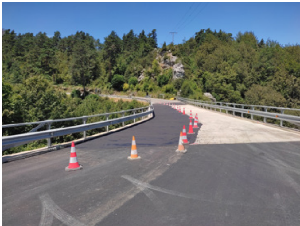
_Reparaciones en puentes en diferentes carreteras del distrito Aoiz / Agoitz.
