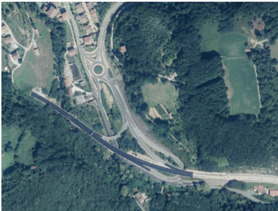
_Imagen nueva rotonda entrada a Mugairi y obras en N-121-A.
