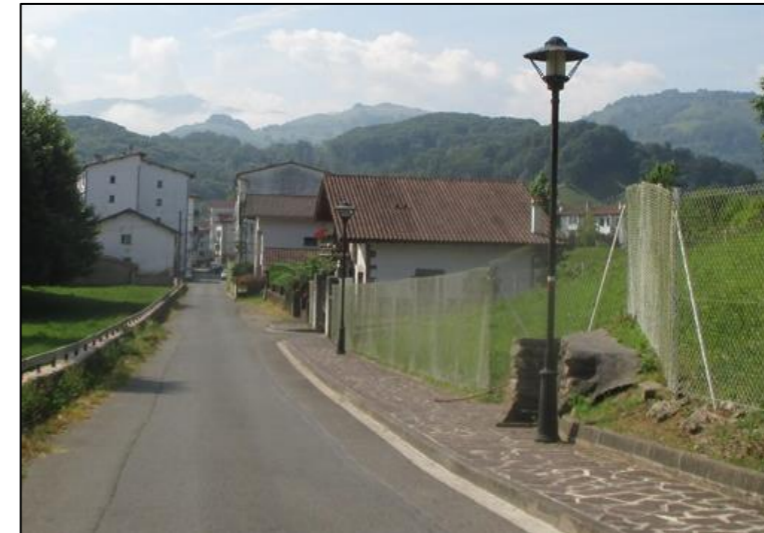
Alumbrado existente en calle Menditurri a la altura de la Policía Foral. Imagen en sentido sur
