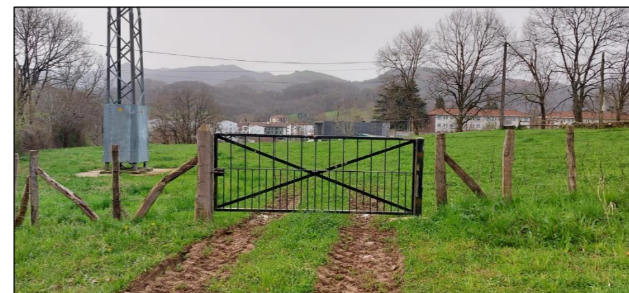
Cerramiento actual afectado, correspondiente a parcela 132 del polígono 17
