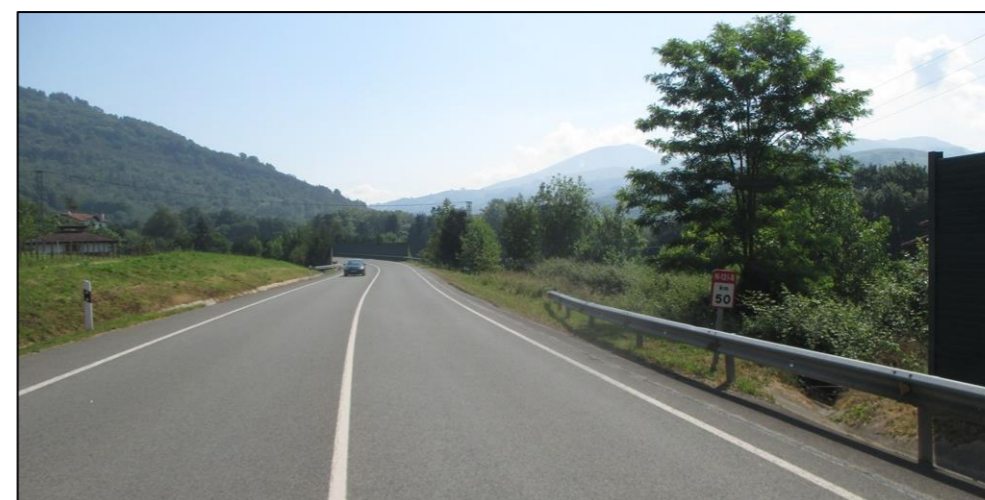
PK 50+000 de la carretera N-121 B, sentido creciente.
