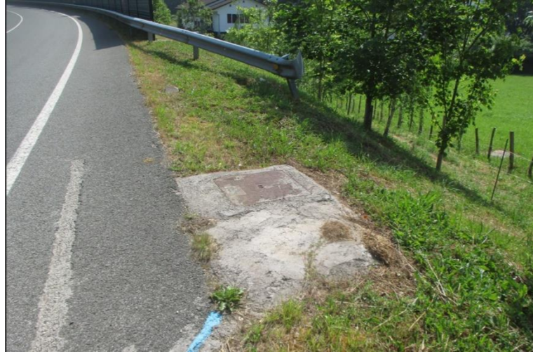
Arqueta sobre N-121 B para derivación de fibra óptica a Comisaría de Elizondo
