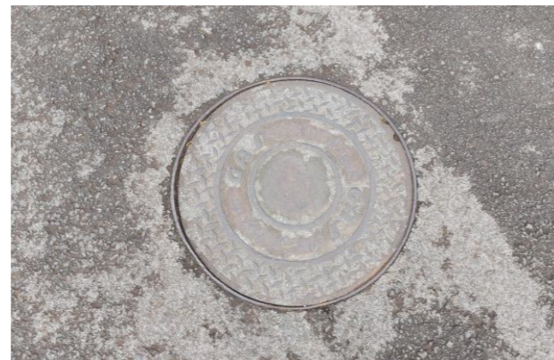
Pozo existente en la zona sur de la actuación
