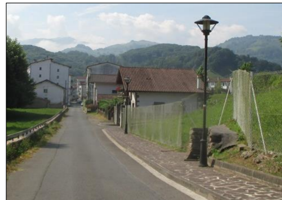
Ilustración 2. Alumbrado existente en calle Menditurri a la altura de la Policía Foral. Imagen en sentido sur.
