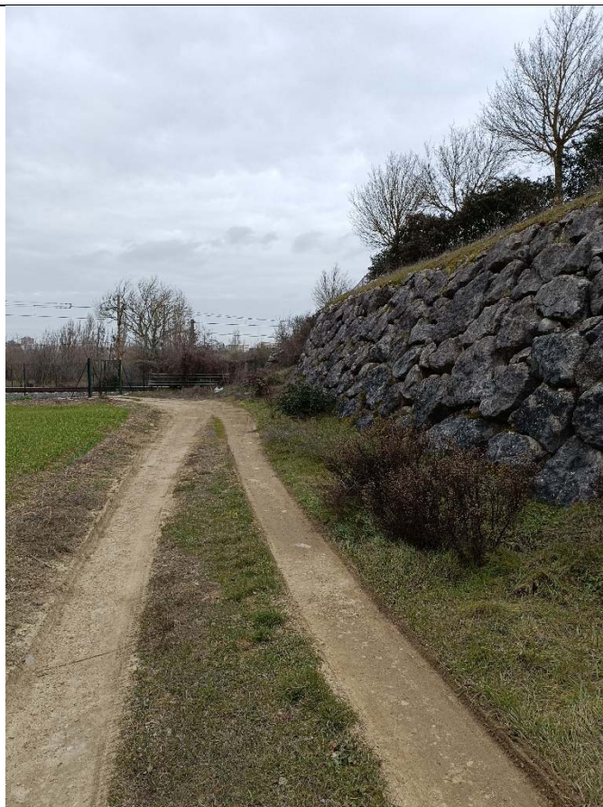
6. Camino de servicio paralelo a muro de escollera a continuación de pasarela peatonal
