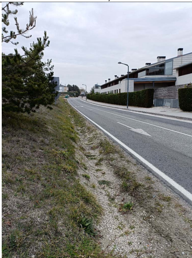
11. Cuneta en tierras MI de la carretera NA-6053
