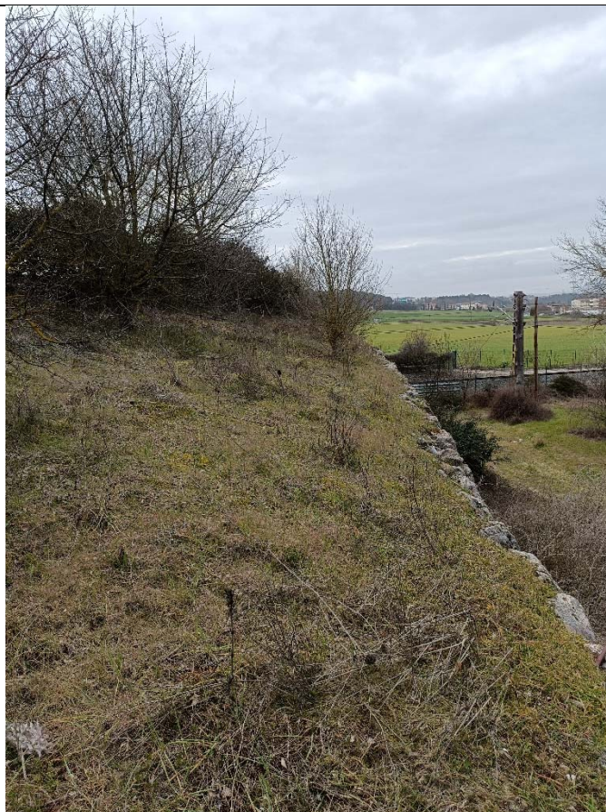
4. Muro de escollera previo a la pasarela peatonal sobre la línea de ferrocarril
