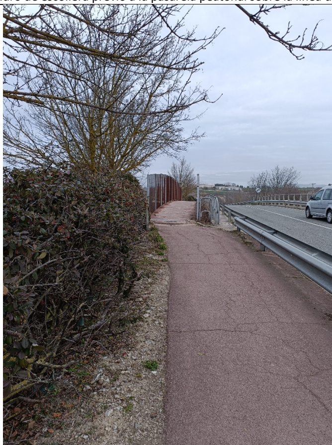
5. Pasarela peatonal sobre línea de ferrocarril
