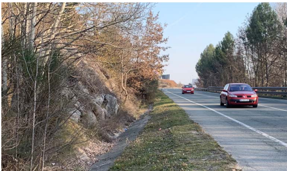
Figura nº 13: Fotografía de una de las dos escolleras existentes en la margen de la NA-2306.
