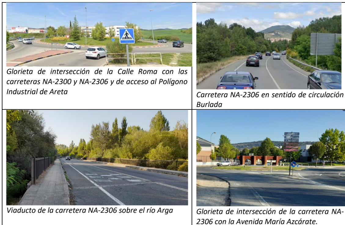
Figura nº 7: Fotografías tramo nº 4, Carretera NA-2306.
