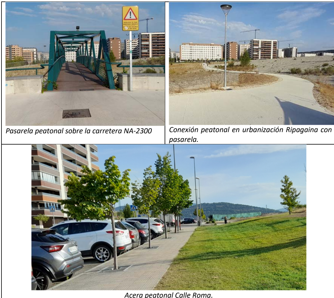
Figura nº 8: Fotografías del estado actual de la conexión con urbanización de Ripagaina.
