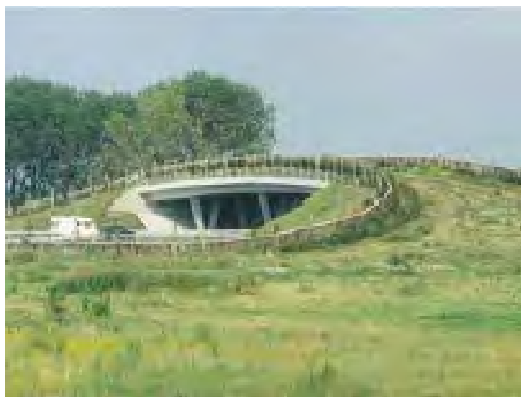
Ilustración 14. Paso situado en un terreno llano, con rampas de acceso con ligera pendiente. Foto: P. Farkas.
