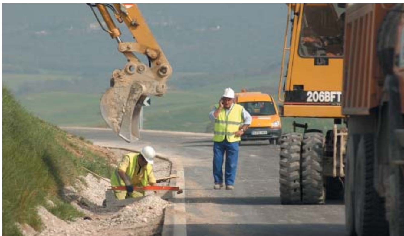
Bajo estas líneas, obras de conservación en las inmediaciones de Ucar.
