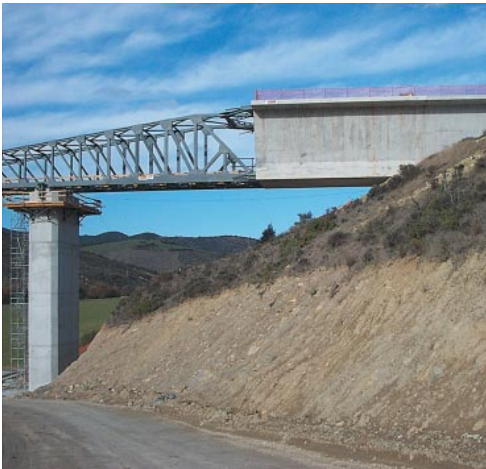
Imágenes de la construcción del acueducto de Gurpegui.
