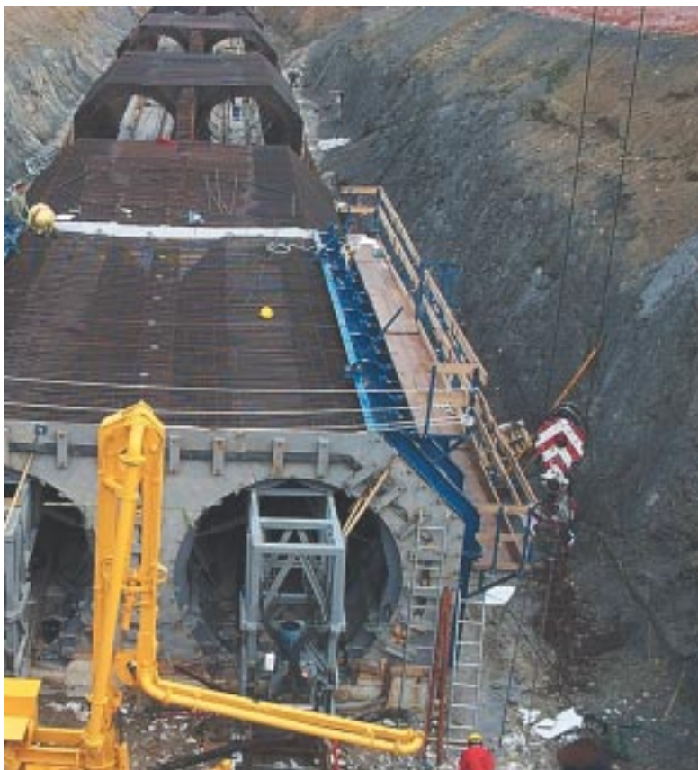
Detalle de la construcción del sifón del río Erro, en el Canal de Navarra.
