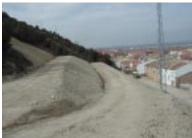
Estabilización de taludes en Lodosa, Peralta y Caparroso.
