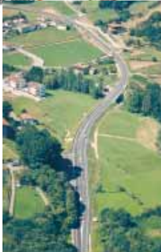
Situación de la obra e imagen del proyecto acabado
