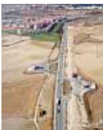
Imagen de la carretera en obras llegando a Mendillorri.
