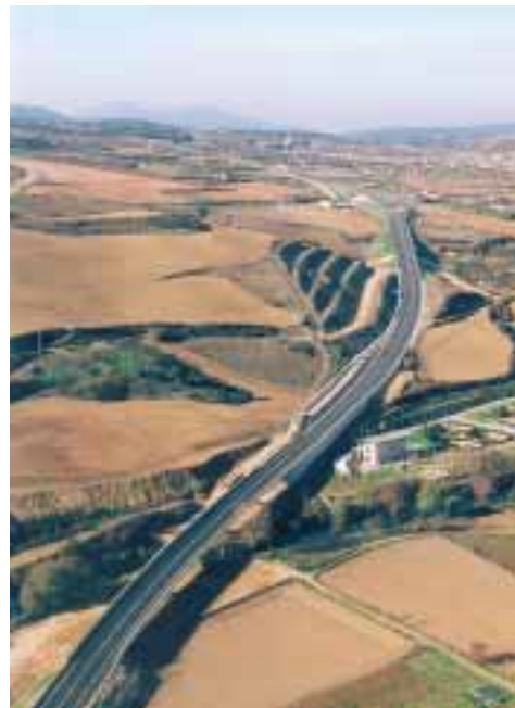
A la derecha de la imagen, la depuradora en la que desemboca el colector principal.
