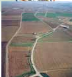
Zona afectada por la obra.
