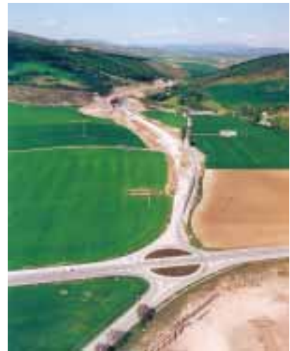
Imagen de la zona afectada por la obra
