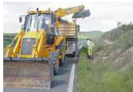
Labores de desbroce y de limpieza de cunetas, trabajos realizados desde la Sección de Conservación.
