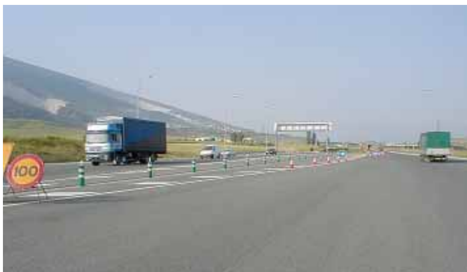
Labores de pintura realizadas desde la Sección de Conservación.
