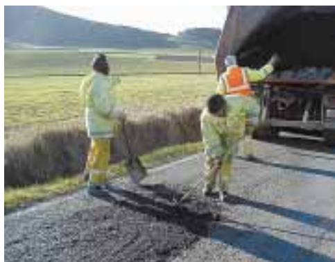
Imágenes en las que se observan labores de refuerzo de firmes y pintura en carreteras navarras.
