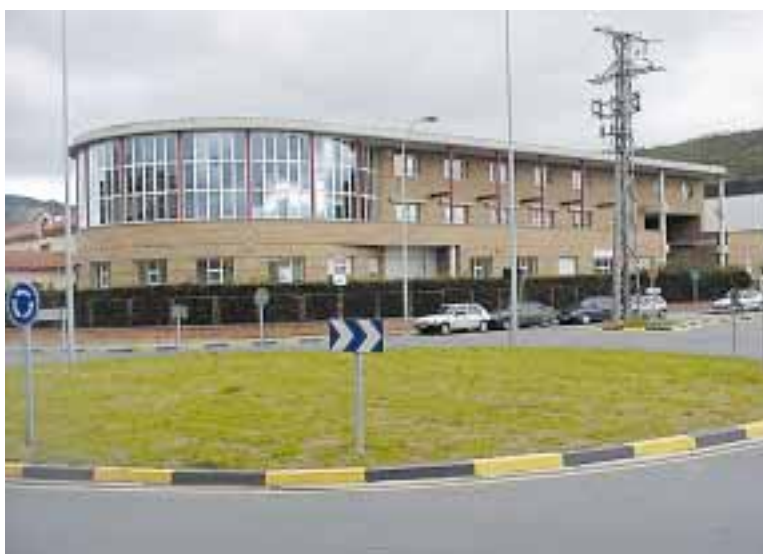
Vista general del edificio que ocupa el Laboratorio de Control de Calidad, fachadas Sur y Este.
