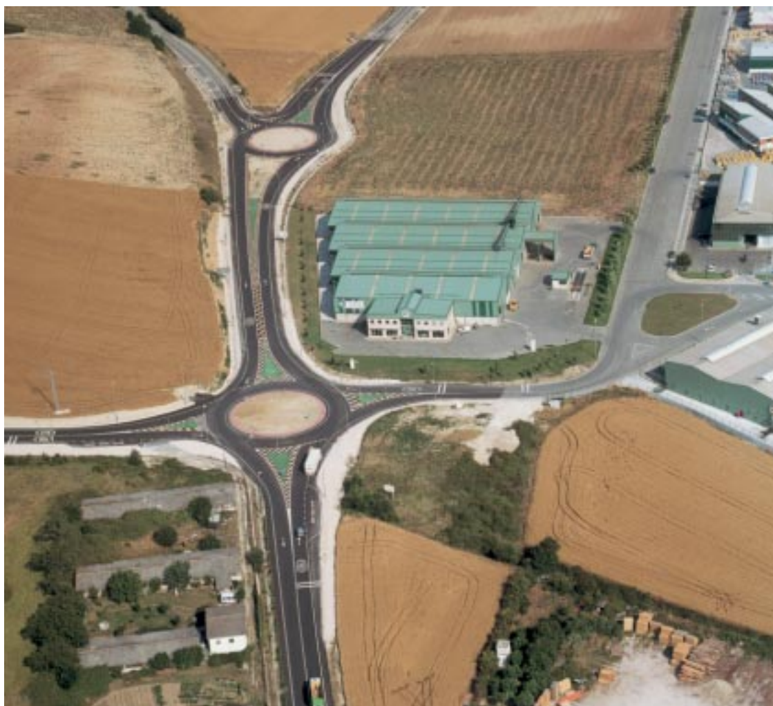
Acceso a Egüés e intersección entre la Clínica Ubarmin y el polígono de Egüés.
