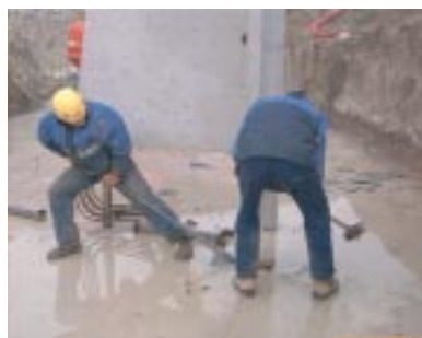
Construcción de dos pasarelas peatonales en la Ronda Este de Pamplona Arriba, a la izquierda: montaje de paneles prefabricados, operaciones de desenganche del panel de la grúa una vez aplomado.
