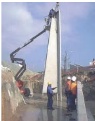
Construcción de dos pasarelas peatonales en la Ronda Este de Pamplona Arriba, a la izquierda: montaje de paneles prefabricados, operaciones de desenganche del panel de la grúa una vez aplomado.
