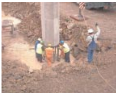
Arriba: montaje de marcos prefabricados en la ampliación del paso de la regata en Cordovilla. Obra de modificación de acceso Sur a Pamplona.
