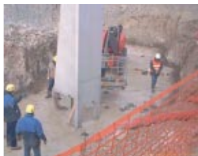
Derecha (arriba): montaje de paneles prefabricados, acceso a coronación mediante el empleo de plataforma telescópica.
