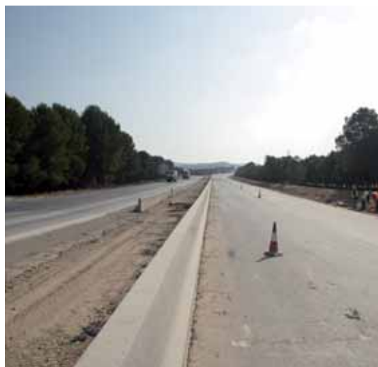
Autovía A-68: Castejón-Tudela
