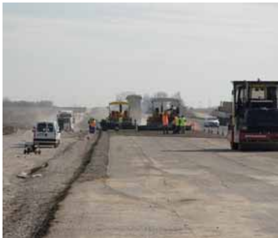
Autovía A-68: Buñuel-Cortes
