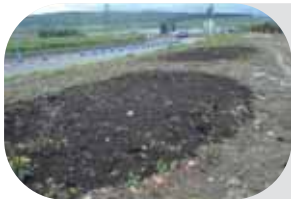
Actuación Enlaces de Noáin-Tajonar y Pamplona Sur-Ronda Oeste
