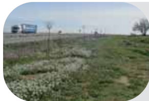
Actuación Calzada en la carretera N-232 (Variante de Tudela)
